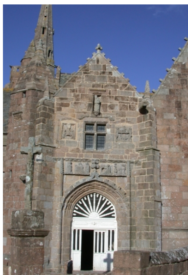
Porche sud, vue générale Phot. Patrick Pichouron IVR53_20072205581NUCA
