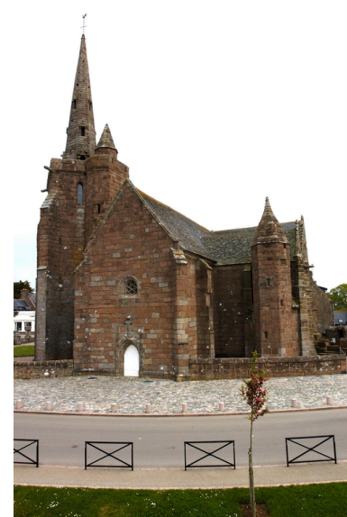
Vue générale depuis l'ouest Phot. Norbert Lambart IVR53_20072200253NUCA
