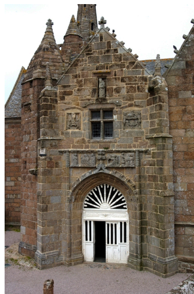
Porche sud, vue générale Phot. Norbert Lambart IVR53_20072200250NUCA
