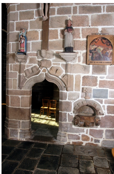
Porte de la chapelle de Lannion Phot. Norbert Lambart IVR53_20072200245NUCA
