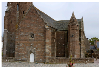
Vue générale depuis l'ouest Phot. Norbert Lambart IVR53_20072200254NUCA
