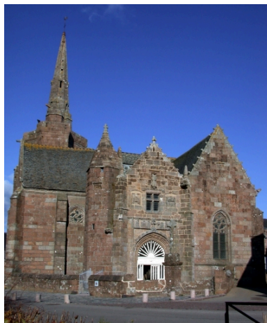
Vue générale (élévation sud) Phot. Patrick Pichouron IVR53_20072205489NUCA
