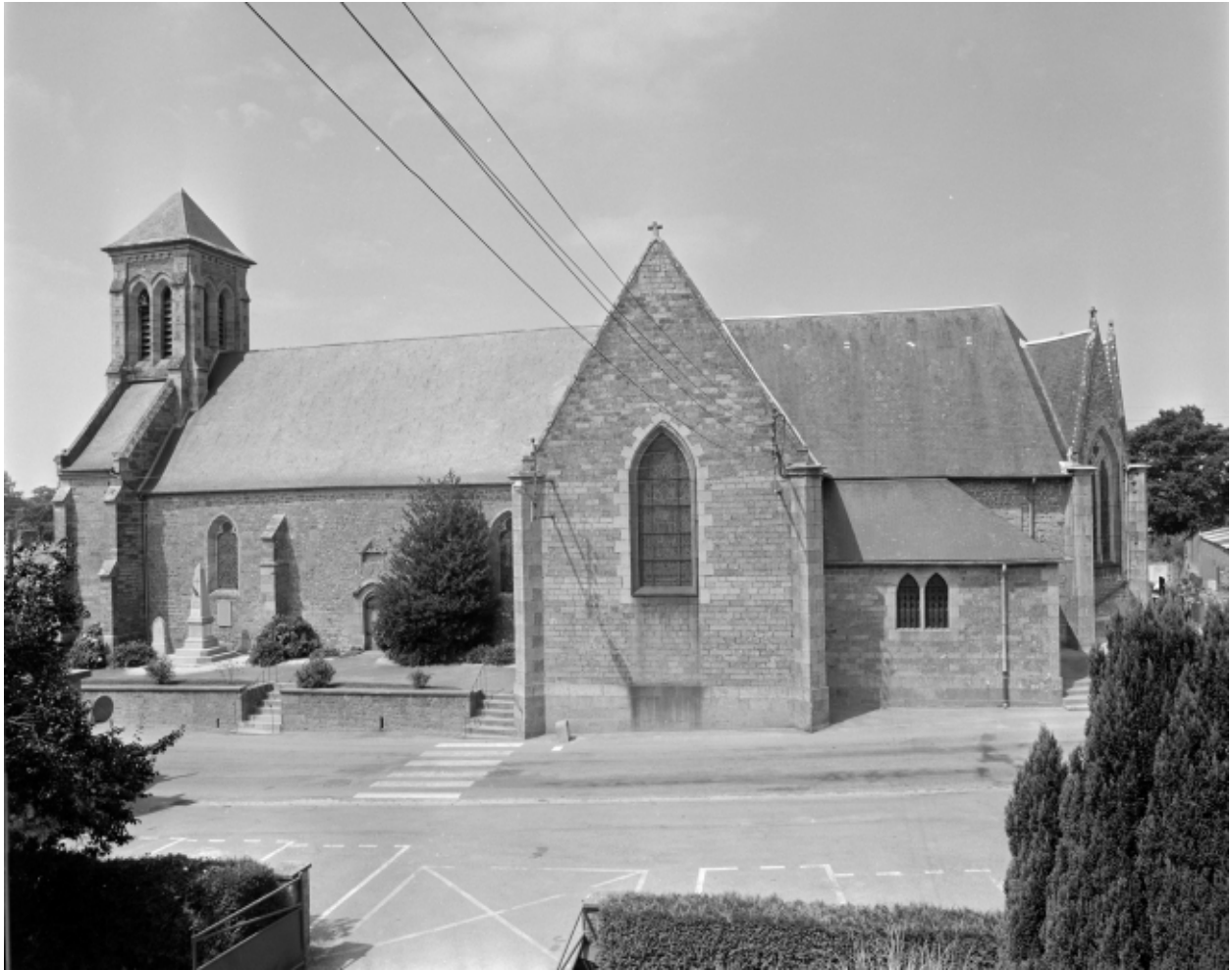
Elévation Sud : vue générale
