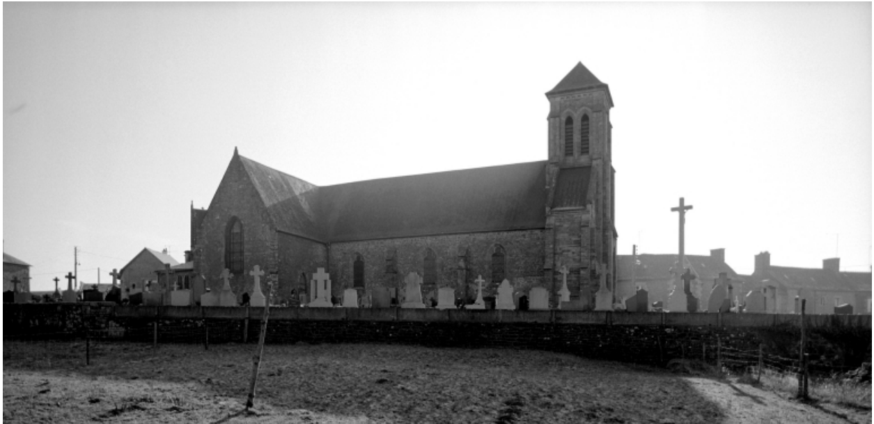
Elévation Nord : vue générale
