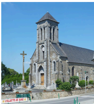
Elévation sud-ouest Phot. Norbert Lambart IVR53_20133501507NUCA
