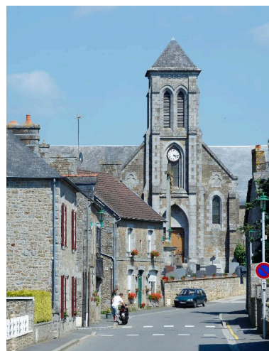
Vue de l'église depuis la rue principale Phot. Norbert Lambart IVR53_20133501508NUCA
