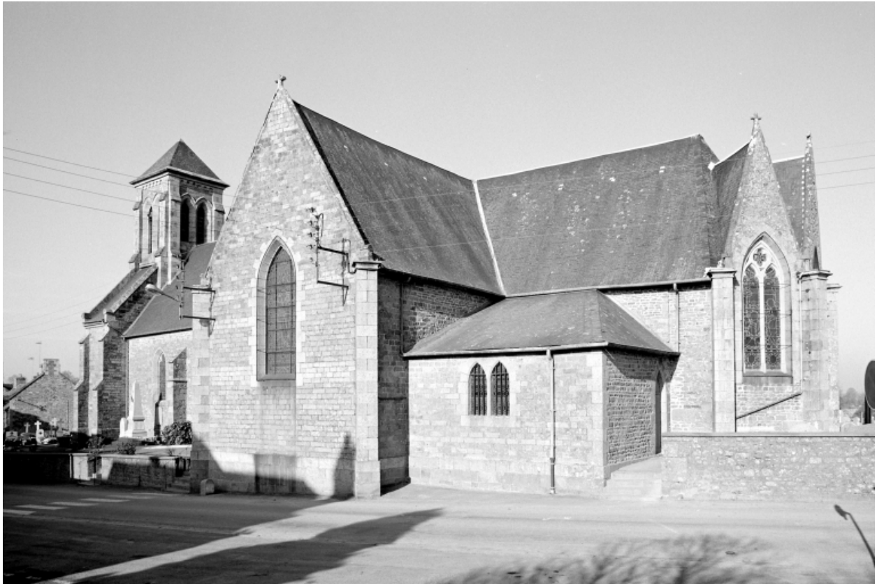
Elévation Sud-Est : vue générale
