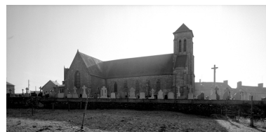
Elévation Nord : vue générale Phot. Bernard Bègne, Phot. M. Loyon IVR53_19933500603X
