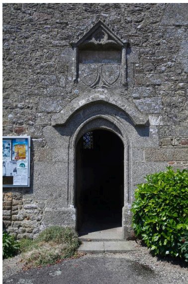
Porte ancienne, façade ouest Phot. Norbert Lambart IVR53_20133501501NUCA
