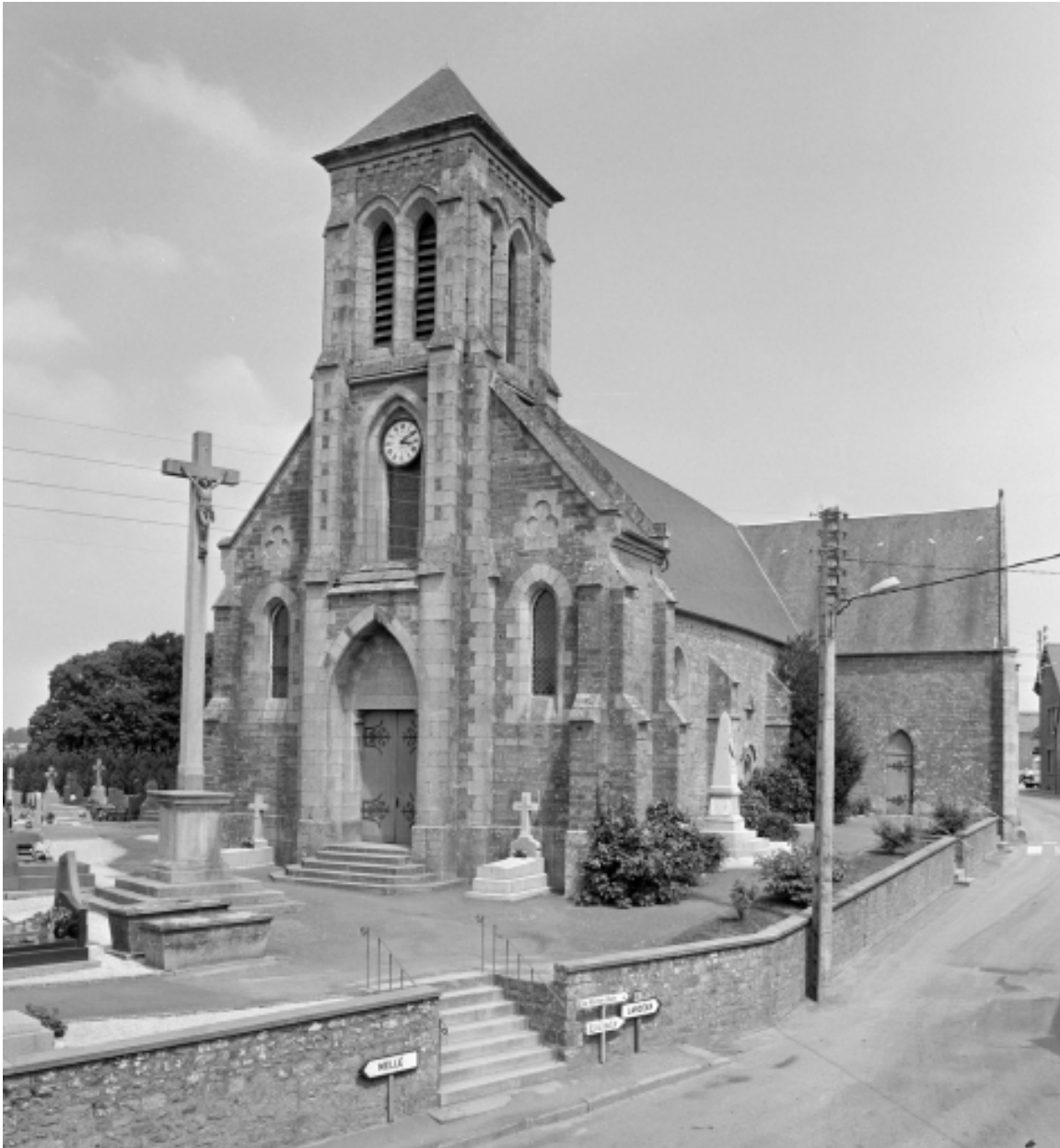
Elévation Sud-Ouest : vue générale
