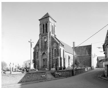
Elévation Sud-Ouest : vue générale Phot. Guy Artur, Phot. Norbert Lambart IVR53_19933500602X
