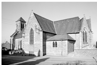
Elévation Sud-Est : vue générale Phot. Guy Artur, Phot. Norbert Lambart IVR53_19933500601X
