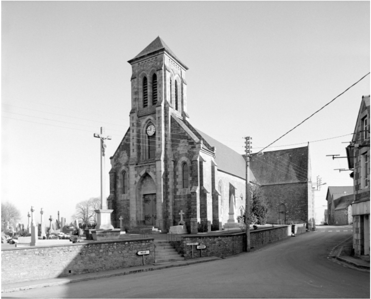
Elévation Sud-Ouest : vue générale
