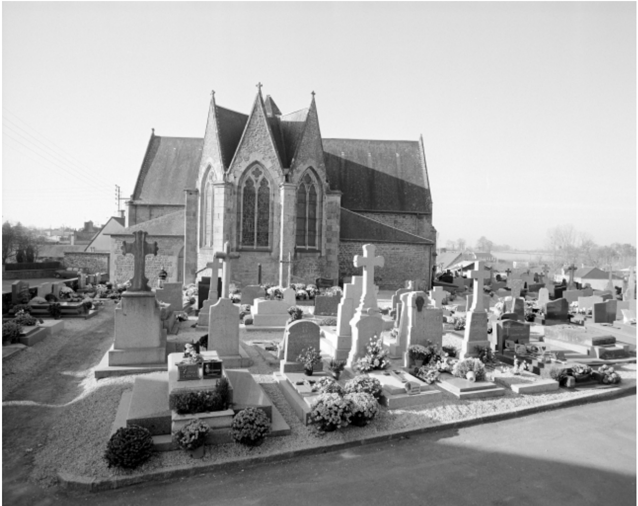
Elévation Est : vue générale
