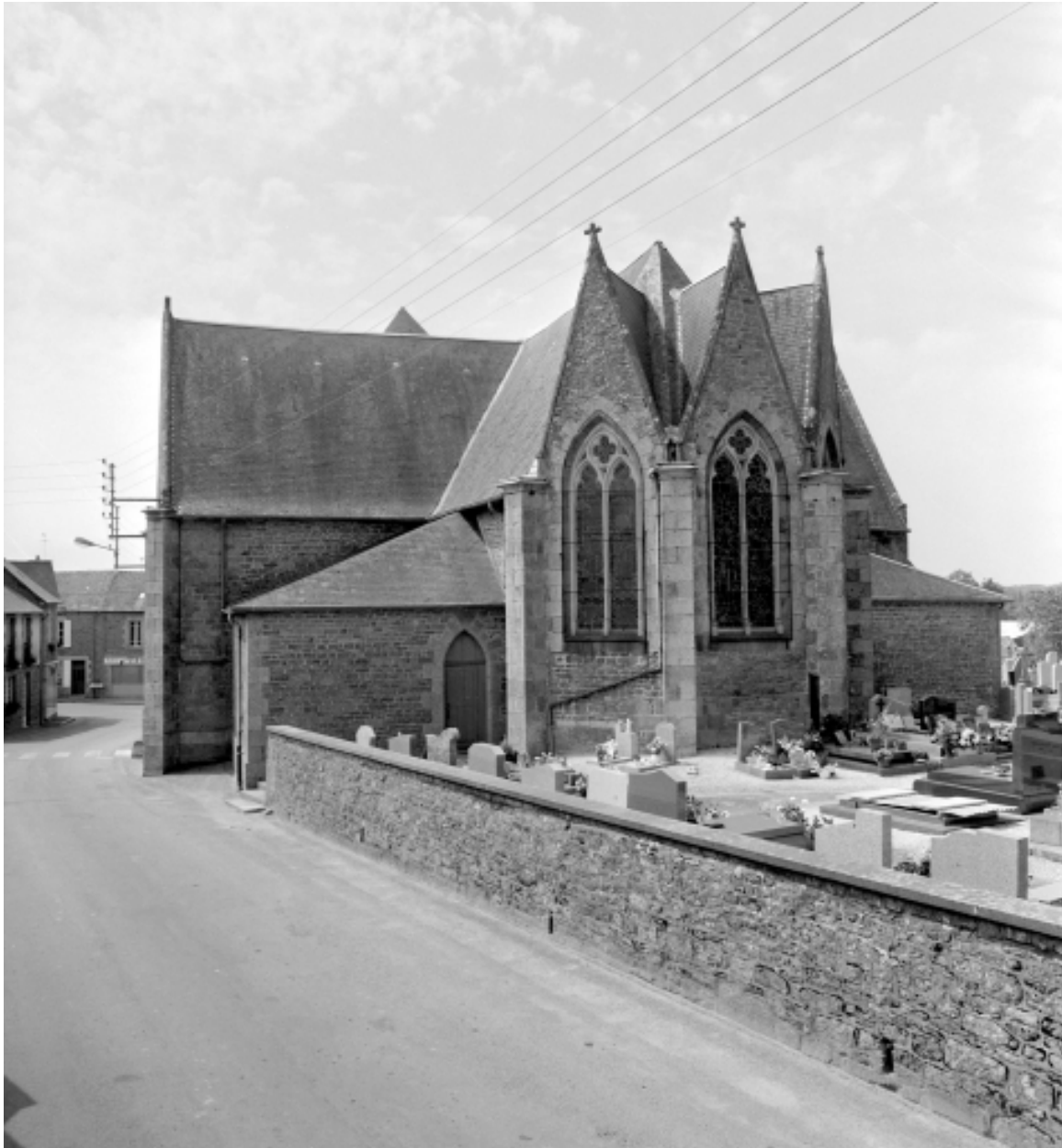
Elévation Est : vue générale
