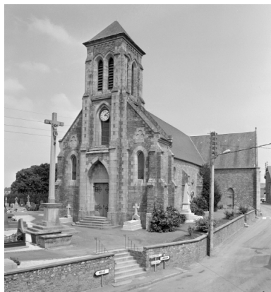
Elévation Sud-Ouest : vue générale Phot. Guy Artur, Phot. Norbert Lambart IVR53_19943501460X
