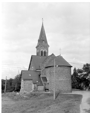
Vue générale est
