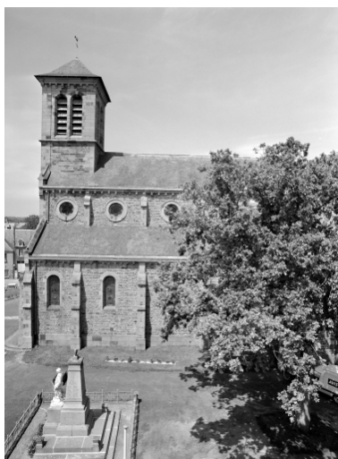
Elévation Sud, partie Ouest : vue générale Phot. Guy Artur, Phot. Norbert Lambart IVR53_19943501013X
