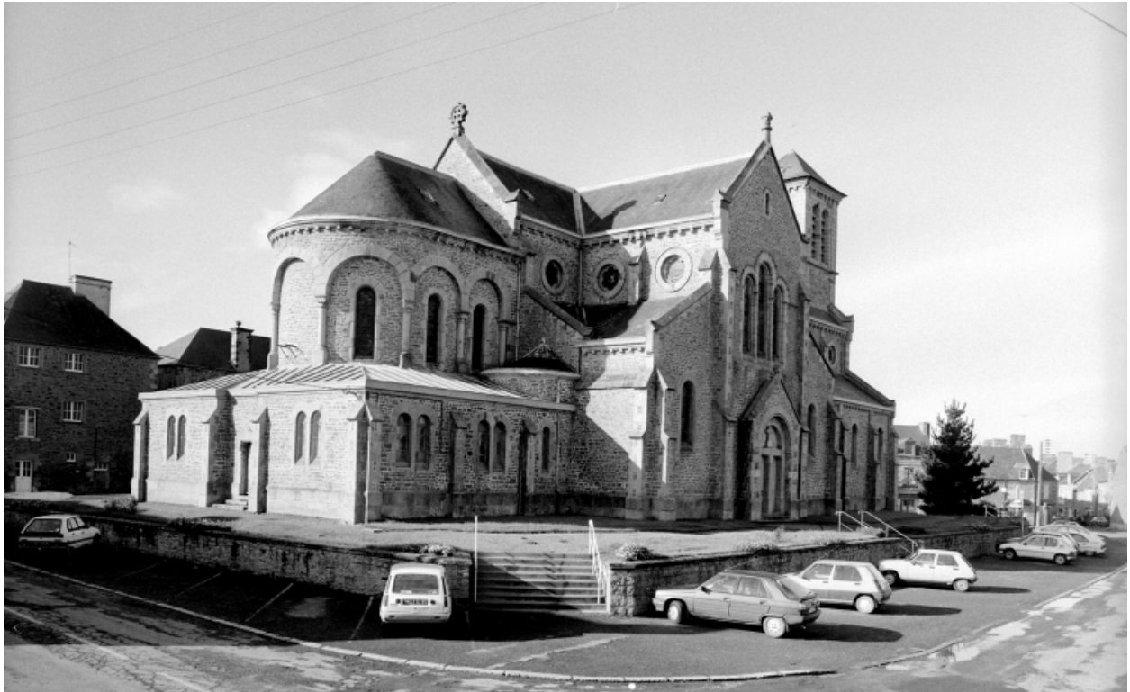
Elévation Nord-Est : vue générale
