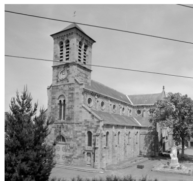
Elévation Sud-Ouest : vue générale Phot. Guy Artur, Phot. Norbert Lambart IVR53_19943501014X
