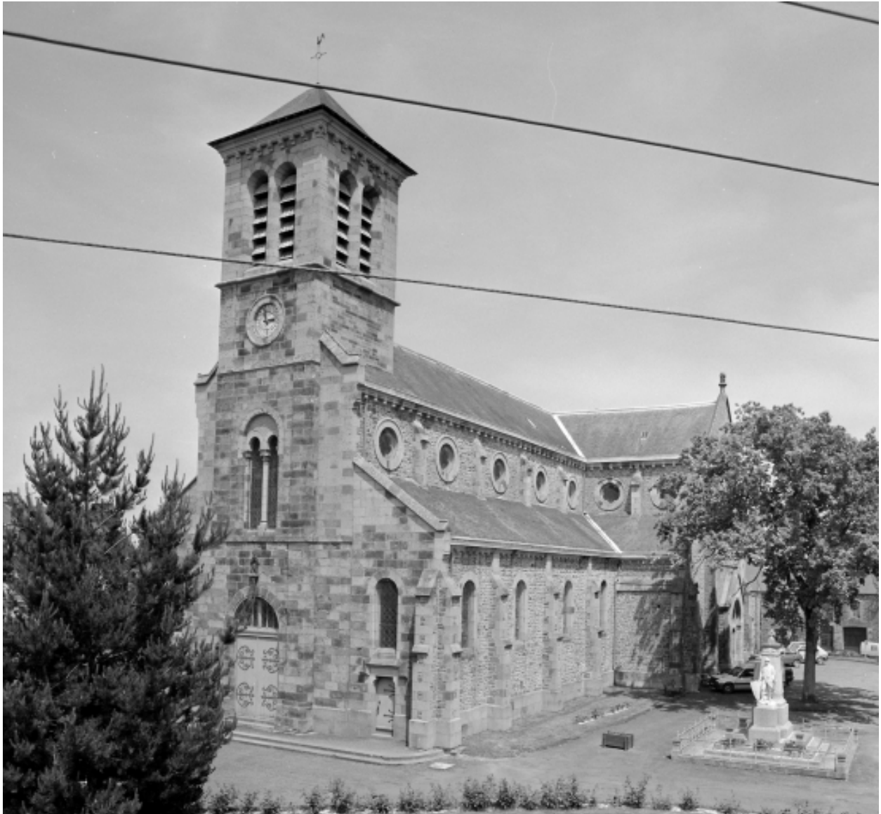
Elévation Sud-Ouest : vue générale
