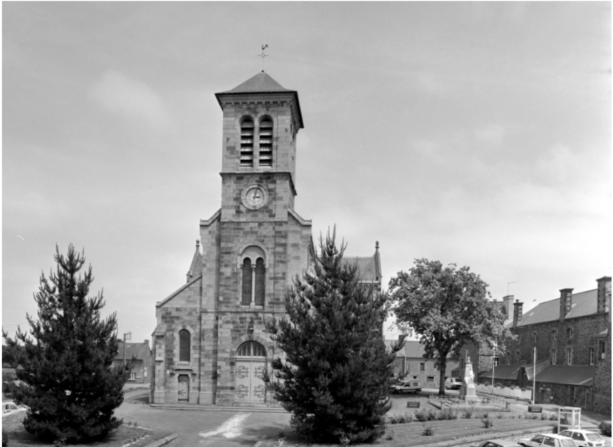
Elévation Ouest : vue générale
