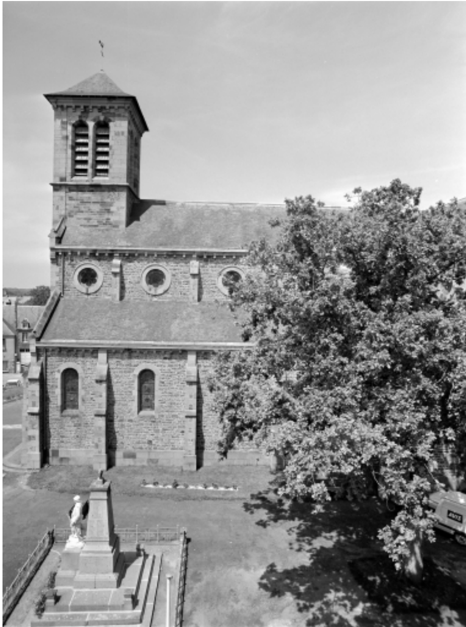
Elévation Sud, partie Ouest : vue générale
