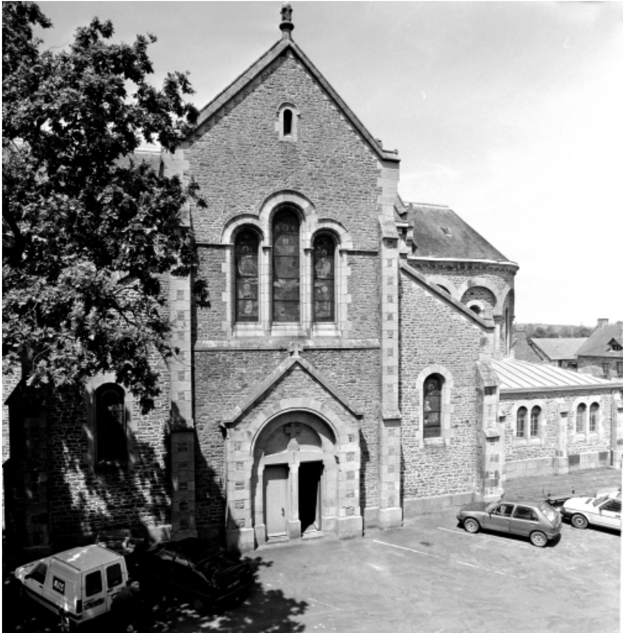
Elévation Sud, porte : vue générale
