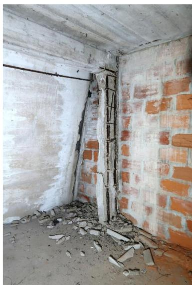
Deuxième étage : pilier en béton armé corrodé
