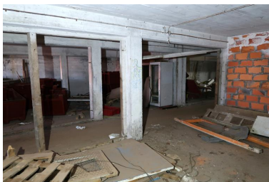
Premier étage : extrémité nord, marquage "U 123" (box 28) Phot. Guillaume Lécueillier IVR53_20225606227NUCA
