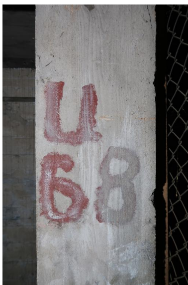
Rez-de-chaussée : marquage "U68" (box 7) Phot. Guillaume Lécueillier IVR53_20225606205NUCA
