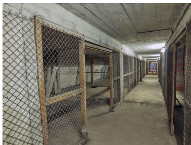
Vue de l'un des cinq niveaux de stockage Phot. Bernard Bègne IVR53_20215600456NUCA
