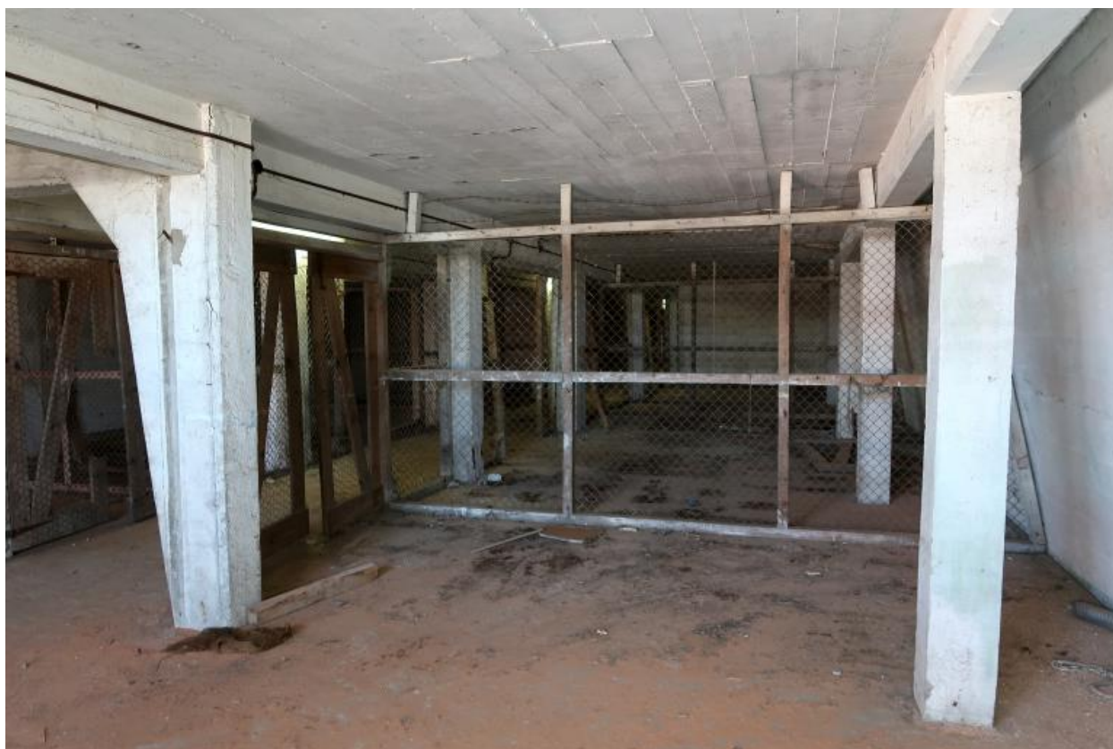
Deuxième étage : extrémité nord, grillage surmonté de deux rangs de fil barbelé séparant deux boxes
