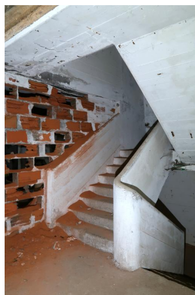
Escalier entre le premier et le deuxième étage (troisième niveau) Phot. Guillaume Lécueillier IVR53_20225606239NUCA
