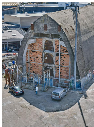
Vue générale depuis le nord : pignon percé de quatre portes Phot. Bernard Bègne IVR53_20215600451NUCA
