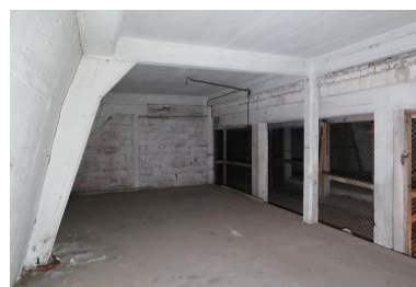
Premier étage : extrémité sud, box 35 Phot. Guillaume Lécueillier IVR53_20225606240NUCA
