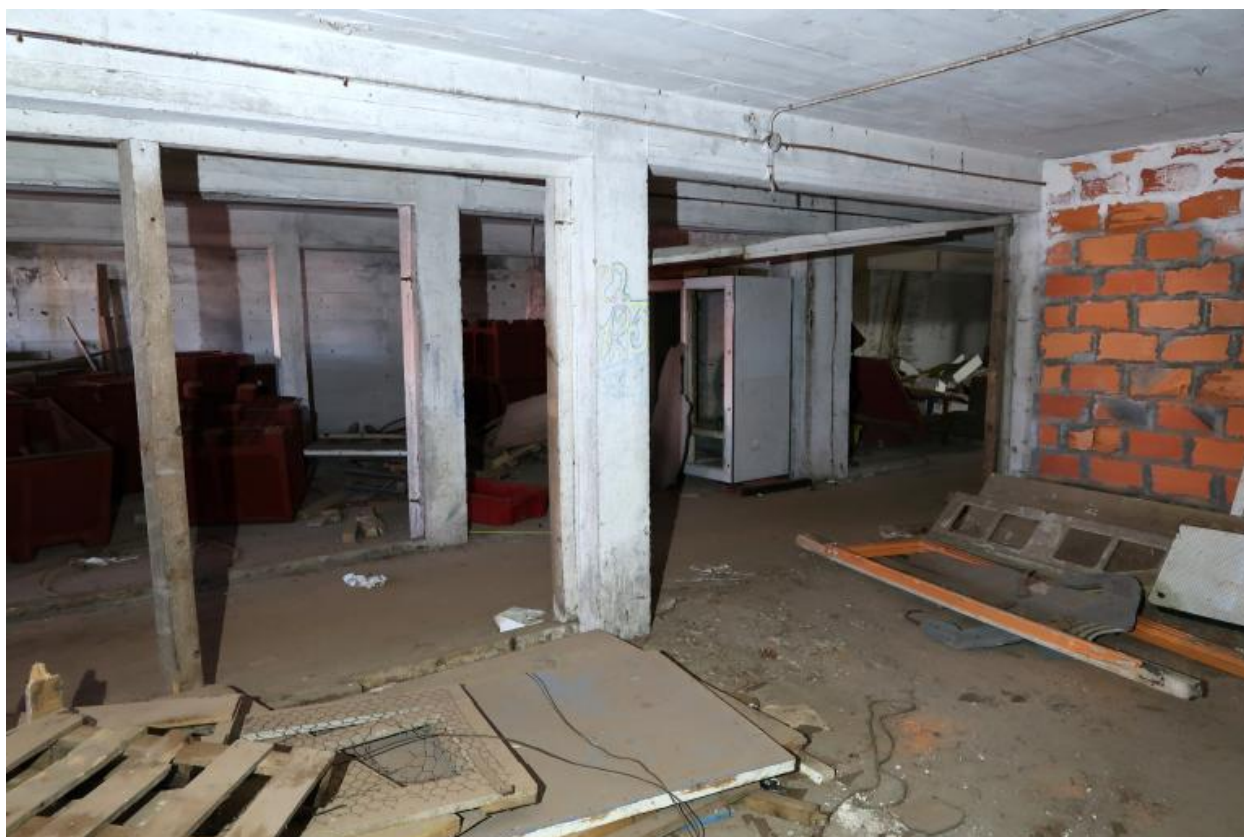
Premier étage : extrémité nord, marquage "U 123" (box 28)
