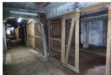
Rez-de-chaussée : couloir central vers le sud depuis l'extrémité nord Phot. Guillaume Lécueillier IVR53_20225606214NUCA
