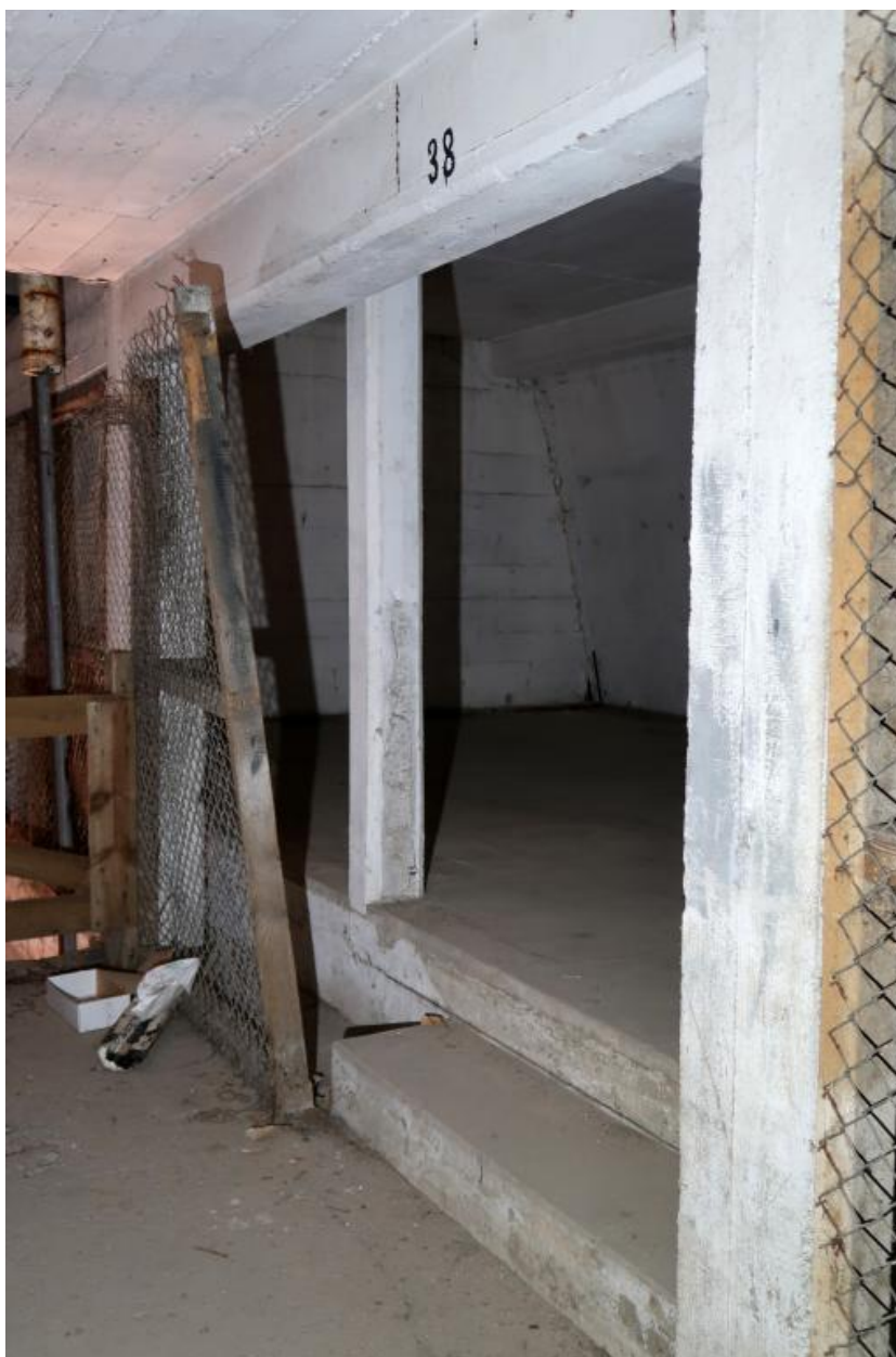
Premier étage : extrémité sud, box 38
