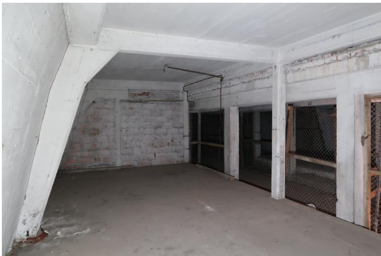
Premier étage : extrémité sud, box 35
