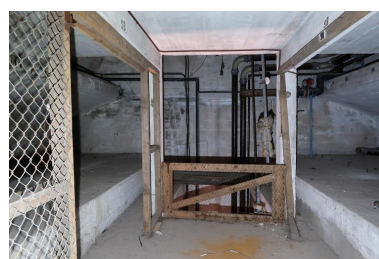
Troisième étage (quatrième niveau) : extrémité sud, couloir central desservant les boxes (boxes 53 et 58) Phot. Guillaume Lécueillier IVR53_20225606255NUCA
