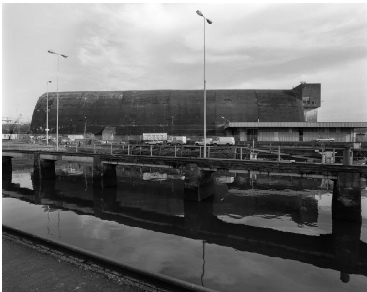
Vue générale ouest en 2000. Au premier plan, la cale du slipway
