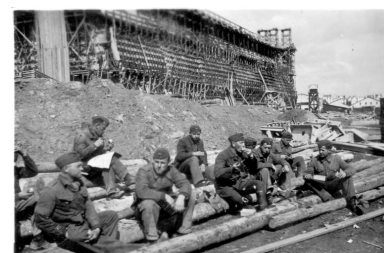
Vue de la construction de l'un des deux Dom-bunkers : étape du coffrage en béton armé, avril 1941 (photographie non attribuée provenant du Fonds Crolard et achetée par les Archives municipales de Lorient, disponible sous les cotes 5Fi6112 et 9Fi2804 [image inversée]). Au premier plan, travailleurs (?) lors de la pause ; à l'arrière plan, on aperçoit un mirador Phot. Anonyme IVR53_20225606301NUCA
