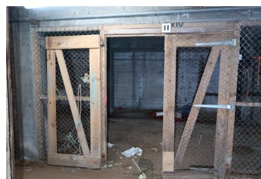
Rez-de-chaussée : marquage "U 129" [porte] (box 11) Phot. Guillaume Lécueillier IVR53_20225606208NUCA
