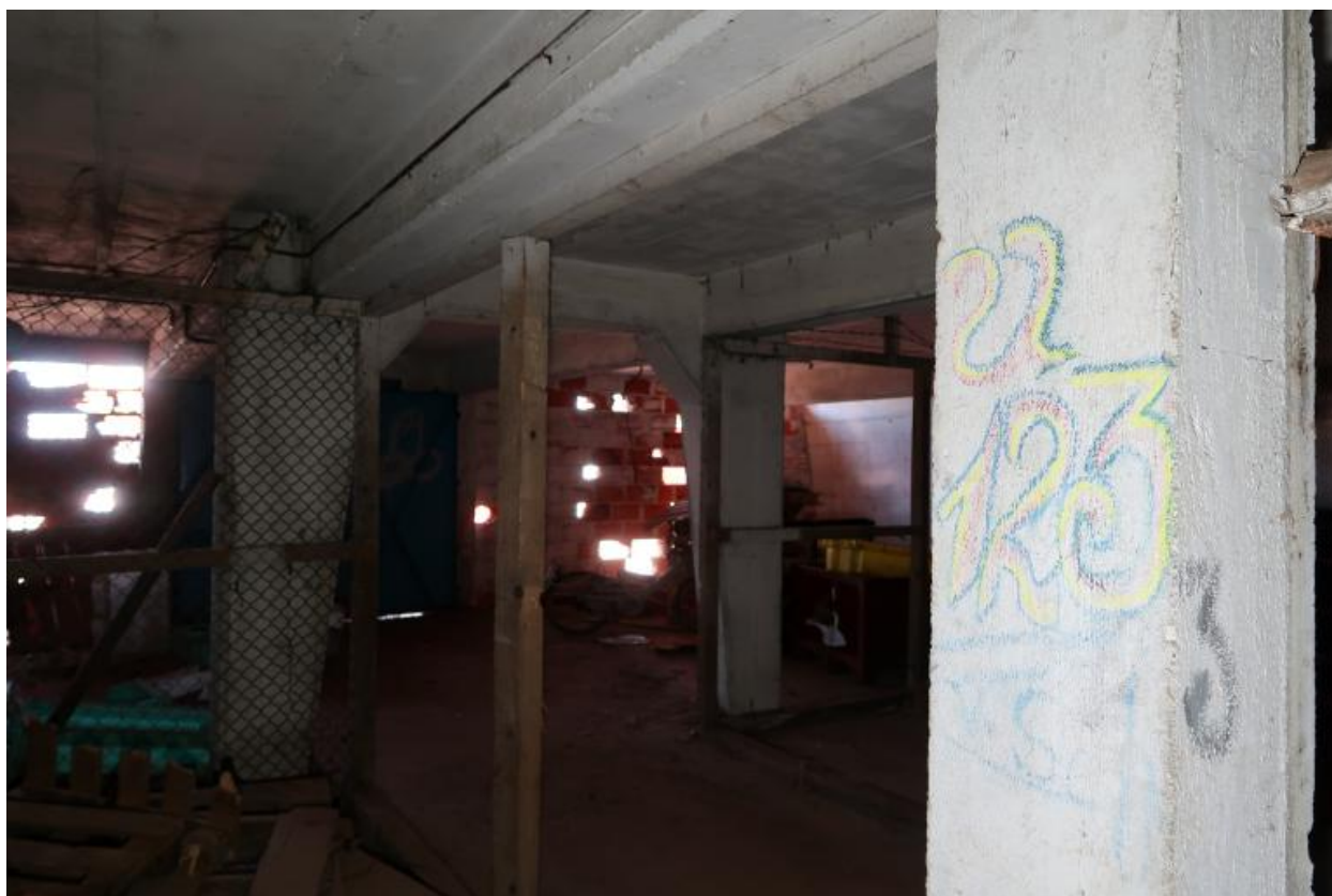
Premier étage : extrémité nord, marquage "U 123" (box 28)
