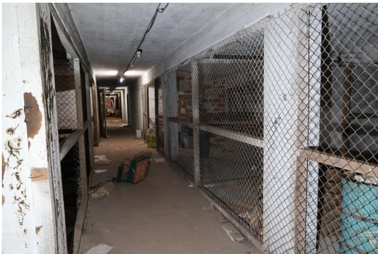
Premier étage : couloir central desservant les boxes
