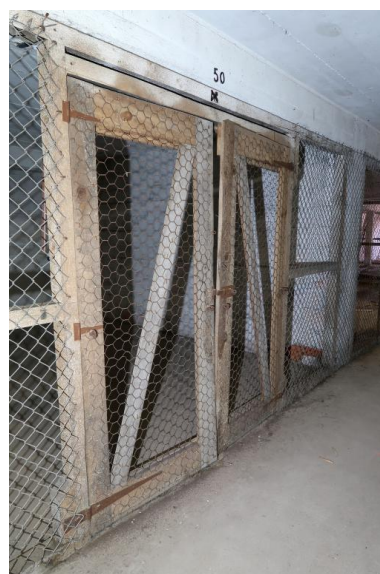
Deuxième étage : box 55 avec ses portes d'origine (pentures, ferrures et dispositifs de fermeture) Phot. Guillaume Lécueillier IVR53_20225606243NUCA
