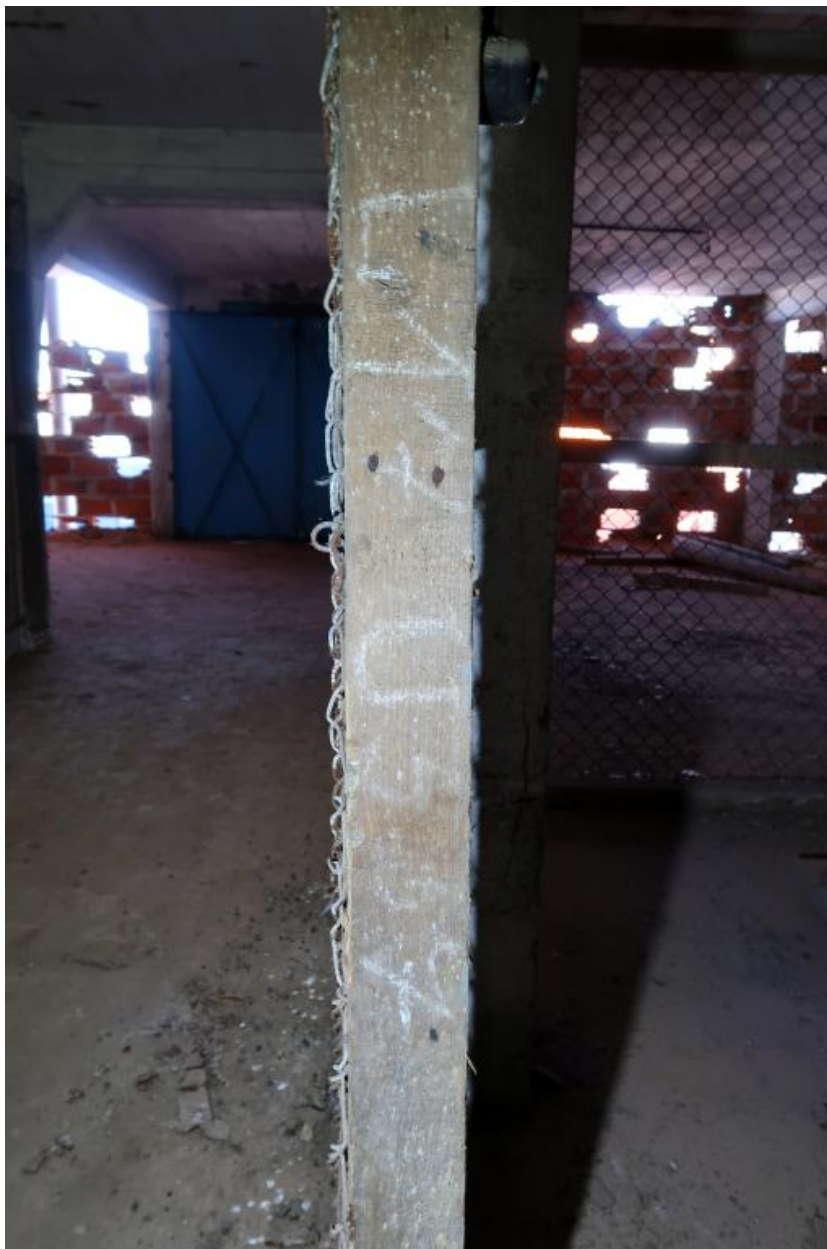
Deuxième étage : marquage "[?] 17" "U 557"
