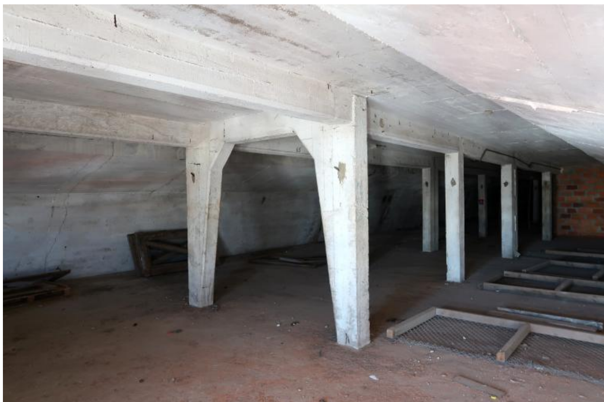
Troisième étage (quatrième niveau) : extrémité nord
