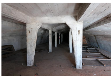
Troisième étage (quatrième niveau) : extrémité nord Phot. Guillaume Lécueillier IVR53_20225606290NUCA
