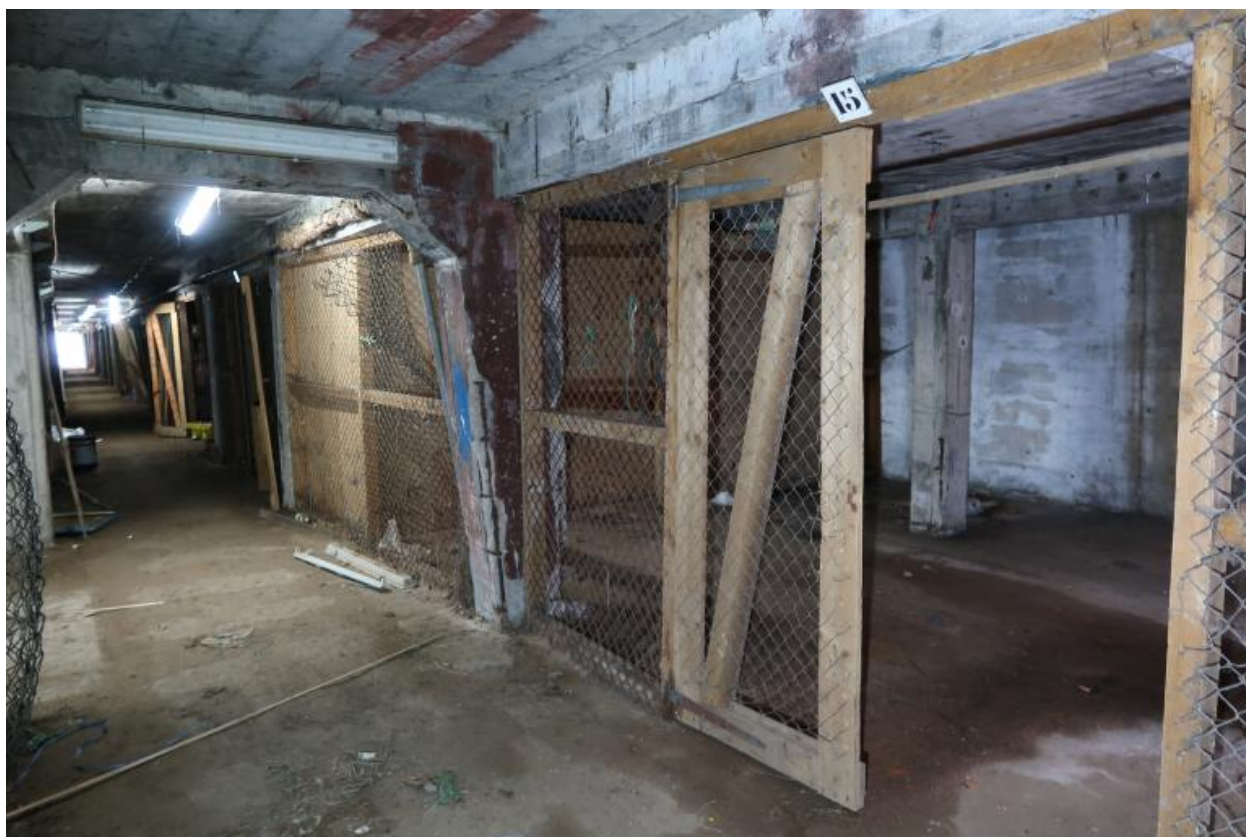
Rez-de-chaussée : couloir central vers le sud depuis l'extrémité nord
