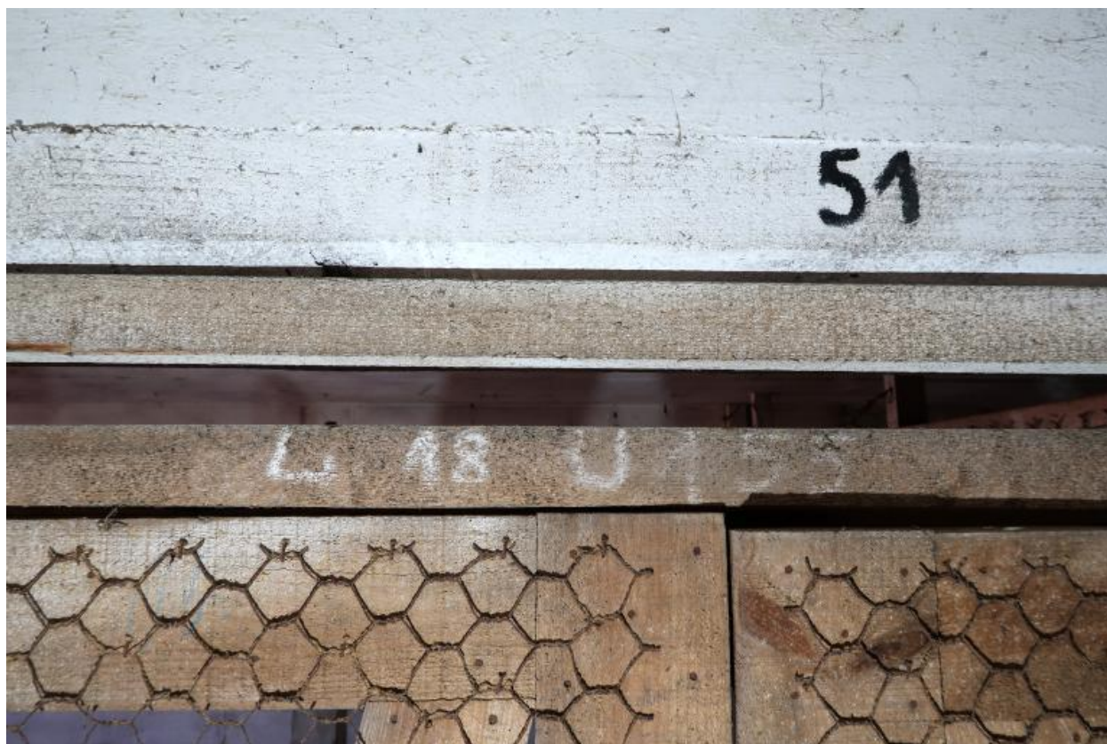
Deuxième étage : marquage "[?] 18" "U 155" (box 55)
