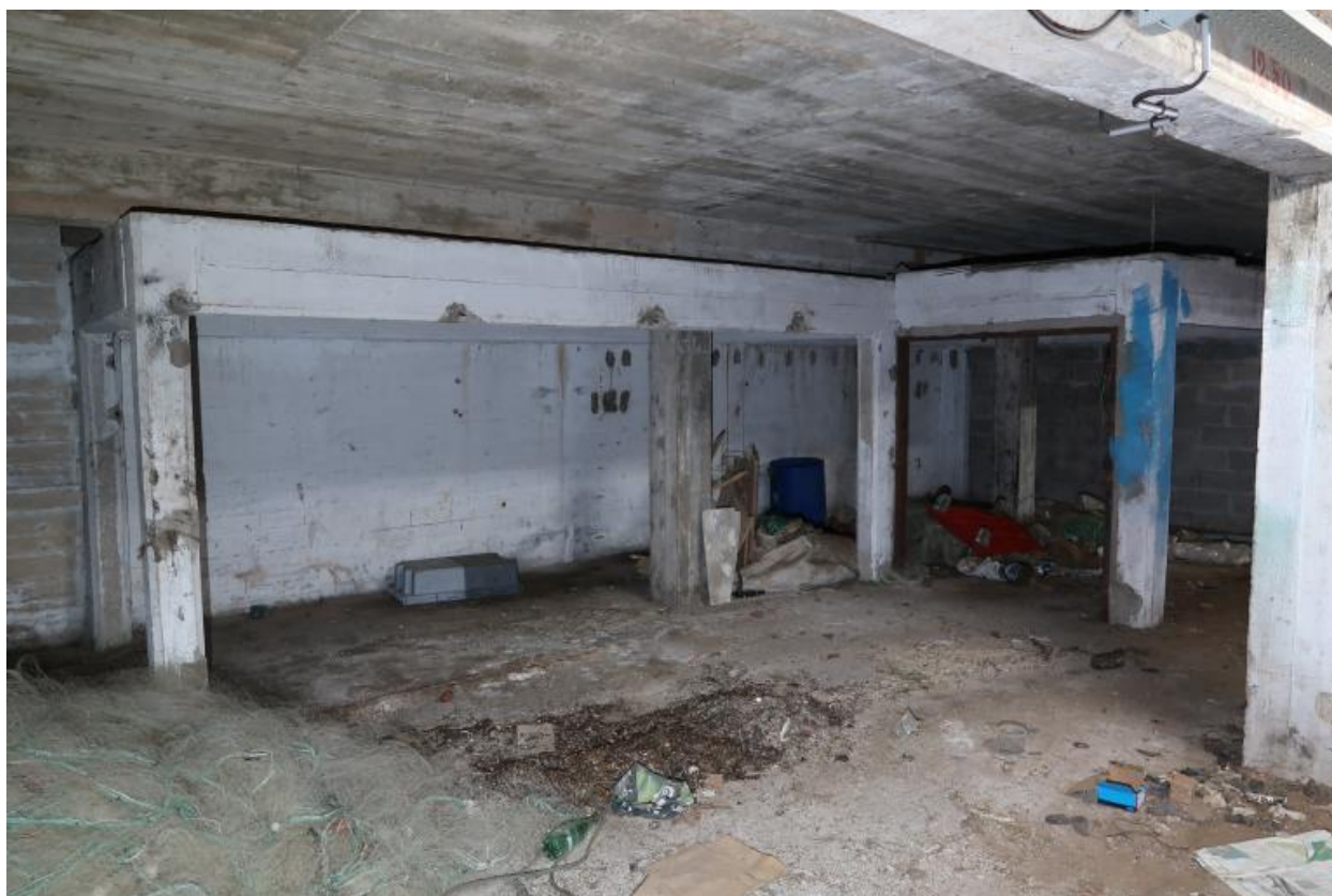
Rez-de-chaussée : extrémité sud (emplacement des ateliers)
