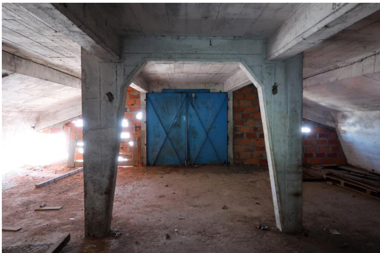
Troisième étage (quatrième niveau) : extrémité nord
