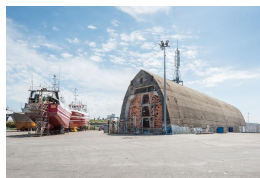
Vue générale depuis le nord. Au premier plan, le terre-plein de l'aire de réparation navale du port de pêche. A gauche, deux chalutiers en entretien Phot. Charlotte Barraud IVR53_20215600568NUCA
