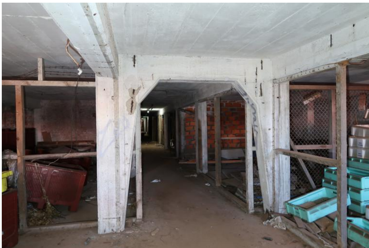
Premier étage : extrémité nord
