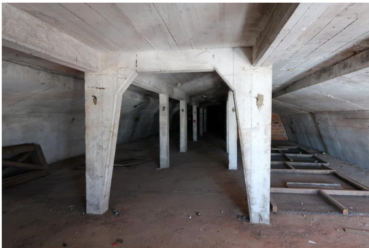
Troisième étage (quatrième niveau) : extrémité nord
