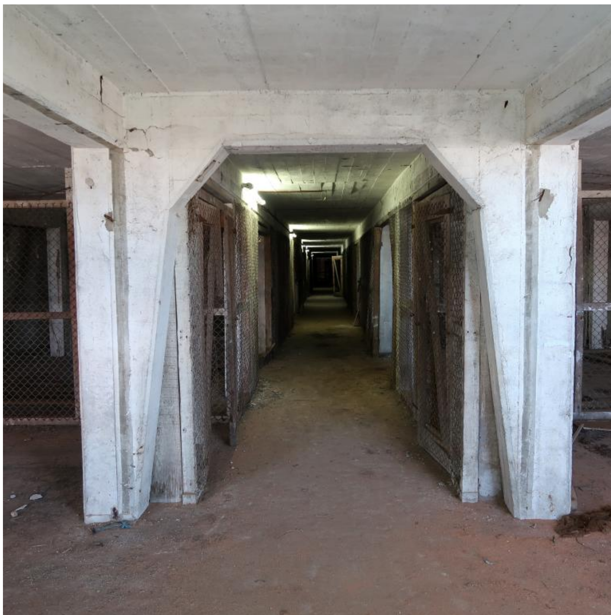
Deuxième étage (troisième niveau) : extrémité nord, couloir central desservant les boxes
