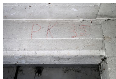
Premier étage : marquage "PK 35" (box 21). "PK" est l'abréviation en allemand de "Propaganda Kompanie", "compagnie de propagande" Phot. Guillaume Lécueillier IVR53_20225606237NUCA
