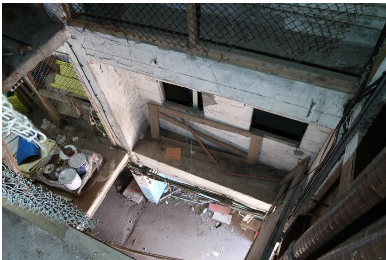
Premier étage : extrémité sud (emplacement des ateliers, bureaux et magasins)
