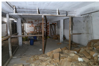
Premier étage : grillage surmonté de deux rangs de fil barbelé séparant deux boxes (box 28) Phot. Guillaume Lécueillier IVR53_20225606226NUCA
