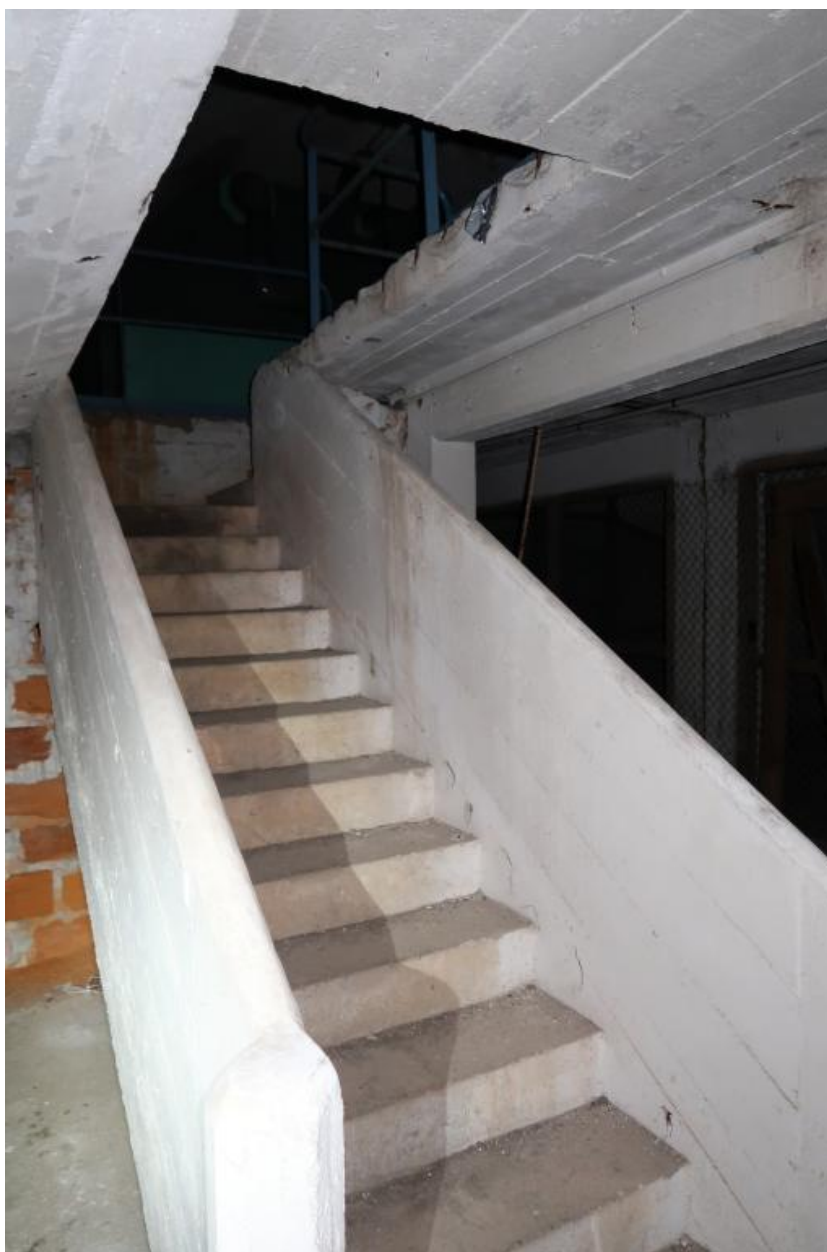
Troisième étage (quatrième niveau) : escalier droit donnant accès au quatrième étage (cinquième niveau)
