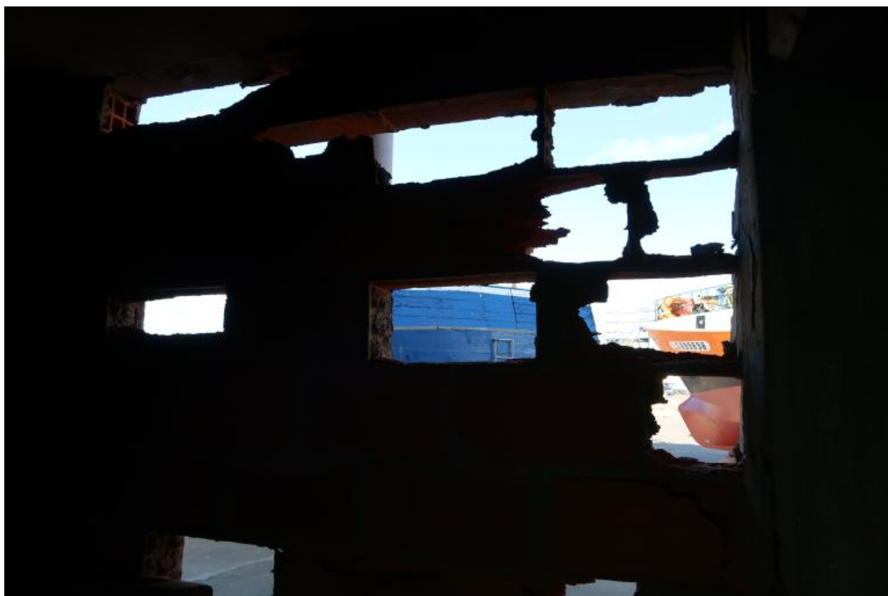
Premier étage : pignon nord en brique creuse
