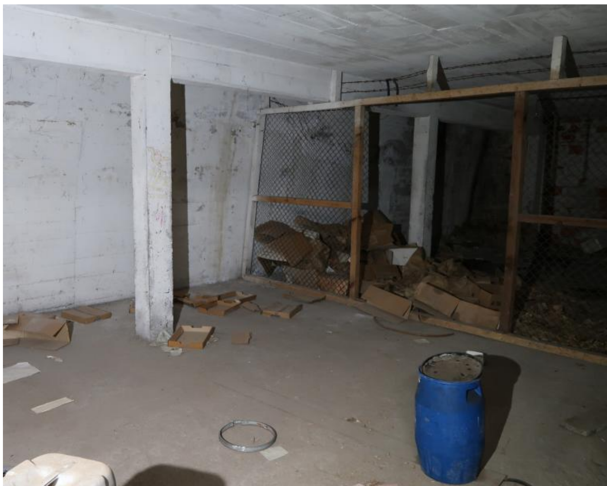
Premier étage : marquage "U 123" et blason d'unité (box 5 [barré] 26)
