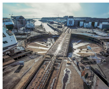
Vue générale de l'aire de réparation navale en 2000. Au centre, le slipway avec son pont basculant et tournant. De part et d'autre de la cale du slipway, les dom-bunkers (à gauche, le dom-bunker est dit "T5") Phot. Bernard Bègne IVR53_20005600557XA
