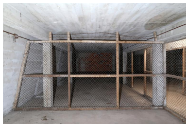
Deuxième étage : grillage surmonté de deux rangs de fil barbelé séparant deux boxes Phot. Guillaume Lécueillier IVR53_20225606251NUCA
