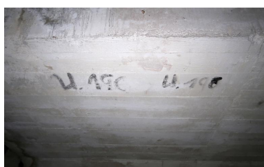
Troisième étage (quatrième niveau) : emplacement des boxes, marquage "U.190" Phot. Guillaume Lécueillier IVR53_20225606294NUCA
