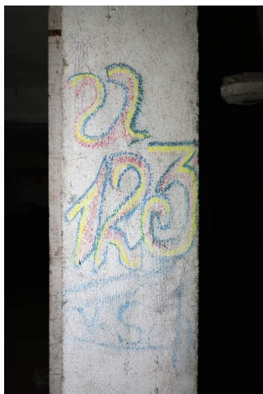
Premier étage : extrémité nord, marquage "U 123" (box 28) Phot. Guillaume Lécueillier IVR53_20225606229NUCA
