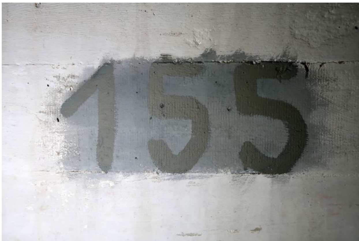
Troisième étage (quatrième niveau) : marquage "155" dans l'un des boxes
