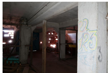
Premier étage : extrémité nord, marquage "U 123" (box 28) Phot. Guillaume Lécueillier IVR53_20225606228NUCA
