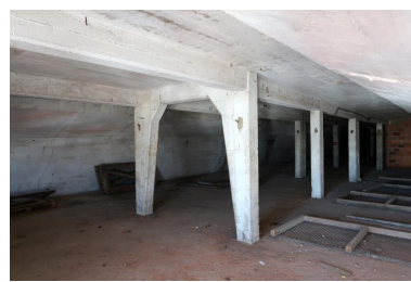
Troisième étage (quatrième niveau) : extrémité nord Phot. Guillaume Lécueillier IVR53_20225606291NUCA
