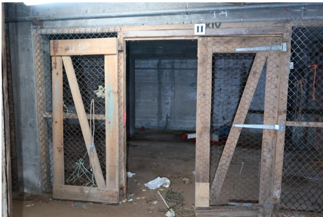
Rez-de-chaussée : marquage "U 129" [porte] (box 11)
