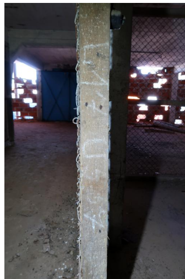
Deuxième étage : marquage "[?] 17" "U 557" Phot. Guillaume Lécueillier IVR53_20225606249NUCA
