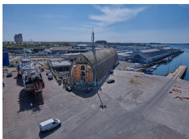
Vue générale depuis le sommet de l'élévateur à bateaux. Le terre-plein accueille des navires pour des opérations de carénage. Dans l'axe du Dom-bunker, le bâtiment frigorifique dit la glacière Phot. Bernard Bègne IVR53_20215600450NUCA
