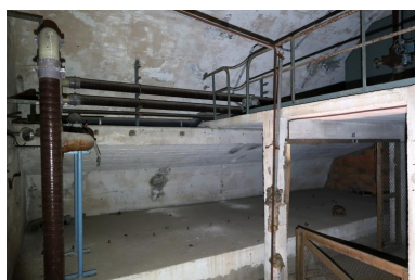
Troisième étage (quatrième niveau) : extrémité sud, cinquième niveau situé sous la voûte Phot. Guillaume Lécueillier IVR53_20225606256NUCA
