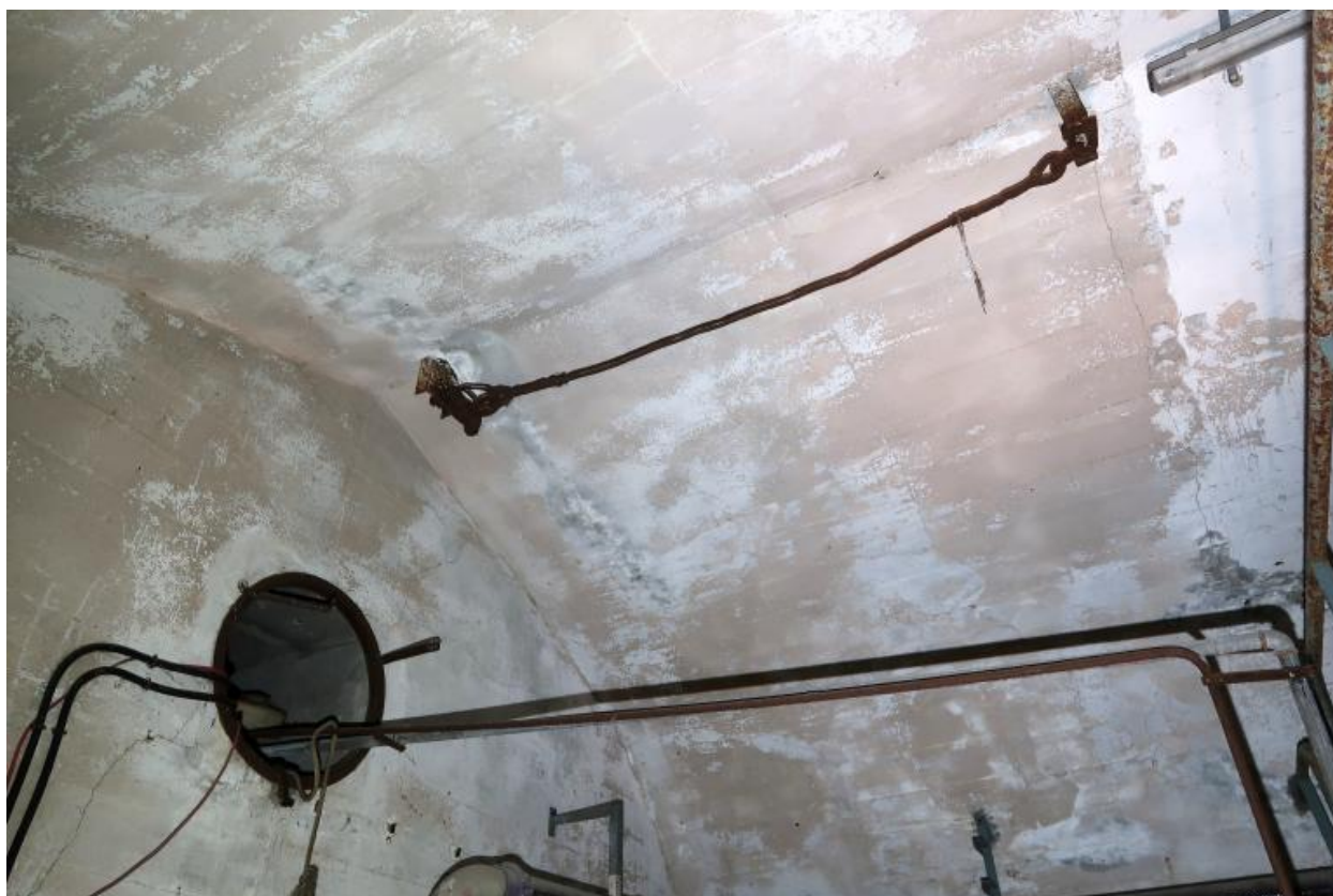
Troisième étage (quatrième niveau) : extrémité sud, détail de la voûte en béton armé
