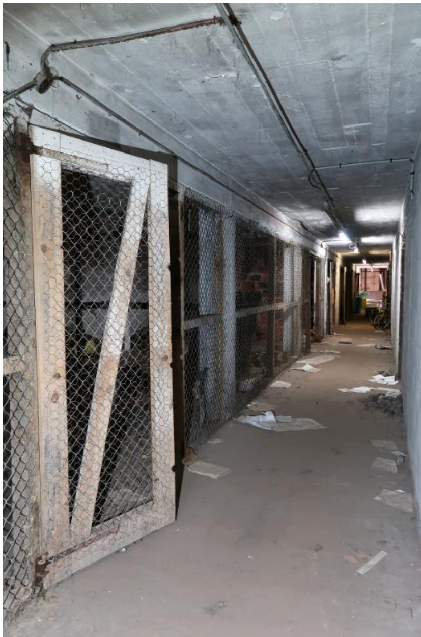
Premier étage : couloir central desservant les boxes
