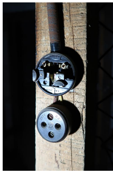
Premier étage : interrupteur et prise de marque SMR 250 V. 5A. Phot. Guillaume Lécueillier IVR53_20225606222NUCA
