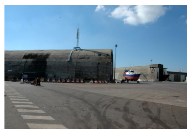
Vue depuis l'est-nord-est (2005). Au premier plan, le terre-plein de l'aire de réparation navale du port de pêche. Au second plan à droite, un chalutier et le "Dom-bunker" ouest dit "T6" Phot. Guillaume Lécueillier IVR53_20055605214NUCA
