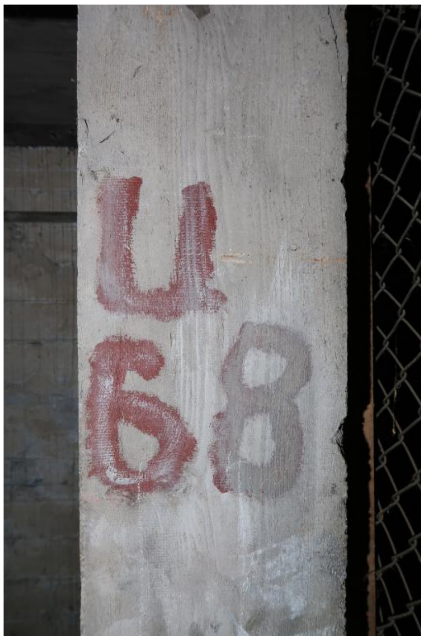
Rez-de-chaussée : marquage "U68" (box 7)
