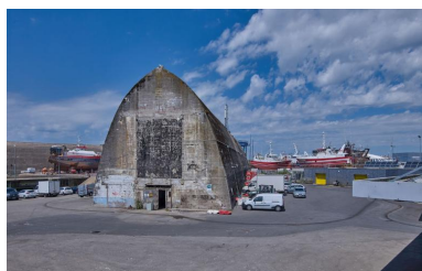
Vue générale depuis le sud-est : pignon percé d'une porte Phot. Bernard Bègne IVR53_20215600452NUCA
