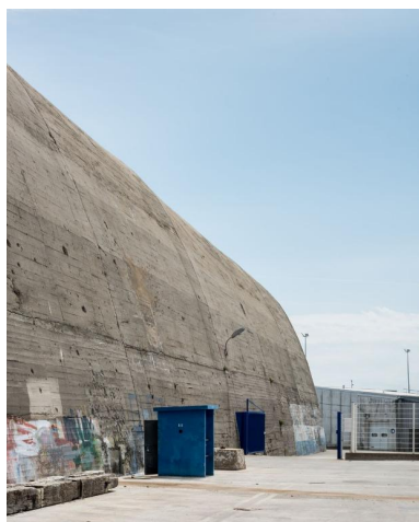
Vue de détail depuis le nord. A droite, le terre-plein et la clôture de l'aire de réparation navale du port de pêche Phot. Charlotte Barraud IVR53_20215600583NUCA
