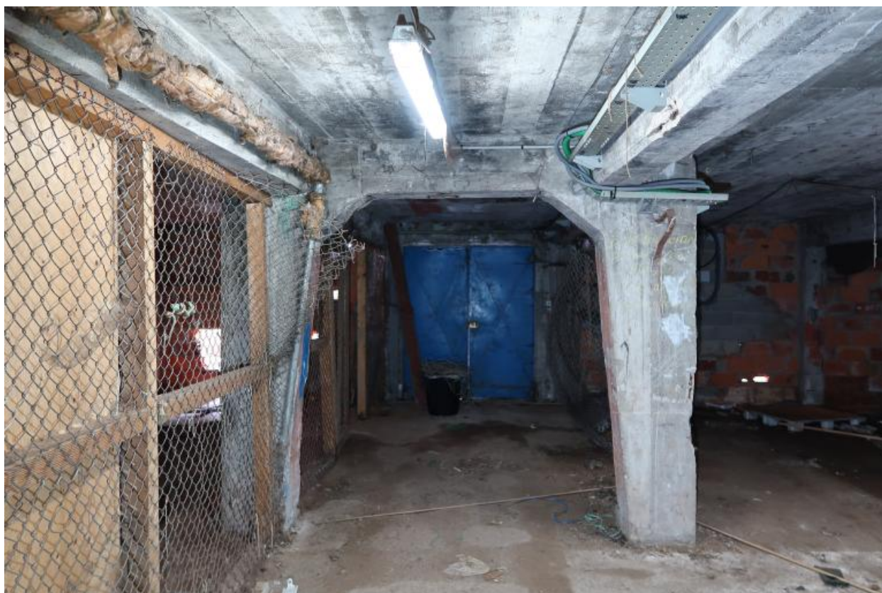
Rez-de-chaussée : extrémité nord. Sur le pilier droit, inscription à la craie
