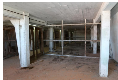
Deuxième étage : extrémité nord, grillage surmonté de deux rangs de fil barbelé séparant deux boxes Phot. Guillaume Lécueillier IVR53_20225606245NUCA
