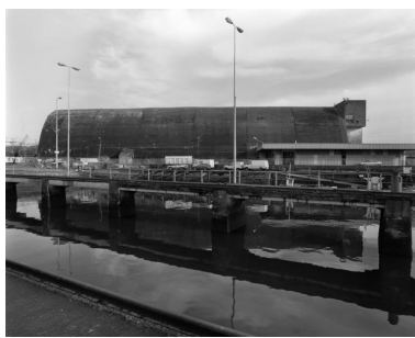
Vue générale ouest en 2000. Au premier plan, la cale du slipway Phot. Bernard Bègne IVR53_20005600554X
