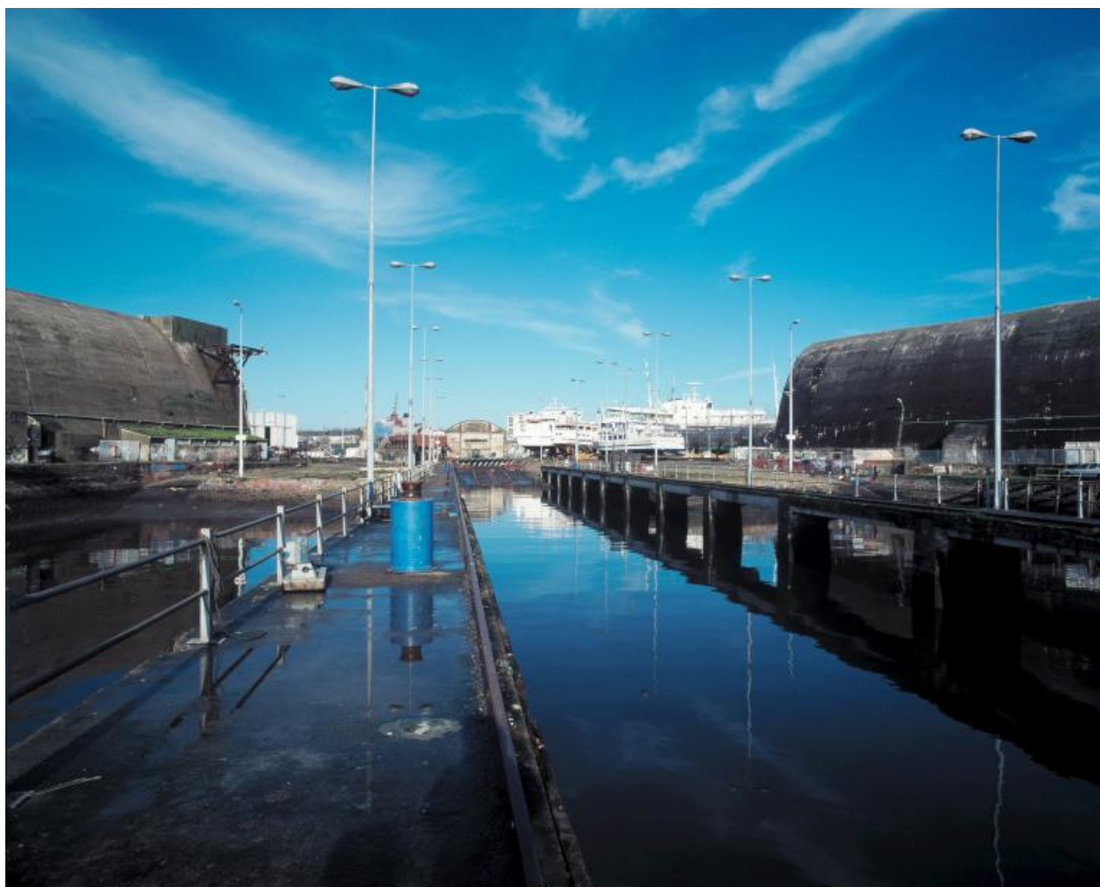
Vue de situation en 2000 (à droite, le dom-bunker est dit "T5"). Au centre, la cale du slipway accessible depuis le bassin long du port de pêche de Keroman
