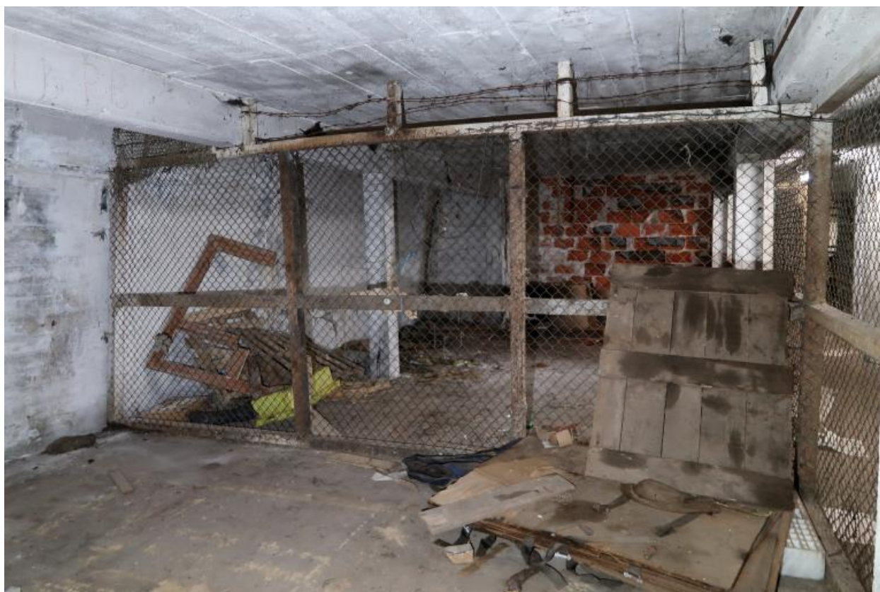
Premier étage : grillage surmonté de deux rangs de fil barbelé séparant deux boxes (box 21). A gauche sur la poutre, marquage "I PB"
