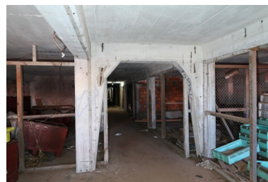
Premier étage : extrémité nord Phot. Guillaume Lécueillier IVR53_20225606230NUCA
