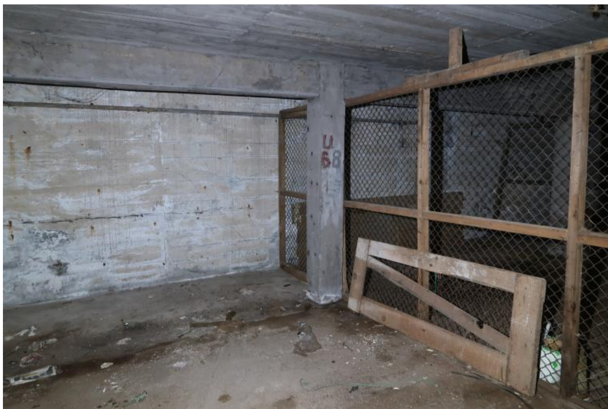
Rez-de-chaussée : marquage "U68" (box 7)
