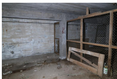
Rez-de-chaussée : marquage "U68" (box 7) Phot. Guillaume Lécueillier IVR53_20225606206NUCA
