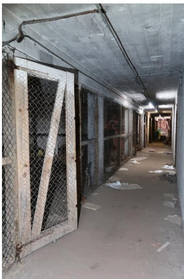
Premier étage : couloir central desservant les boxes Phot. Guillaume Lécueillier IVR53_20225606233NUCA
