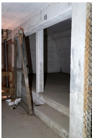
Premier étage : extrémité sud, box 38 Phot. Guillaume Lécueillier IVR53_20225606242NUCA
