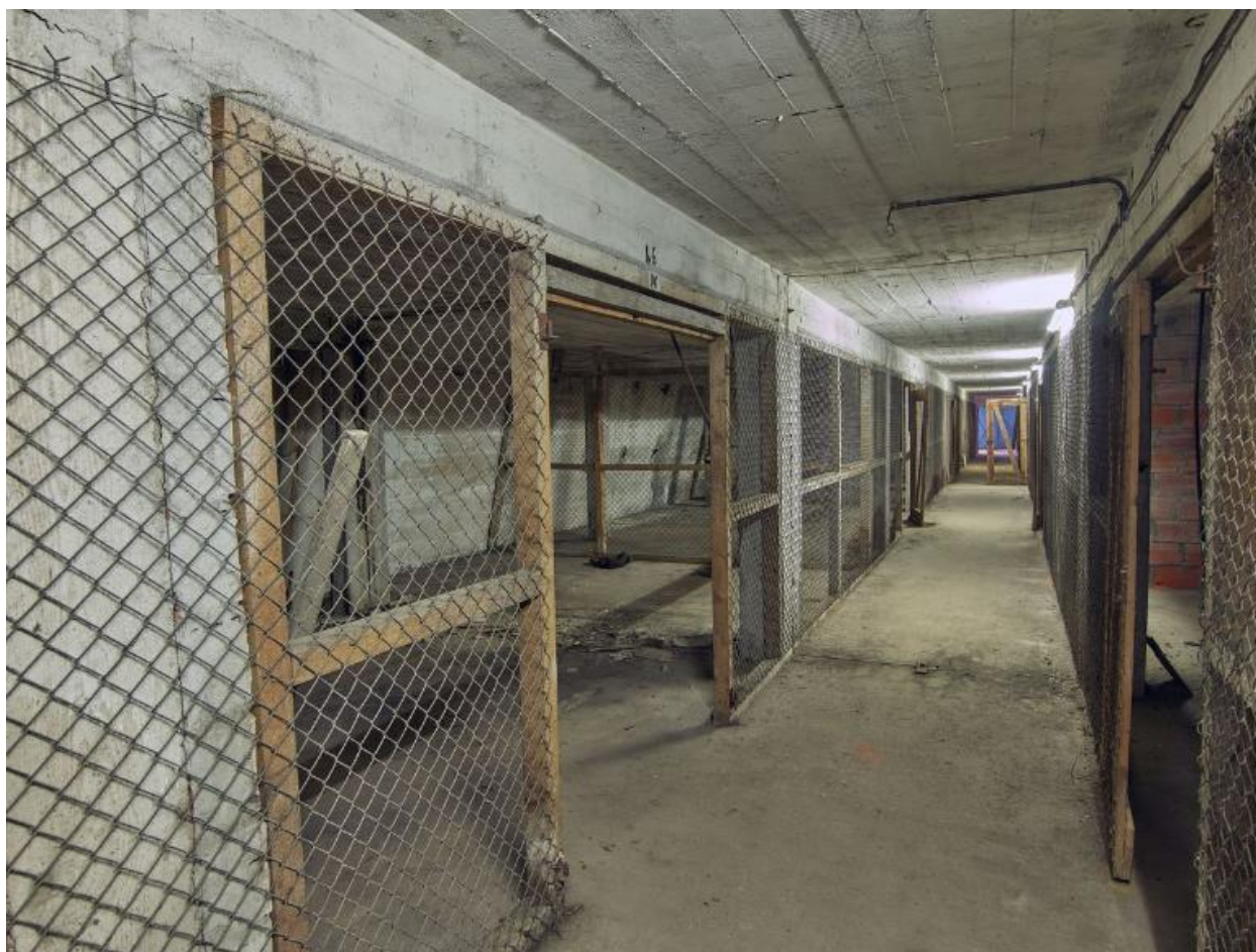
Vue de l'un des cinq niveaux de stockage
