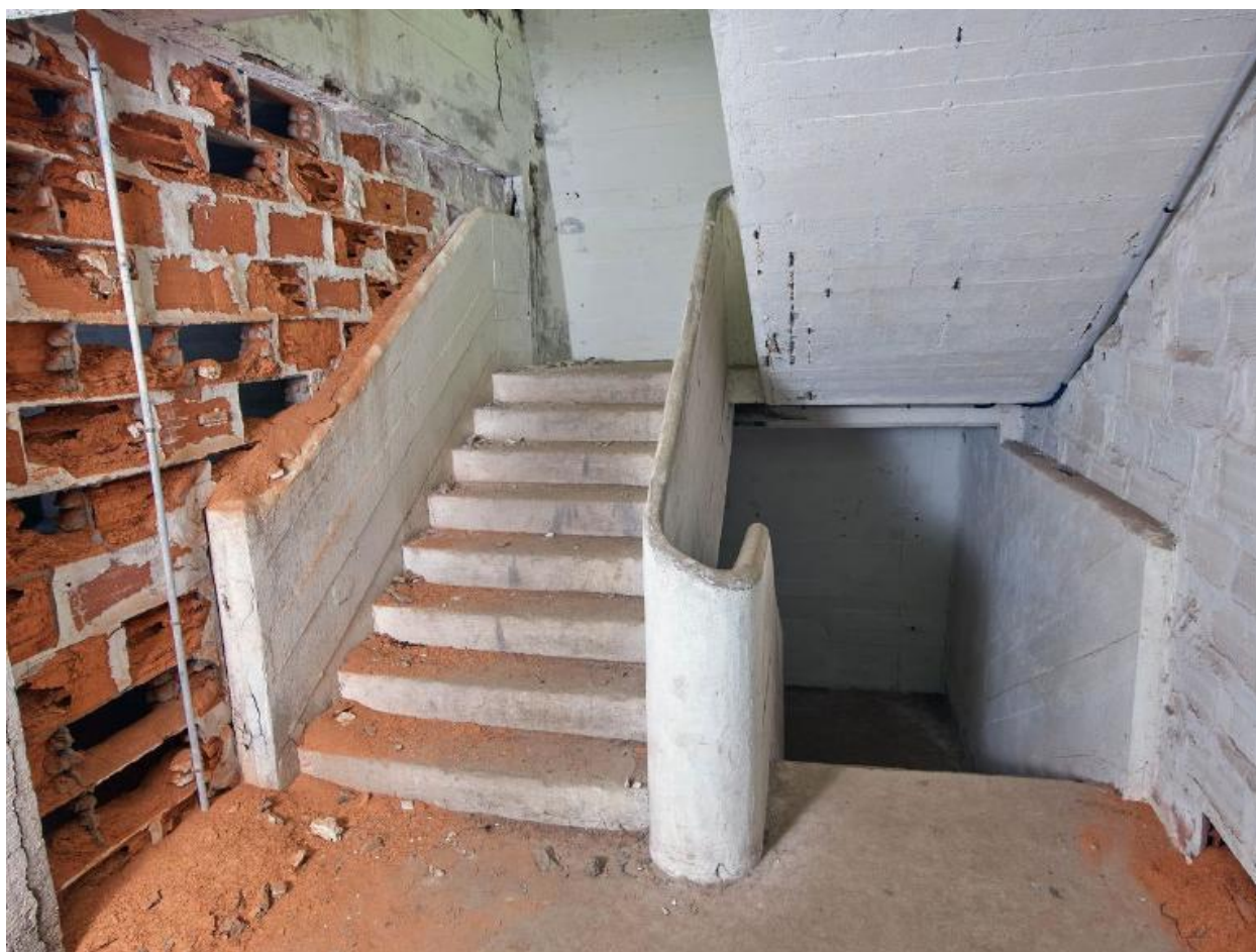
Vue de l'escalier intérieur desservant les cinq niveaux de stockage
