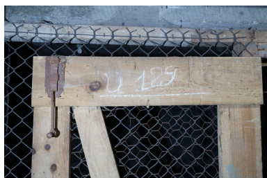
Rez-de-chaussée : marquage "U 129" [porte] (box 11) Phot. Guillaume Lécueillier IVR53_20225606209NUCA
