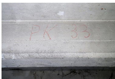
Premier étage : marquage "PK 33" (box 21). "PK" est l'abréviation en allemand de "Propaganda Kompanie", "compagnie de propagande" Phot. Guillaume Lécueillier IVR53_20225606236NUCA
