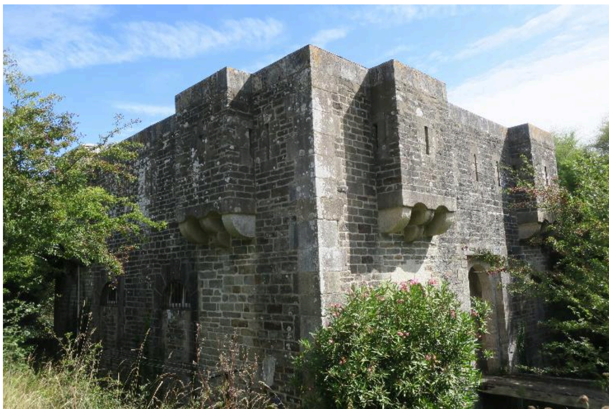
Le Palais, Port Larron, corps de garde crénelé, angle sud-ouest.
