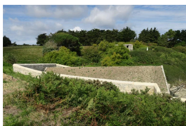
Le Palais, Port Larron, la Belle Fontaine et le corps de garde crénelé en arrière-plan. Phot. Patrick Jadé IVR53_20175607315NUCA
