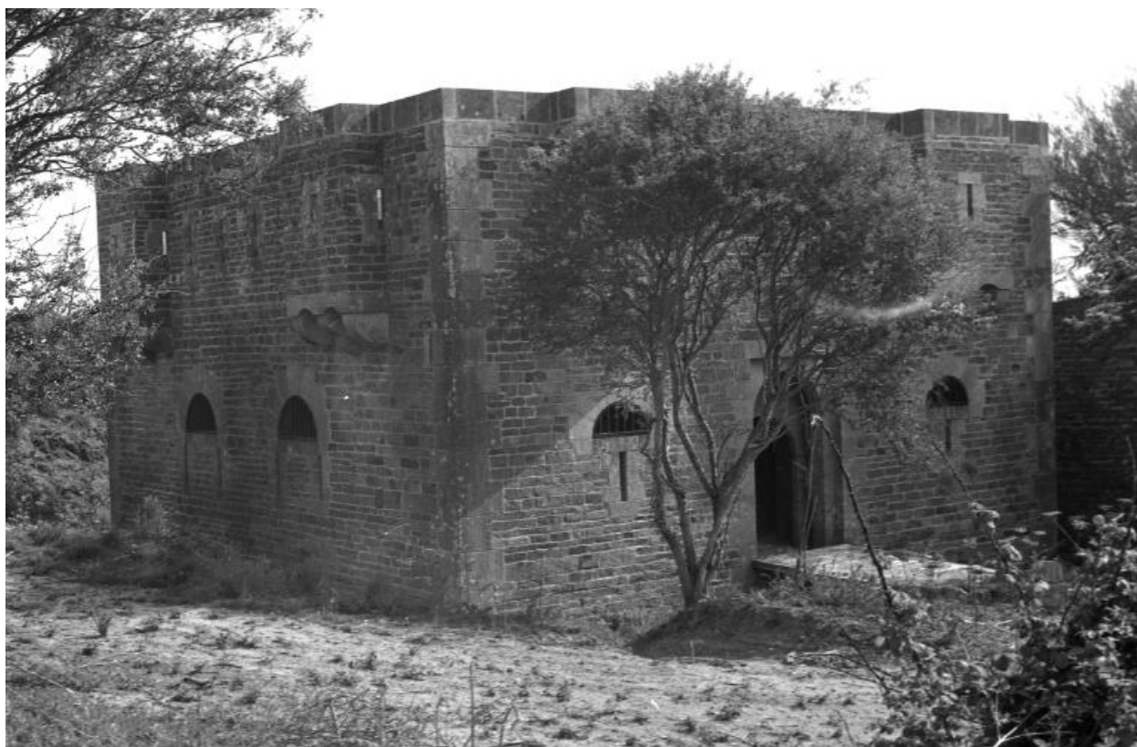
Le Palais, Port Larron, corps de garde crénelé, état dans les années 1970.
