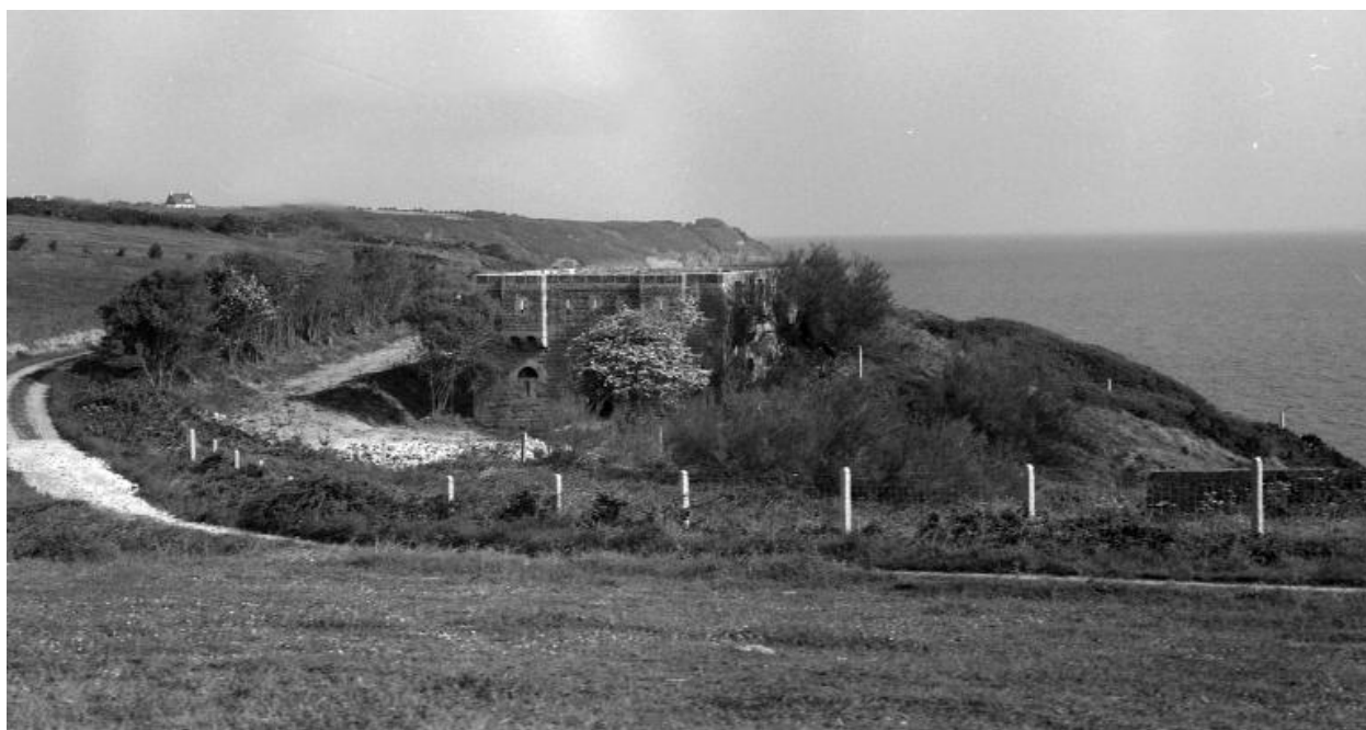
Le Palais, Port Larron, vue de situation du sud-ouest.
