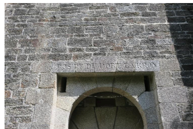
Le Palais, Port Larron, corps de garde crénelé, inscription au dessus de la porte. Phot. Patrick Jadé IVR53_20175607323NUCA
