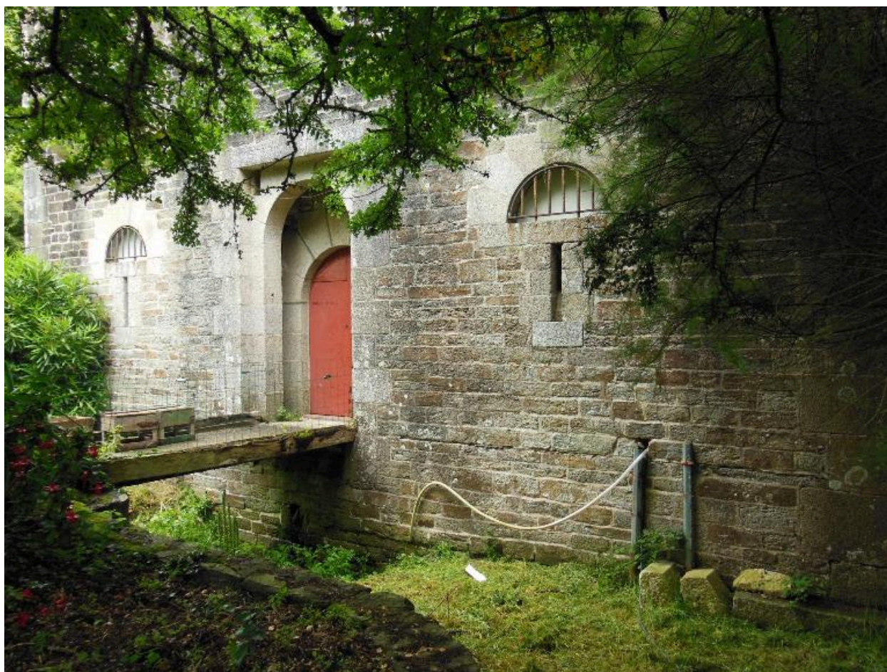
Le Palais, Port Larron, corps de garde crénelé, porte et haha.
