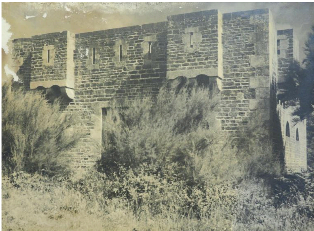
Le Palais, Port Larron, corps de garde crénelé, état avant les travaux des années 1970.
