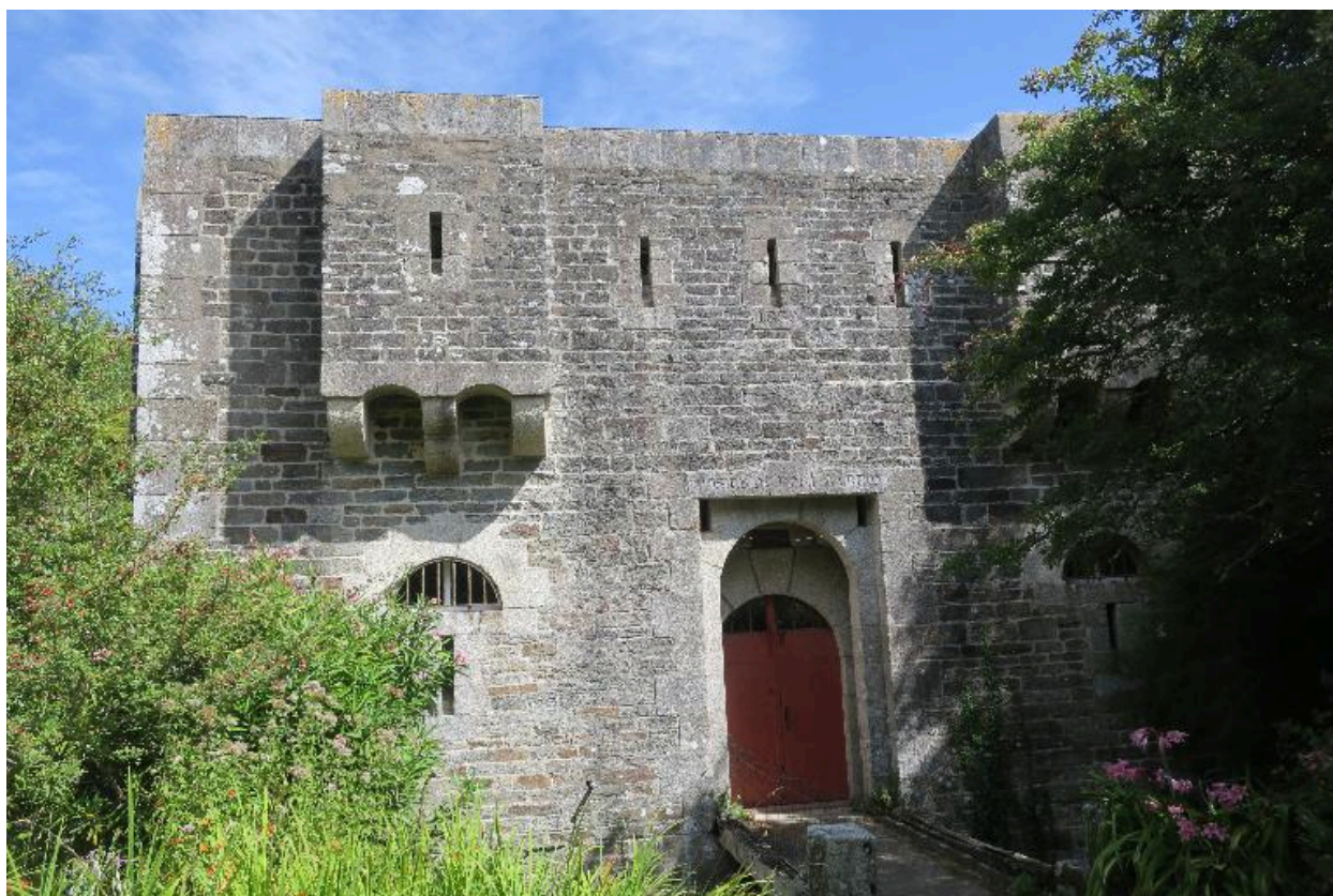
Le Palais, Port Larron, corps de garde crénelé, façade de gorge.
