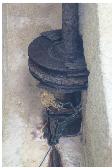
Le Palais, Port Larron, corps de garde crénelé, détail du mécanisme du pont-levis. Phot. Patrick Jadé IVR53_20175607327NUCA
