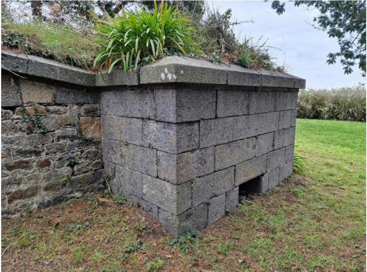
Vue de détail de l'élévation sud en pierre de taille et en maçonnerie de moellon de granite (état en 2024). Une tablette en pierre de taille couronne les murs. La baie située au ras du sol et en partie remblayée est celle du cendrier du four
