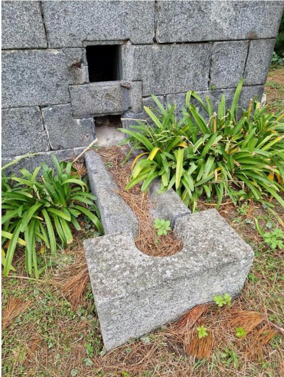
Vue de détail de l'élévation ouest en pierre de taille de granite (état en 2024). La goulotte de réception des boulets rouges est en granite
