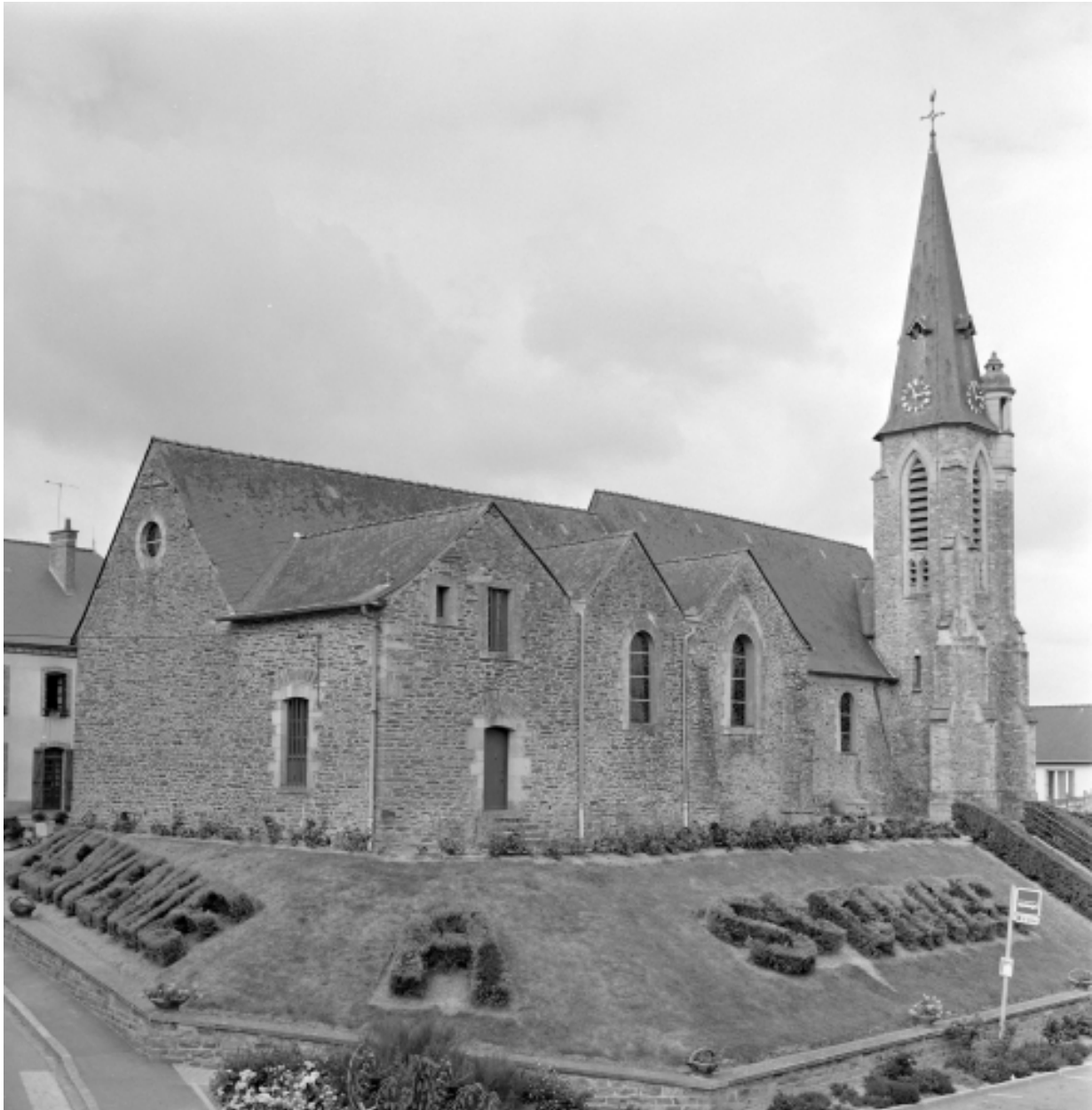
Elévation Nord-Est : vue générale
