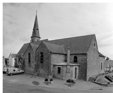
Elévation Sud-Est : vue générale Phot. Guy Artur, Phot. Norbert Lambart IVR53_19943501332X
