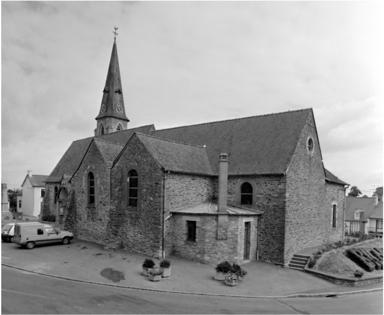
Elévation Sud-Est : vue générale
