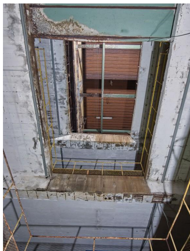
Vue de l'extension nord-ouest : puits du monte-charge depuis le rez-de-chaussée
