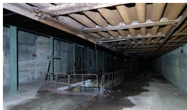
Vue de l'extension nord-ouest : dessous du débord de la dalle de couverture du bunker Keroman III, plaques nervurées Phot. Guillaume Lécueillier IVR53_20245610102NUCA
