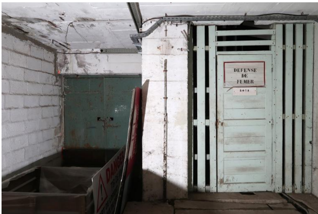
Vue de l'extension nord-ouest : cage d'escalier et puits monte-charge du rez-de-chaussée
