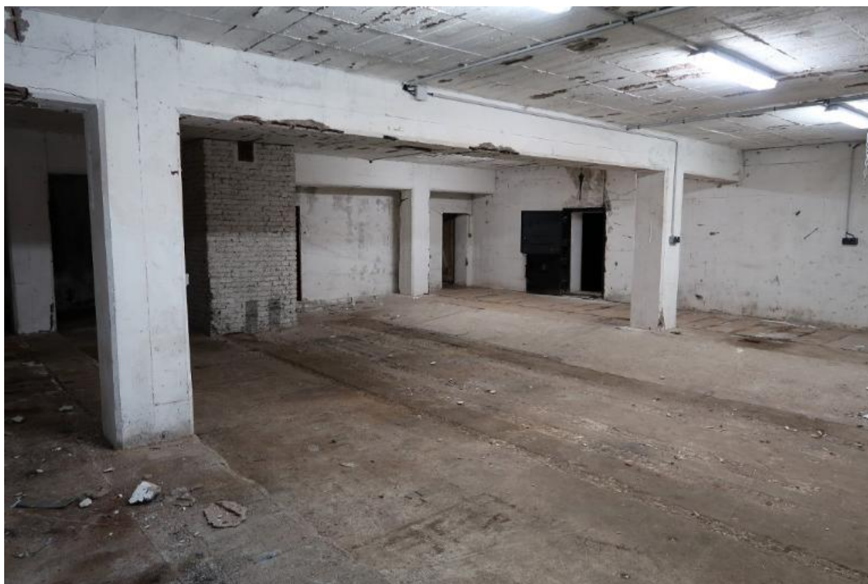
Vue de l'extension nord-ouest : rez-de-chaussée, poteaux et poutres en béton soutenant le premier étage ; au fond à gauche, puits d'accès en brique aux réservoirs situés au sous-sol
