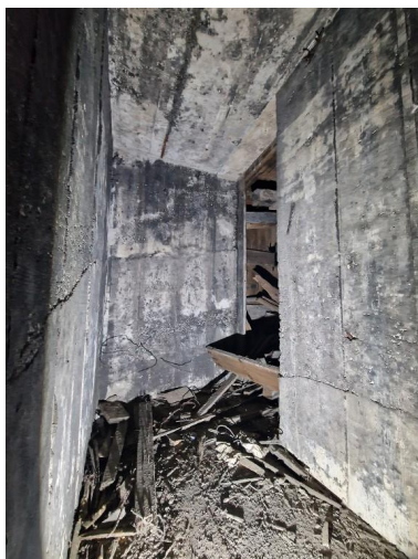
Vue de l'extension nord-ouest : entrée de l'une des casemates aménagées dans l'épaisseur du mur nord-ouest au troisième étage. Le coffrage d'origine est en place Phot. Guillaume Lécueillier IVR53_20245610109NUCA
