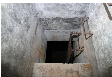
Vue de l'extension nord-ouest : rez-de-chaussée, puits d'accès aux réservoirs situés au sous-sol Phot. Guillaume Lécueillier IVR53_20245610095NUCA
