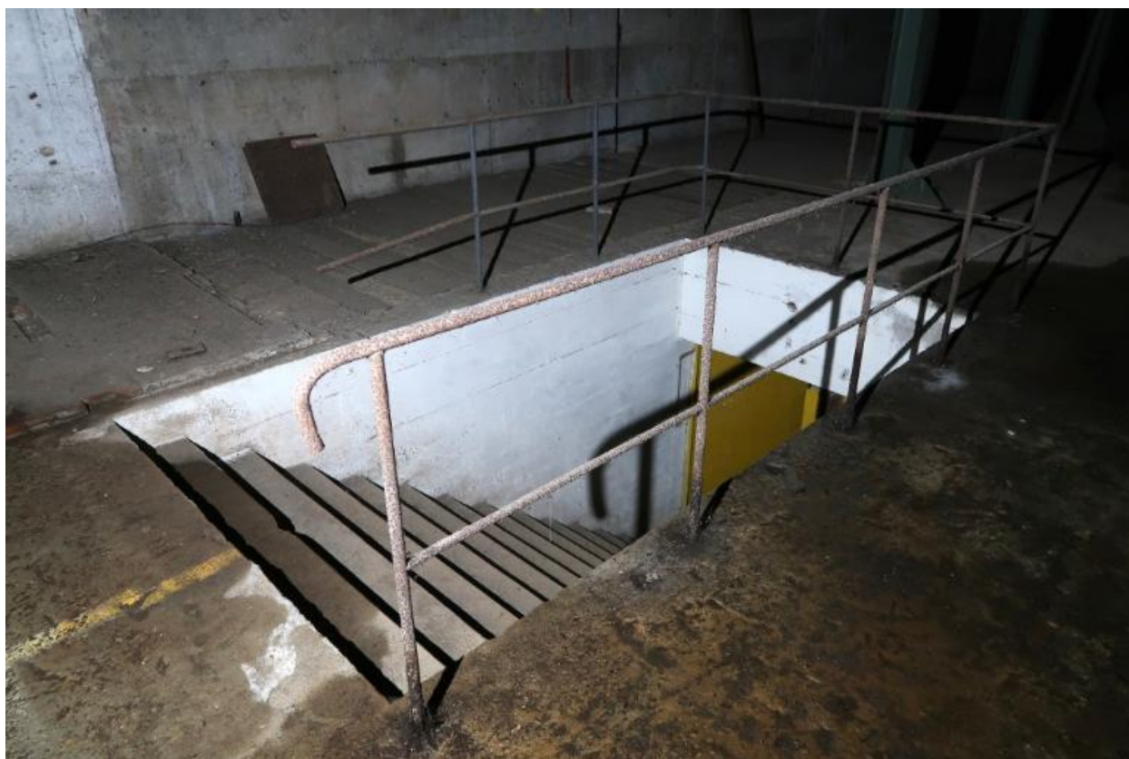
Vue de l'extension nord-ouest : débouché de l'escalier du troisième étage avec sa rampe métallique
