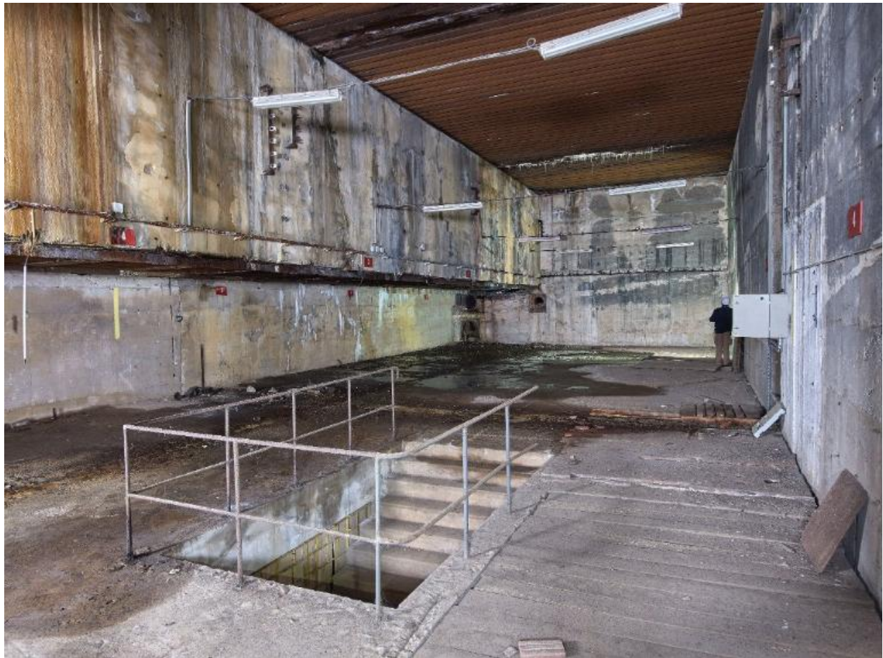
Vue de l'extension nord-ouest : débouché de l'escalier du troisième étage. Au premier plan, l'emplacement du puits du monte-charge d'origine (des planches en bois le masquent)
