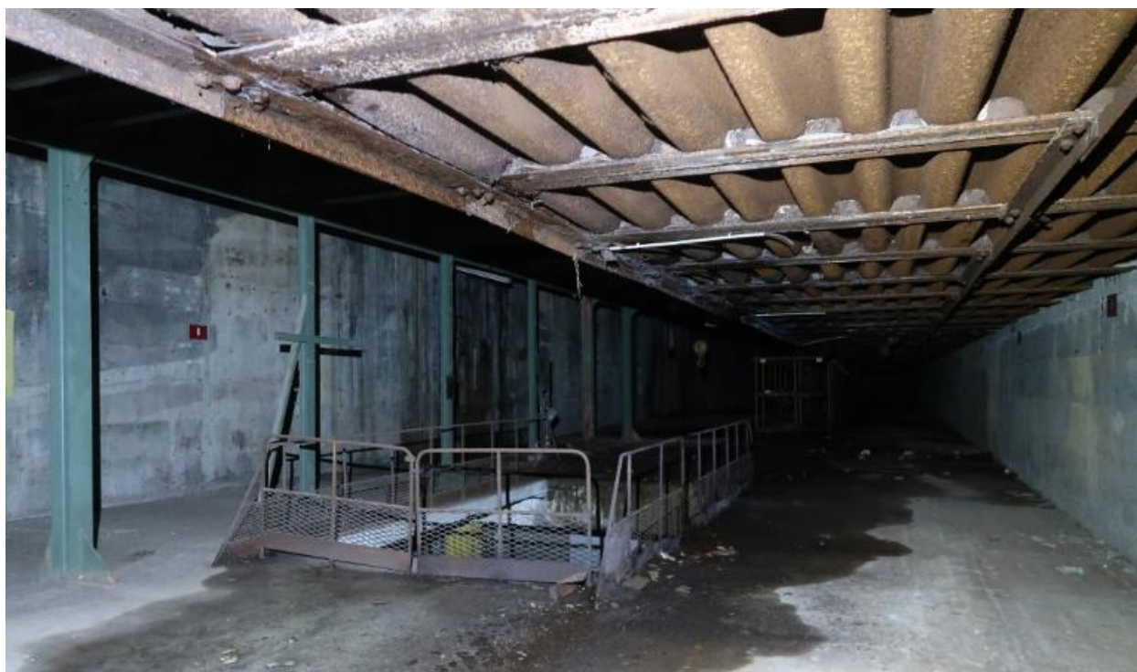
Vue de l'extension nord-ouest : dessous du débord de la dalle de couverture du bunker Keroman III, plaques nervurées
