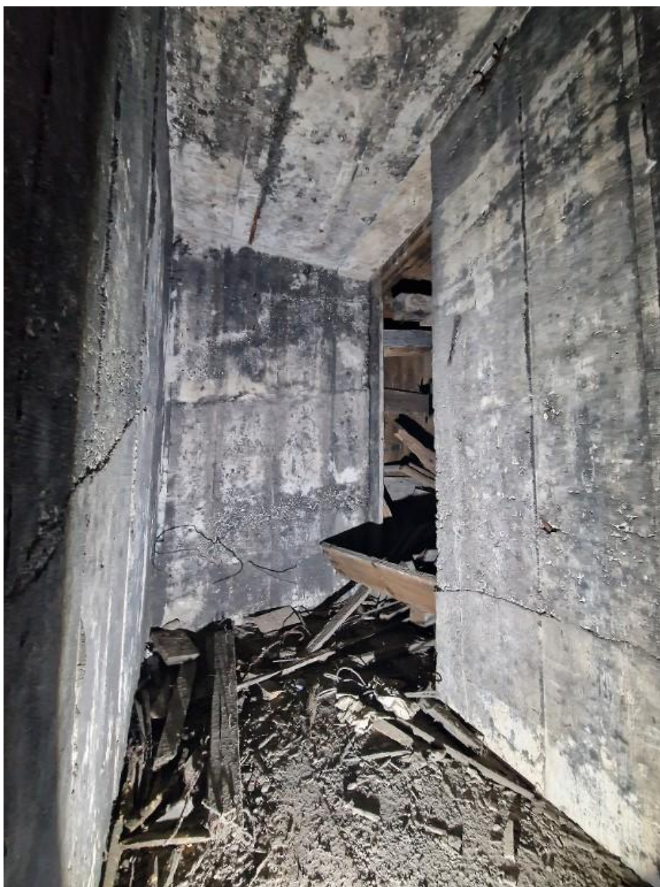
Vue de l'extension nord-ouest : entrée de l'une des casemates aménagées dans l'épaisseur du mur nord-ouest au troisième étage. Le coffrage d'origine est en place
