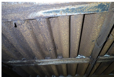
Vue de l'extension nord-ouest : détail du dessous de la dalle de couverture du bunker Keroman III, plaques nervurées Phot. Guillaume Lécueillier IVR53_20245610103NUCA
