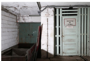
Vue de l'extension nord-ouest : cage d'escalier et puits monte- charge du rez-de-chaussée Phot. Guillaume Lécueillier IVR53_20245610106NUCA
