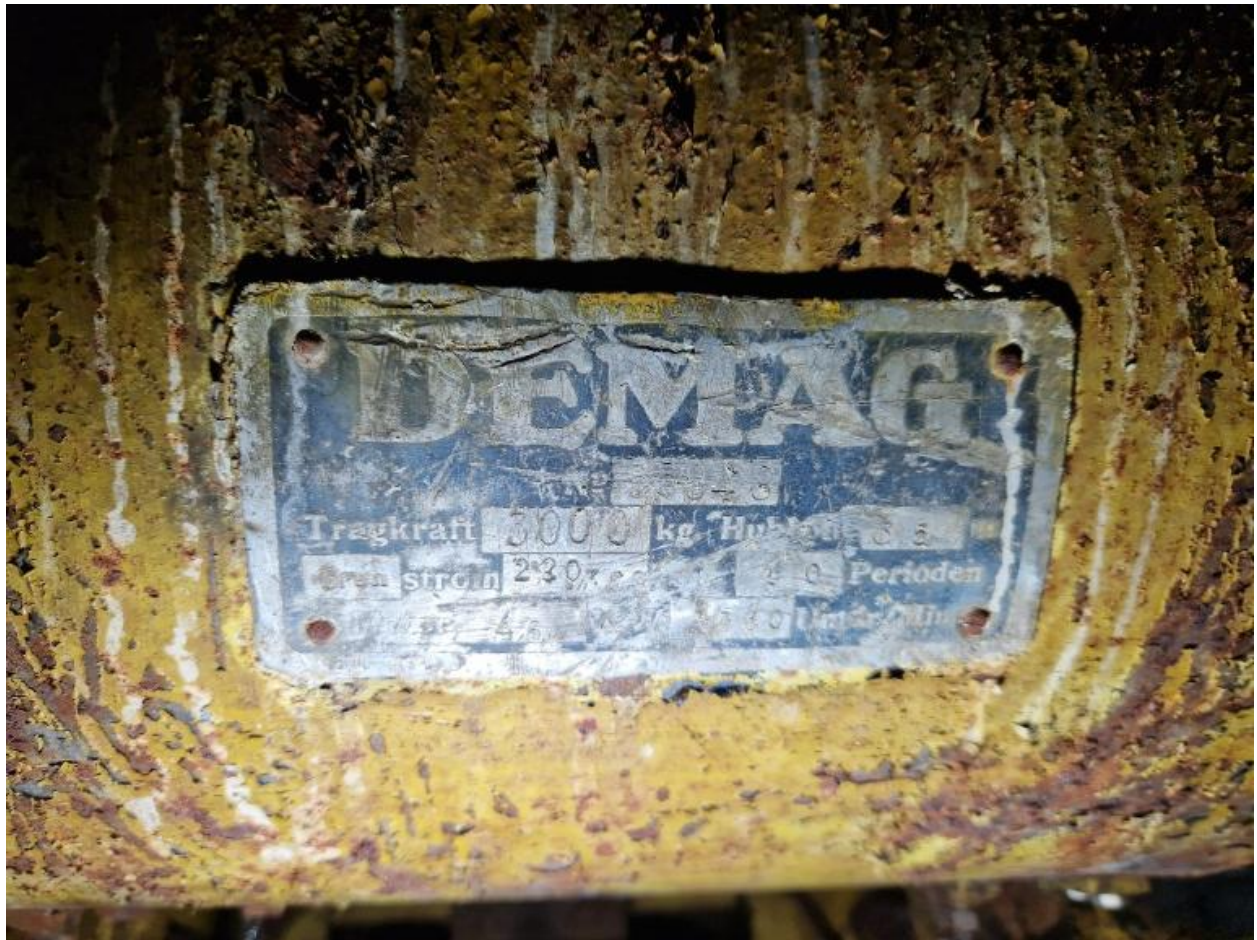
Vue de l'extension nord-ouest : détail de la plaque constructeur du treuil du troisième étage servant de magasin. On peut lire la marque DEMAG et des renseignements techniques
