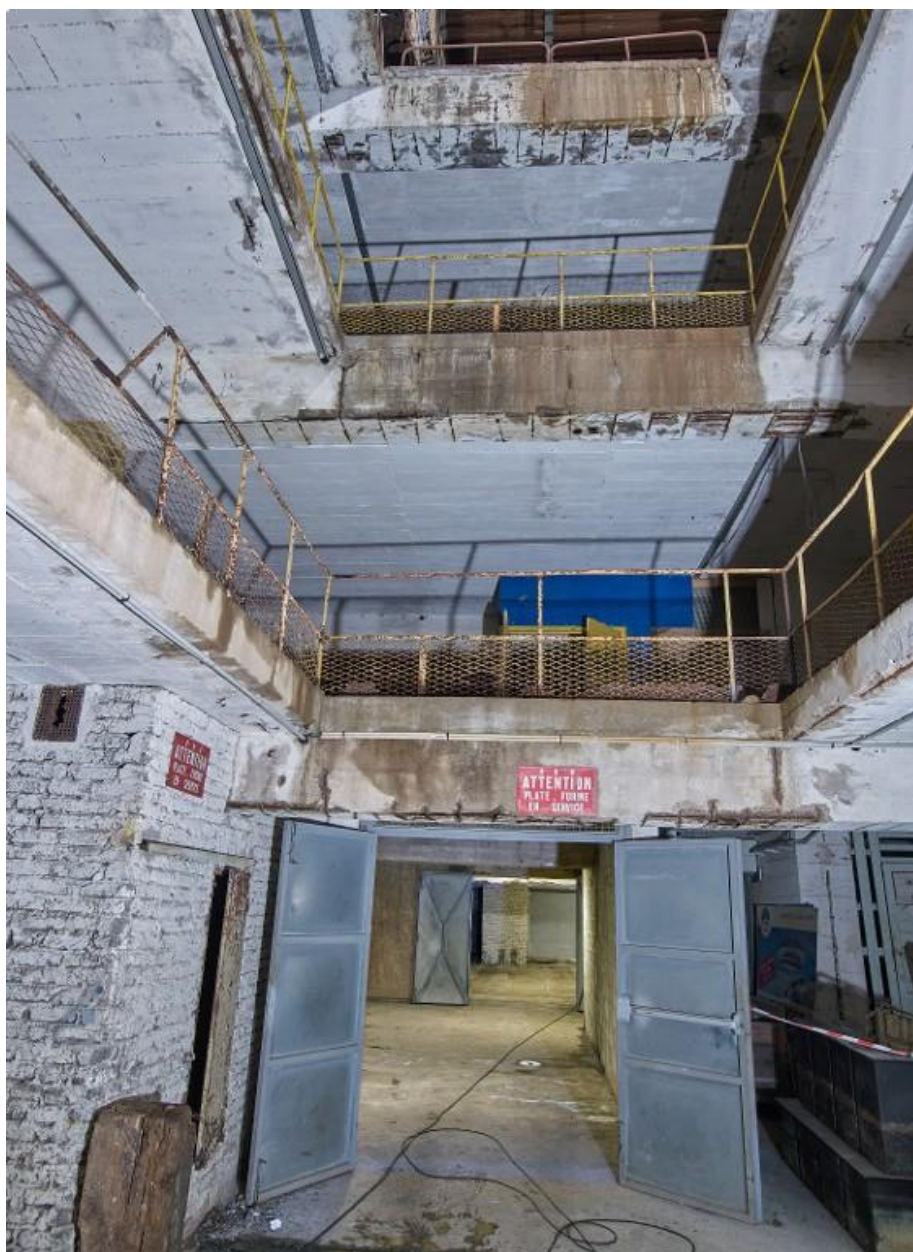
Vue de l'extension nord-ouest : puits du monte-charge depuis le rez-de-chaussée. On visualise bien les trois étages de l'extension
