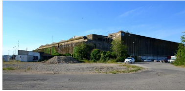
Vue générale du bunker Keroman III depuis le nord : de part et d'autre de l'angle nord, les extensions nord-est et nord-ouest Phot. Guillaume Lécueillier IVR53_20245610091NUCA
