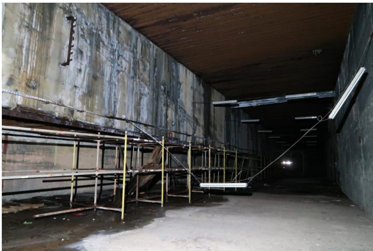
Vue de l'extension nord-ouest : étagères métalliques du troisième étage servant de magasin
