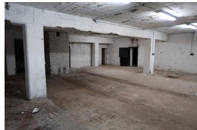
Vue de l'extension nord-ouest : rez- de-chaussée, poteaux et poutres en béton soutenant le premier étage ; au fond à gauche, puits d'accès en brique aux réservoirs situés au sous-sol Phot. Guillaume Lécueillier IVR53_20245610096NUCA
