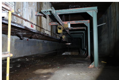
Vue de l'extension nord-ouest : portique et treuil du troisième étage servant de magasin Phot. Guillaume Lécueillier IVR53_20245610100NUCA
