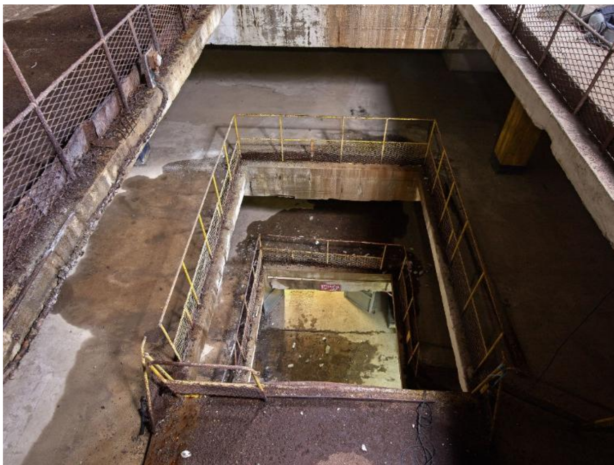
Vue de l'extension nord-ouest : puits du monte-charge depuis le troisième étage
