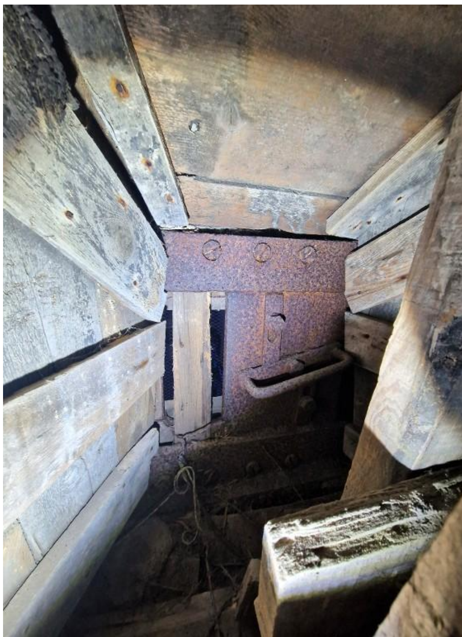
Vue de l'extension nord-ouest : créneau blindé de l'une des casemates aménagées dans l'épaisseur du mur nord-ouest au troisième étage. Le coffrage d'origine est en place
