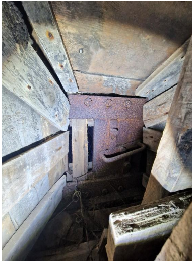
Vue de l'extension nord-ouest : créneau blindé de l'une des casemates aménagées dans l'épaisseur du mur nord-ouest au troisième étage. Le coffrage d'origine est en place Phot. Guillaume Lécueillier IVR53_20245610107NUCA
