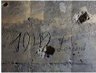
Vue de l'extension nord-ouest : détail du mur nord-ouest du bunker KIII depuis le troisième étage : sculpture sur béton en cours de prise, 1942 Lorient et inscription à la craie plus récente. Des traces d'impact de tir sont également visibles Phot. Bègne Bernard IVR53_20235600756NUCA
