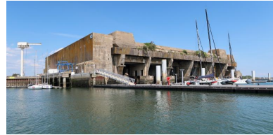
Vue générale du bunker Keroman III depuis le sud-ouest : à droite, l'extension nord-ouest Phot. Guillaume Lécueillier IVR53_20245610092NUCA
