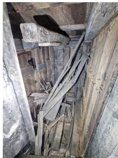
Vue de l'extension nord-ouest : coffrage d'origine dans l'une des casemates aménagées dans l'épaisseur du mur nord-ouest au troisième étage Phot. Guillaume Lécueillier IVR53_20245610108NUCA
