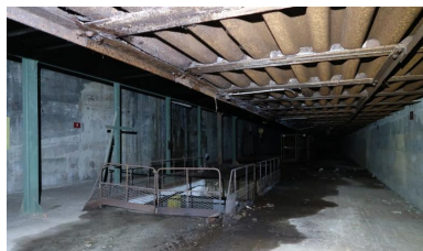
Vue de l'extension nord-ouest : dessous du débord de la dalle de couverture du bunker Keroman III, plaques nervurées Phot. Guillaume Lécueillier IVR53_20245610102NUCA
