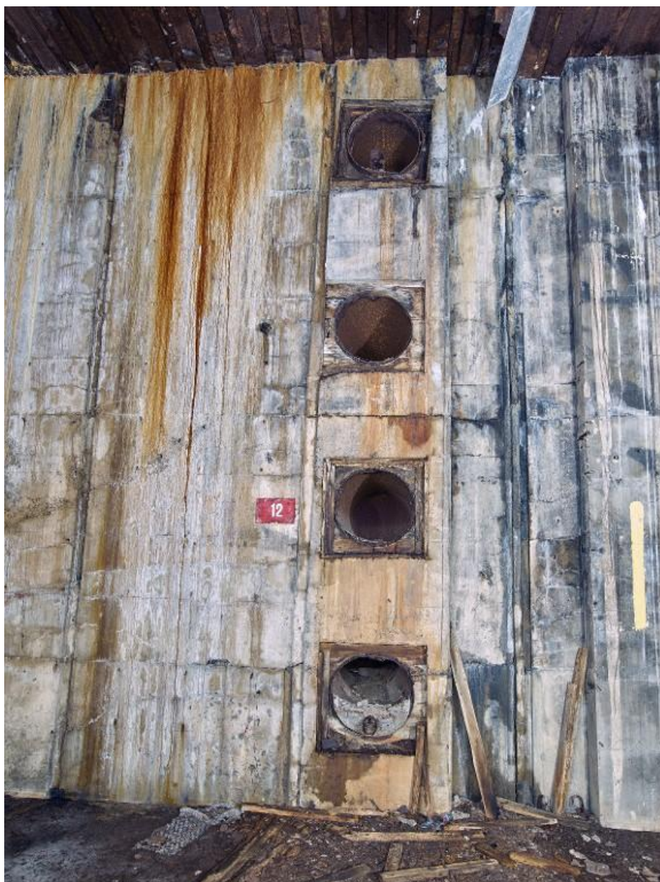
Vue de l'extension nord-ouest : tuyaux du système de ventilation traversant le mur nord-ouest au troisième étage
