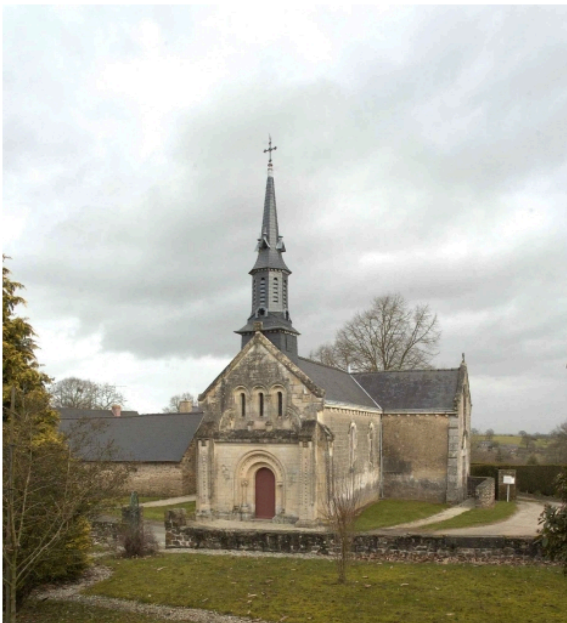
Vue générale de situation
