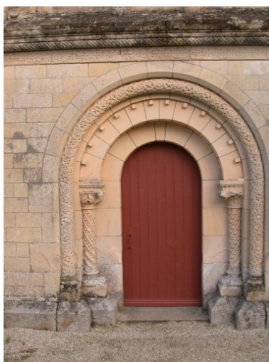
Façade principale, le portail Phot. Véronique Orain IVR53_20023517647NUCA
