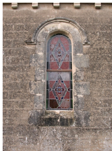
Façade latérale, détail d'une baie Phot. Véronique Orain IVR53_20023517646NUCA
