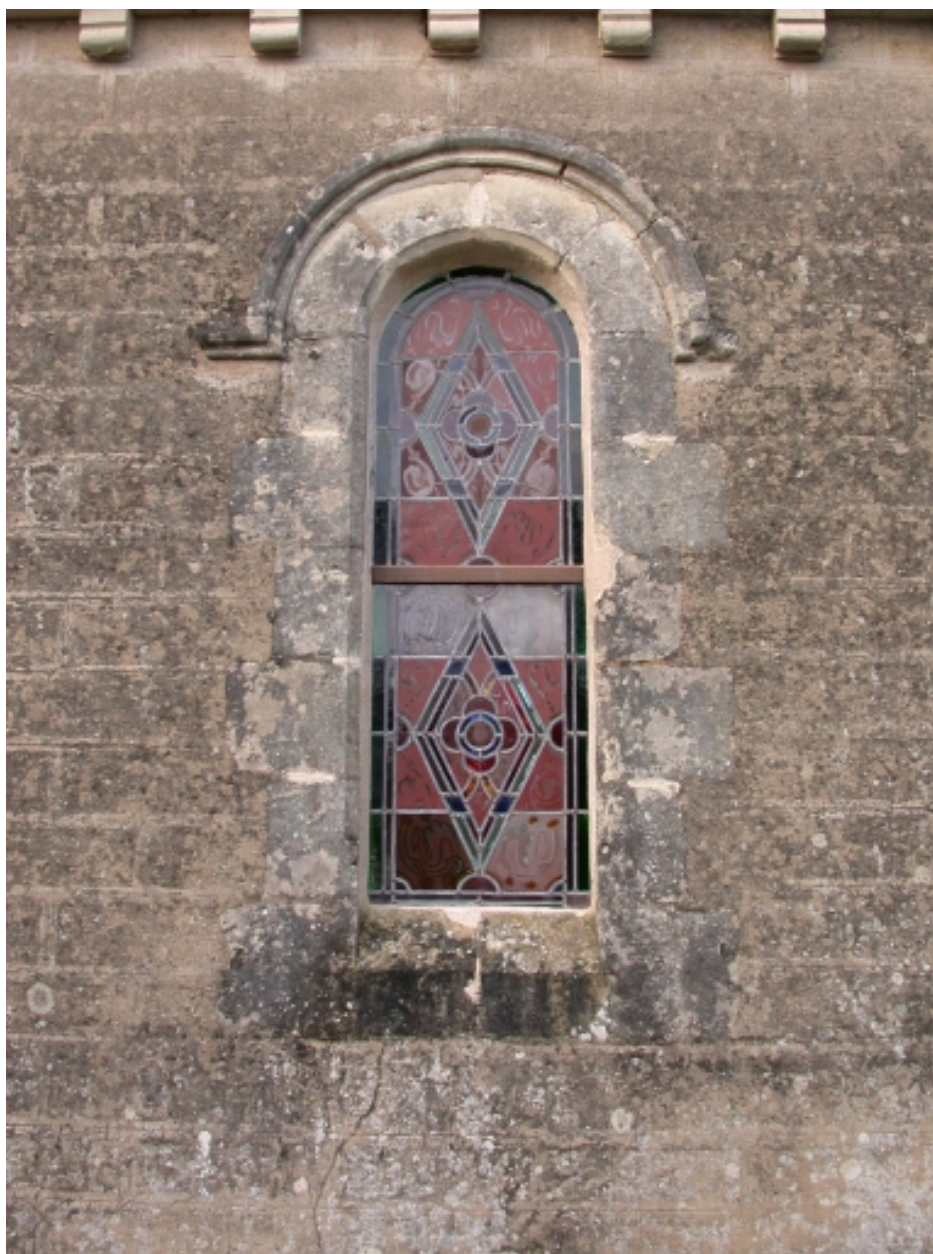
Façade latérale, détail d'une baie
