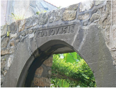
Détail du porche du manoir du patron de barques Taniou Phot. Lénaïg L'Aot IVR53_20072908914NUCA
