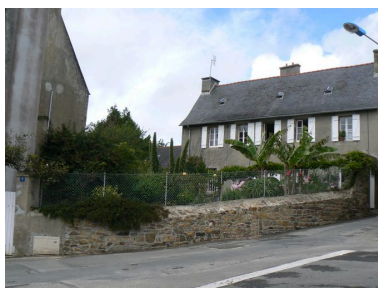
Manoir du patron de barques Taniou Phot. Lénéaig L'Aot IVR53_20072908915NUCA
