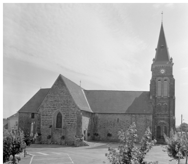
Elévation Nord : vue générale Phot. Guy Artur, Phot. Norbert Lambart IVR53_19943501424X
