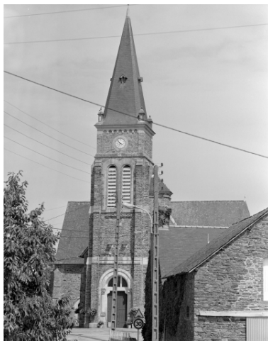
Elévation Ouest : vue générale Phot. Guy Artur, Phot. Norbert Lambart IVR53_19943501426X
