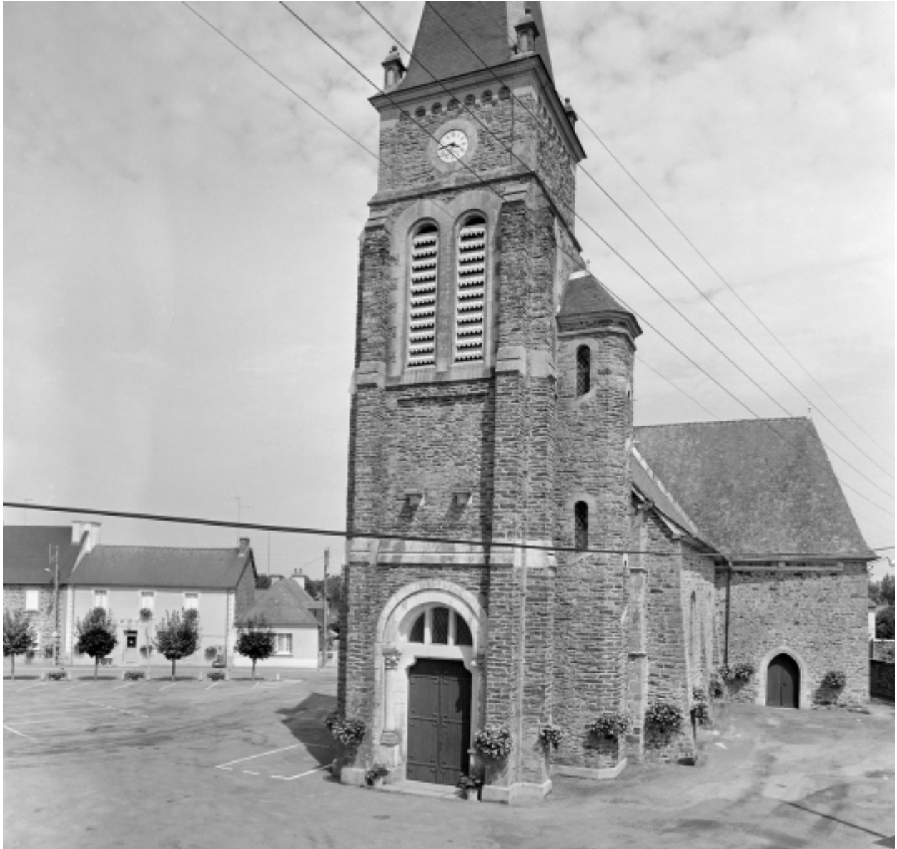
Elévation Sud-Ouest : vue générale
