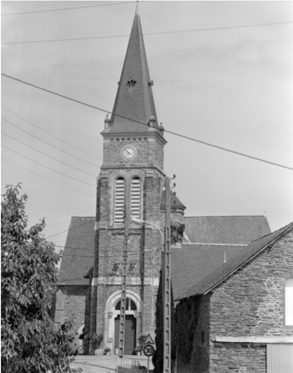
Elévation Ouest : vue générale
