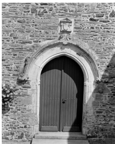
Elévation Nord, bras du transept, porte : vue générale Phot. Guy Artur, Phot. Norbert Lambart IVR53_19943501427X
