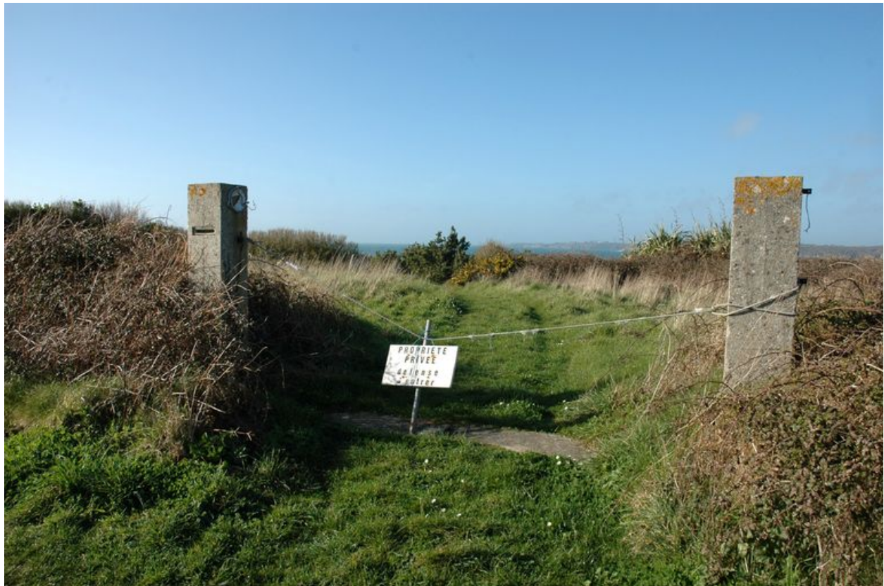
Vue de l'entrée de la batterie de Treize
