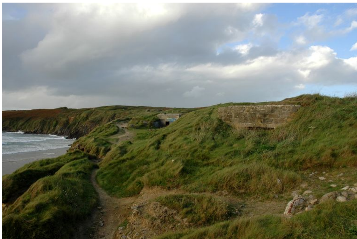
Vue de deux bunkers casemates dominant la plage des Blancs Sablons au nord
