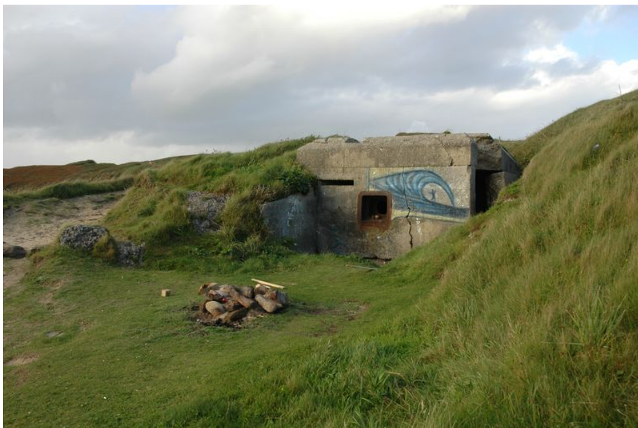
Vue d'un bunker - casemate pour canon antichar de 4,7 cm Skoda
