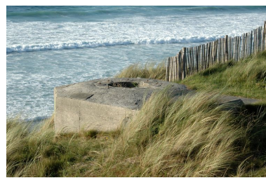
Vue d'un poste d'observation et de tir dit Tobruk-Stand dominant la plage des Blancs Sablons Phot. Guillaume Lécueillier IVR53_20062903929NUCA
