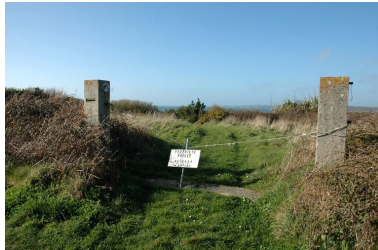
Vue de l'entrée de la batterie de Treize Phot. Guillaume Lécueillier IVR53_20072906086NUCA
