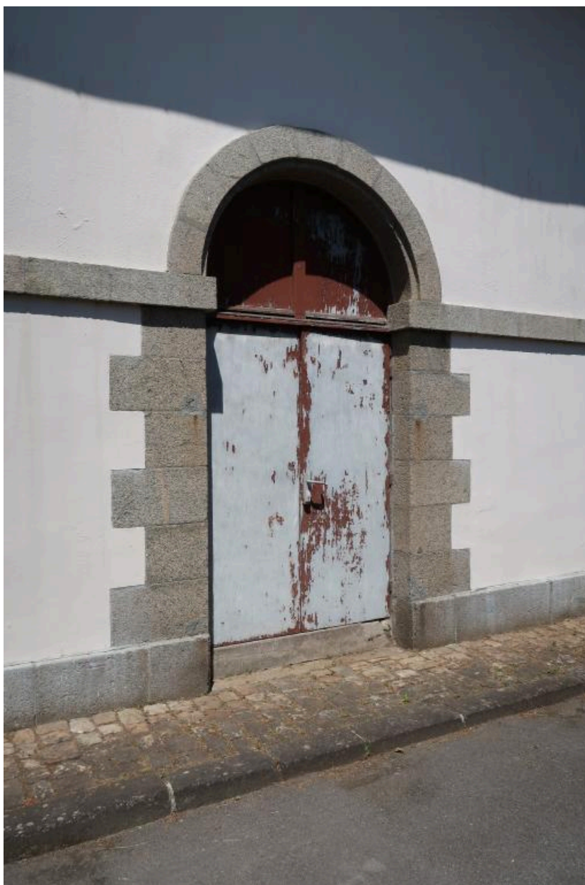
Vue de détail d'une baie (état en 2022)
