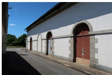
Vue de l'élévation sud (état en 2022) Phot. Guillaume Lécueillier IVR53_20222905455NUCA
