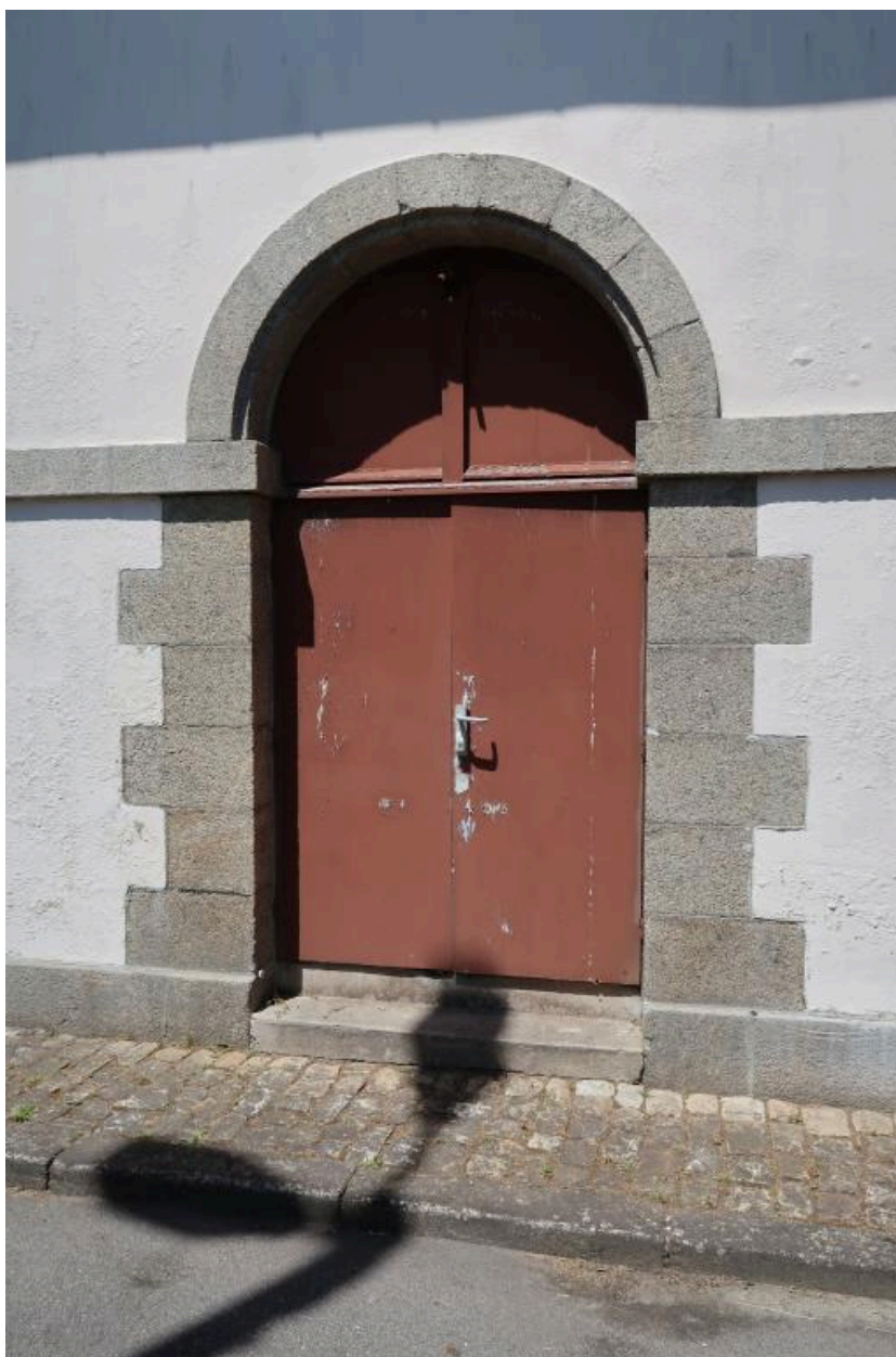
Vue de détail d'une baie (état en 2022)
