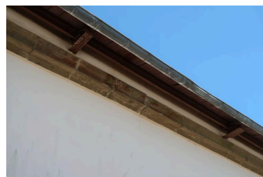
Vue de détail de la corniche (état en 2022) Phot. Guillaume Lécueillier IVR53_20222905461NUCA
