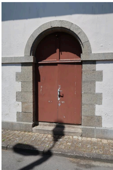
Vue de détail d'une baie (état en 2022) Phot. Guillaume Lécueillier IVR53_20222905457NUCA
