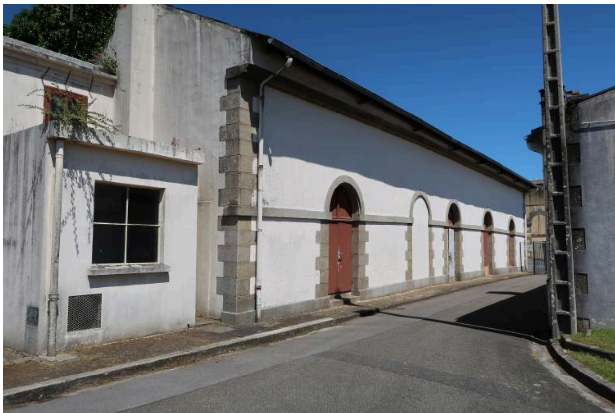
Vue générale : élévation sud (état en 2022)
