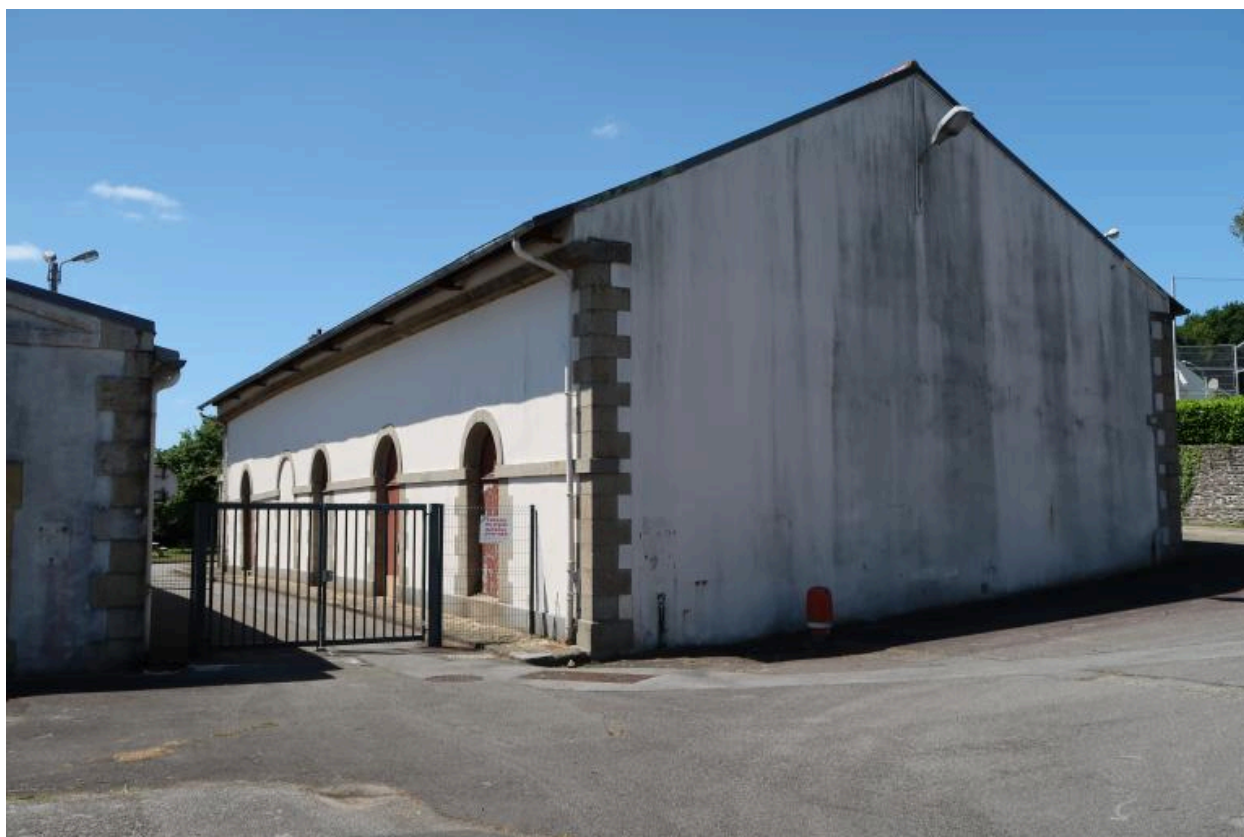
Vue générale : élévation sud (état en 2022)
