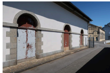
Vue de l'élévation sud (état en 2022) Phot. Guillaume Lécueillier IVR53_20222905456NUCA
