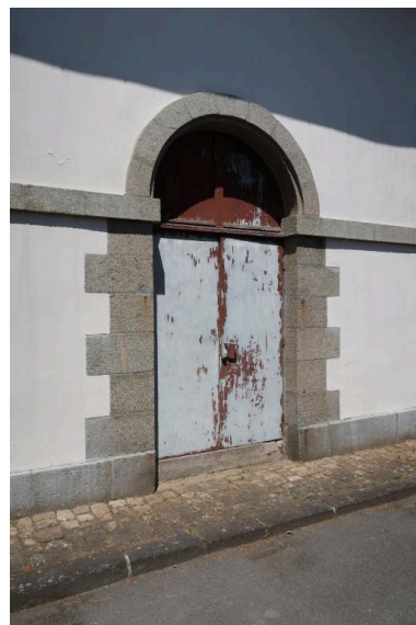
Vue de détail d'une baie (état en 2022) Phot. Guillaume Lécueillier IVR53_20222905458NUCA
