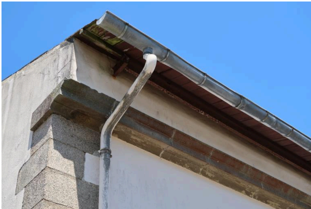
Vue de détail de la corniche (état en 2022)
