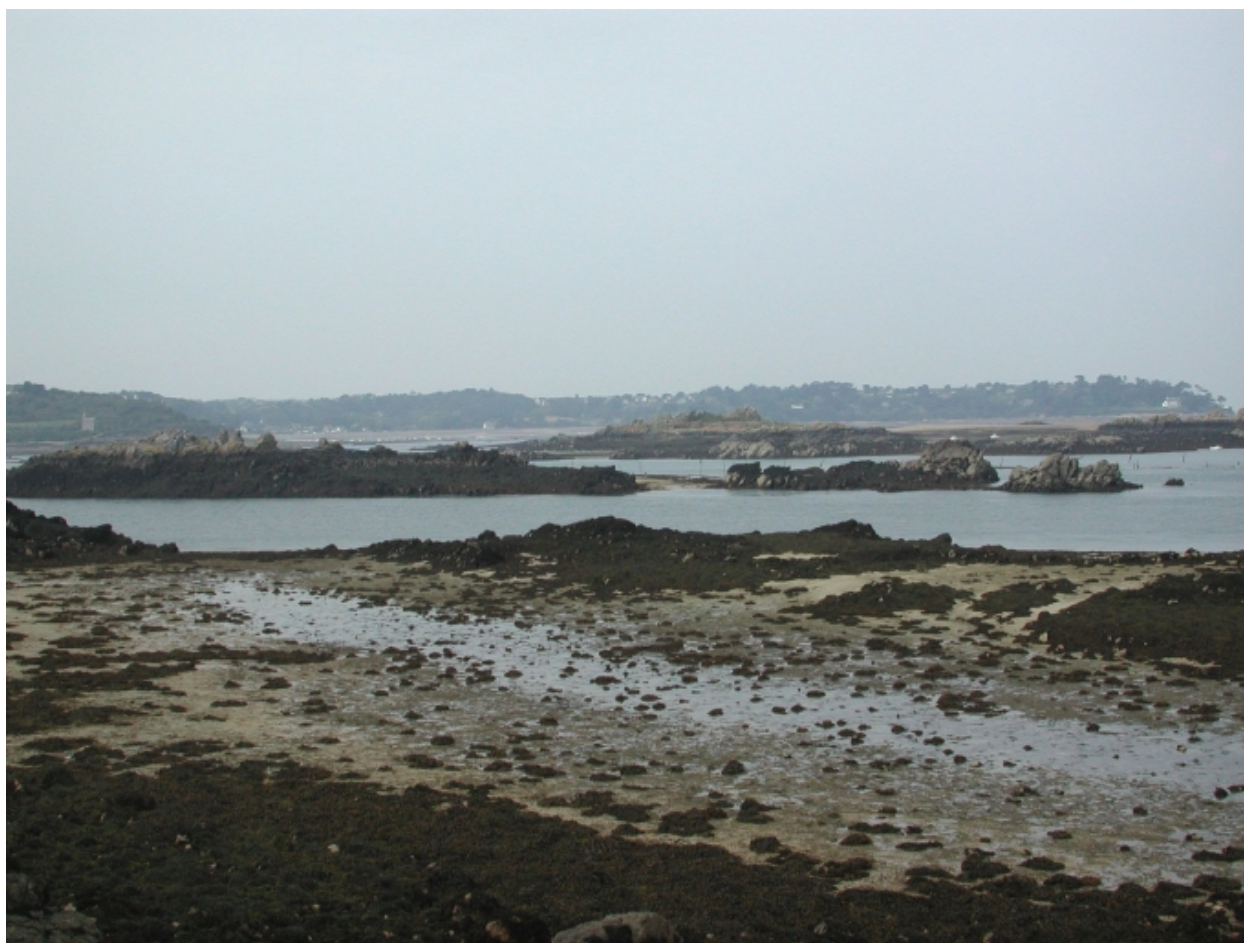
Vue des deux barrages Ouest et Nord de la pêcherie Nord
