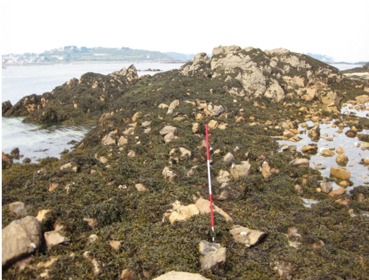
Vue du barrage Sud de la pêcherie Ouest, septembre 2008 (collection particulière, Loïc Langouët)
