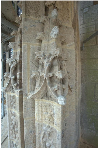
Portail nord, détail de la restauration des pinacles Phot. Norbert Lambart IVR53_20115600839NUCA
