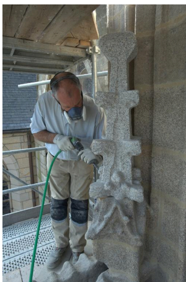
Portail nord, restauration d'un pinacle Phot. Norbert Lambart IVR53_20115600825NUCA
