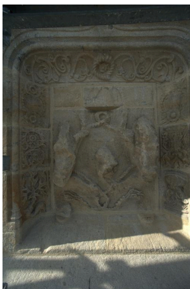
Niche au sommet du pignon du porche nord : armoiries bûchées Phot. Norbert Lambart IVR53_20115600804NUCA
