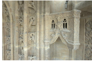
Portail nord, daïs d'une niche côté ouest Phot. Norbert Lambart IVR53_20115600852NUCA
