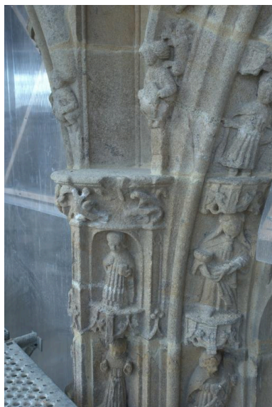
Portail nord, détail voûtures des fenêtres Phot. Norbert Lambart IVR53_20115600817NUCA
