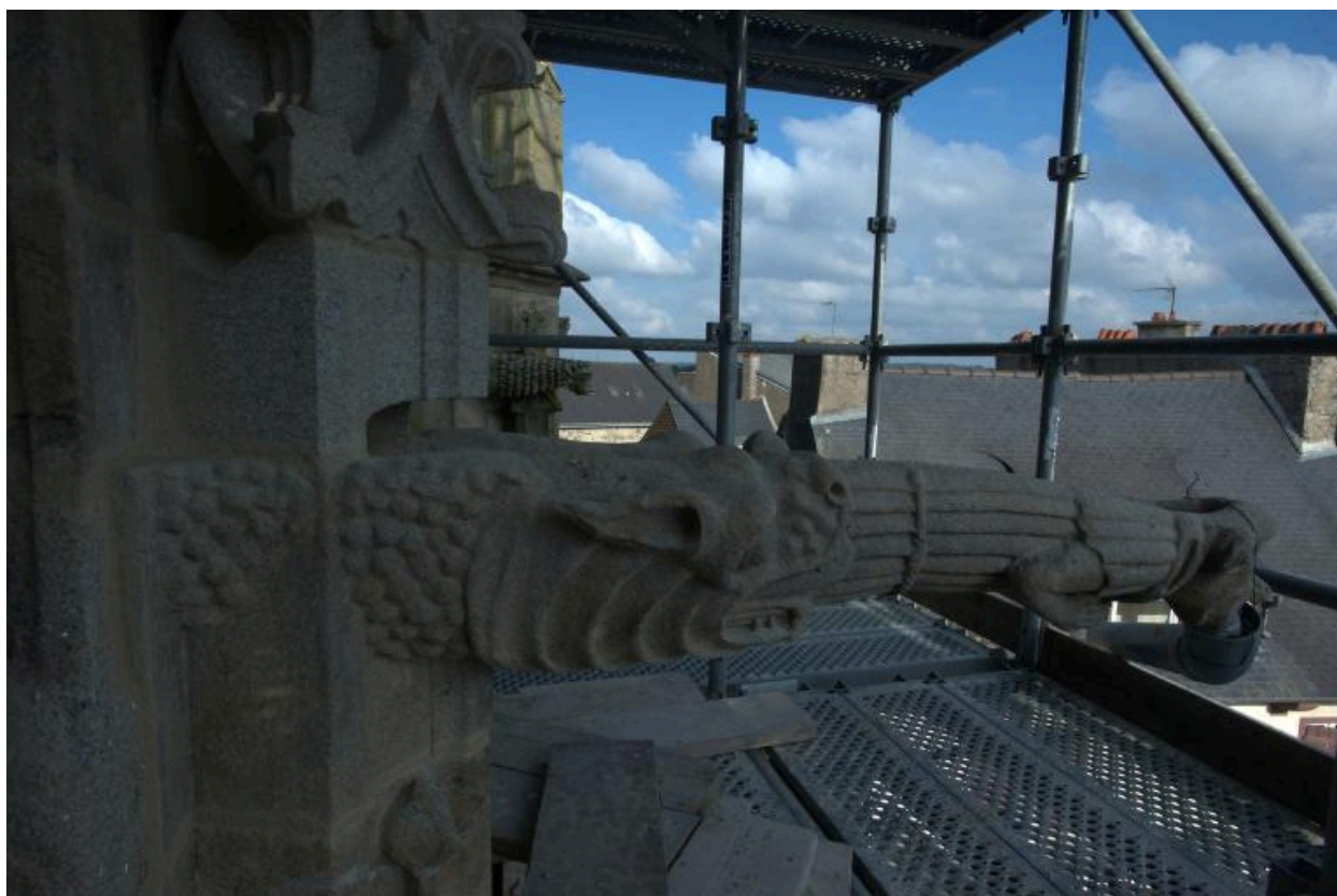
Portail nord, vue de l'échafaudage de restauration
