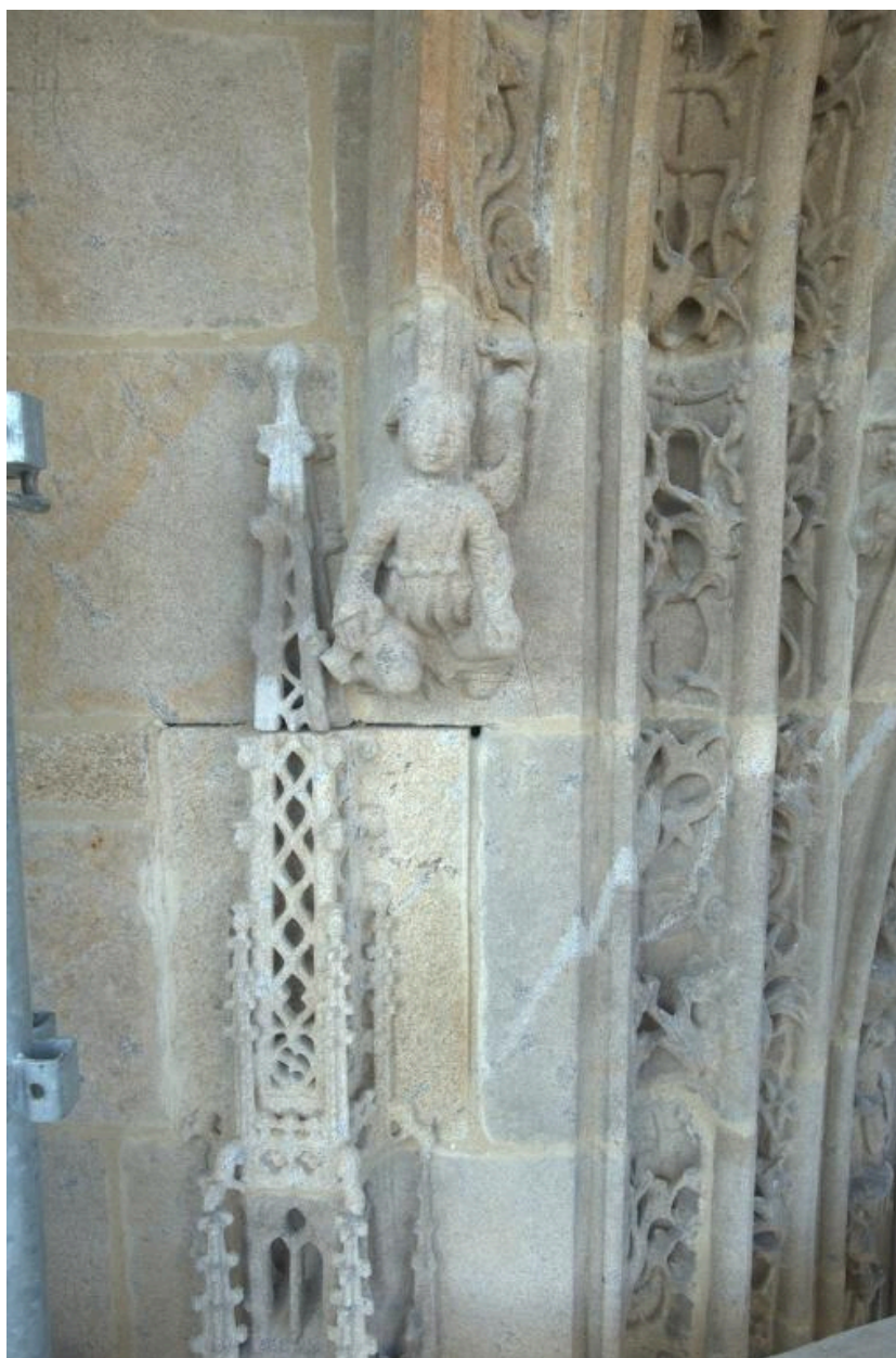
Portail nord. Vue d'une greffe de restauration
