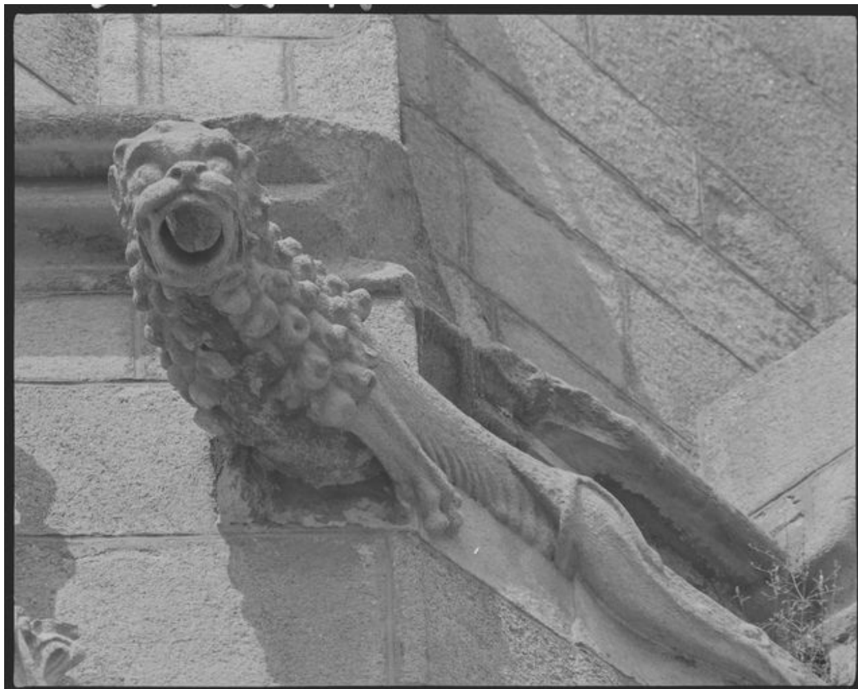
Gargouille, façade sud
