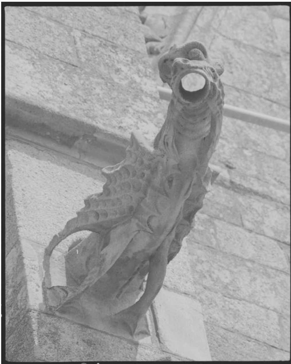
Gargouille, façade sud
