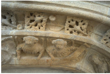
Portail nord, voussure avec anges Phot. Norbert Lambart IVR53_20115600856NUCA
