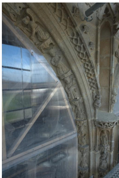
Portail nord. Voussoirs en cours de restauration Phot. Norbert Lambart IVR53_20115600827NUCA
