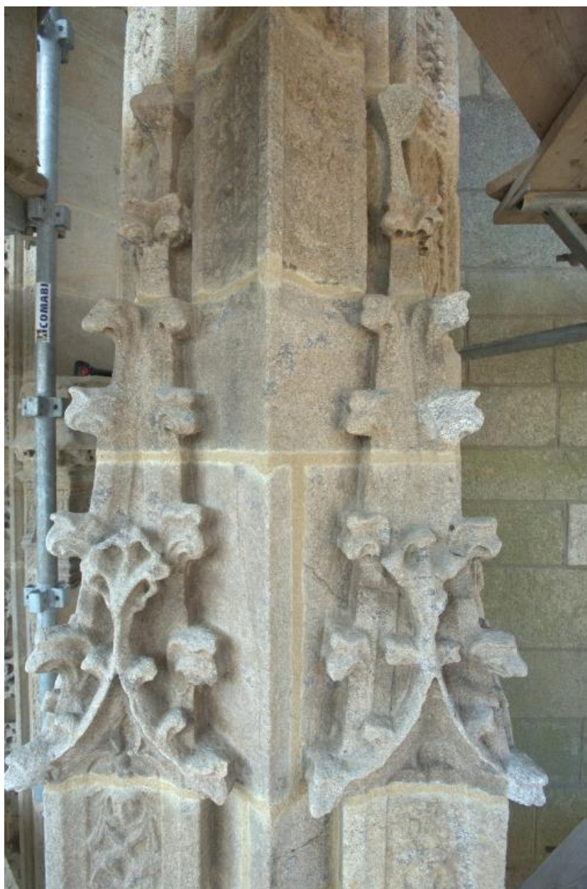
Portail nord, détail de la restauration des pinacles
