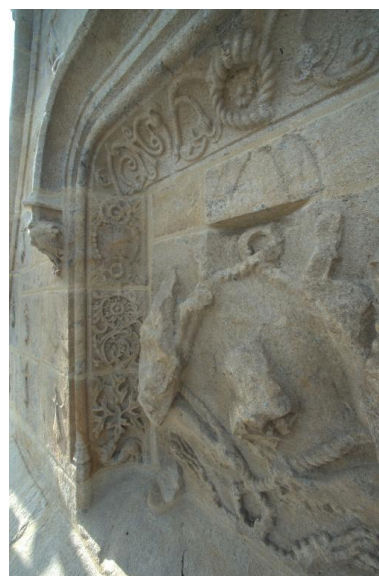
Vue biaise de la niche au sommet du pignon du porche nord Phot. Norbert Lambart IVR53_20115600805NUCA
