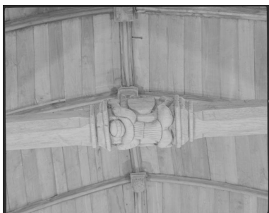
Détail d'un entrait : acrobate Phot. Norbert Lambart IVR53_19845601501X
