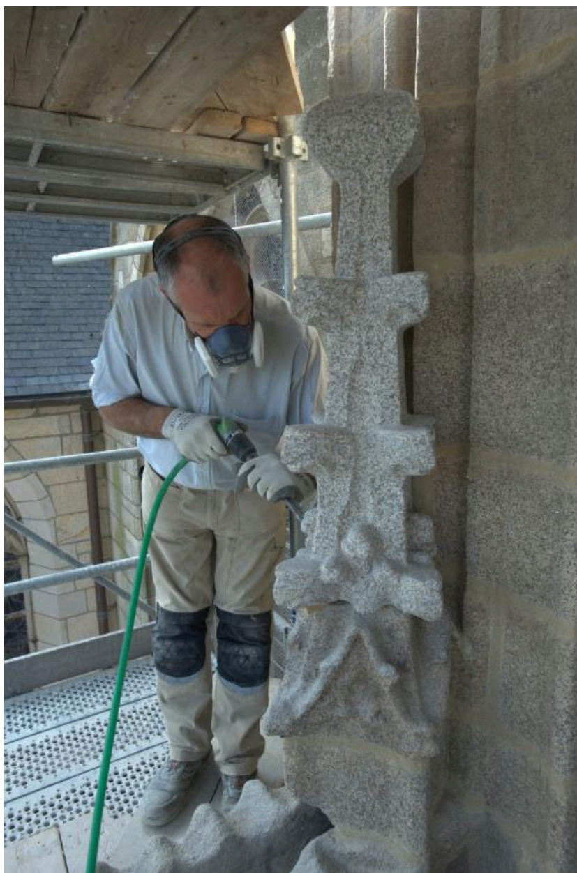
Portail nord, restauration d'un pinacle
