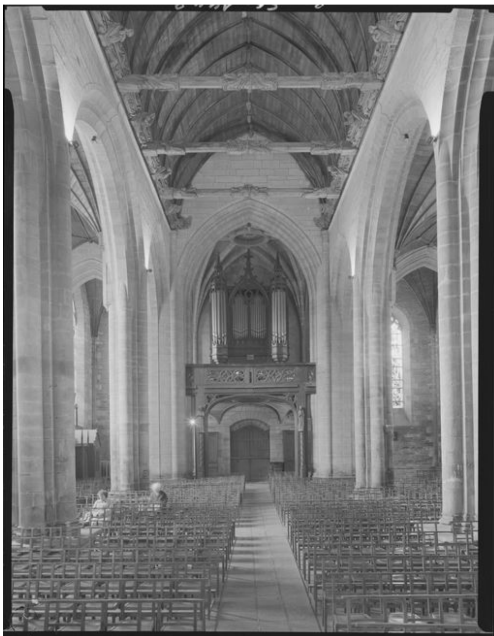
Vue générale vers le choeur
