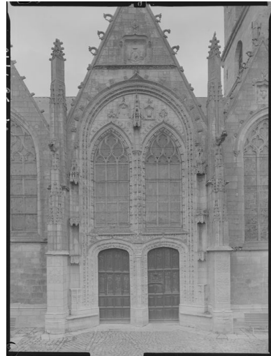
Porche nord vue générale Phot. Norbert Lambart IVR53_19845601446V
