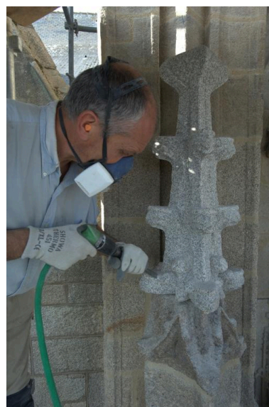
Portail nord, restauration d'un pinacle Phot. Norbert Lambart IVR53_20115600826NUCA
