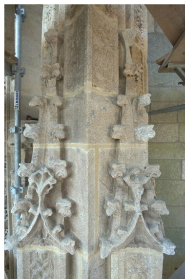
Portail nord, détail de la restauration des pinacles Phot. Norbert Lambart IVR53_20115600838NUCA
