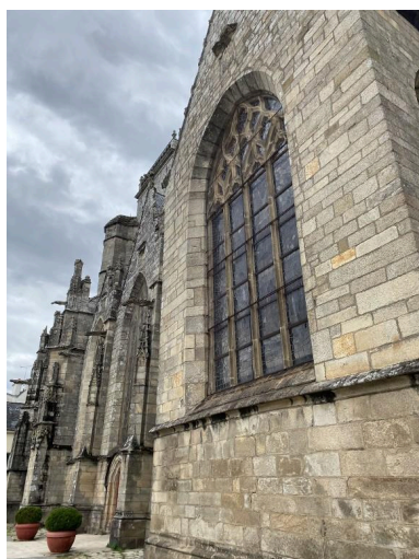
Vue sud-est Phot. Baptiste Oligo IVR53_20255611030NUCA
