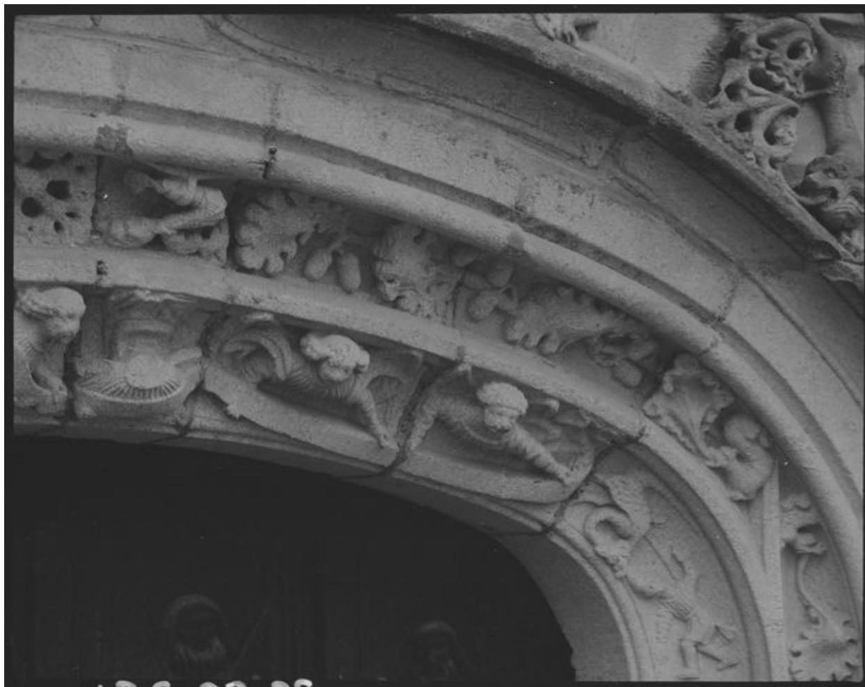
Porche nord, gauche, détail de l'arc
