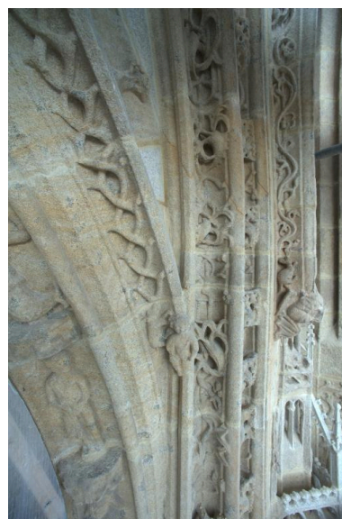
Portail nord, détail retombée des voûtures Phot. Norbert Lambart IVR53_20115600815NUCA
