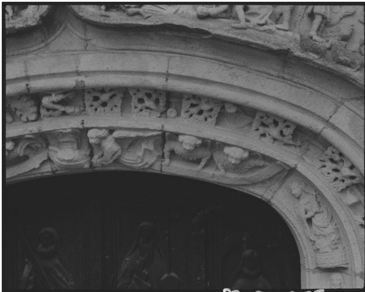
Porche nord, gauche, détail de l'arc
