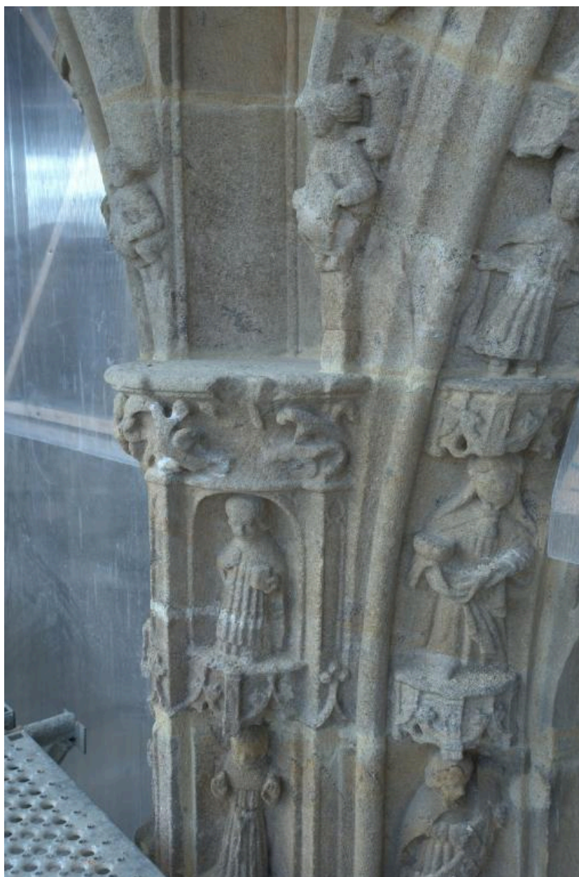
Portail nord, détail voussures des fenêtres
