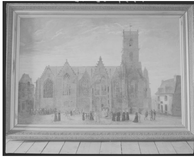
Elévation sud : vue générale (tableau, fin 19e siècle) Autr. Ferdinand Combes IVR53_19845601644X
