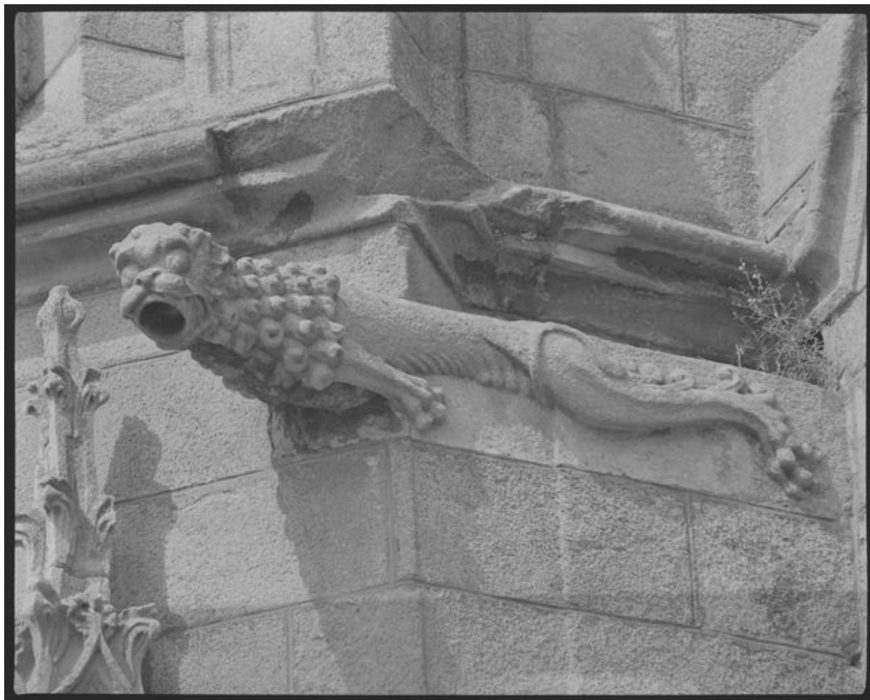
Gargouille, façade sud
