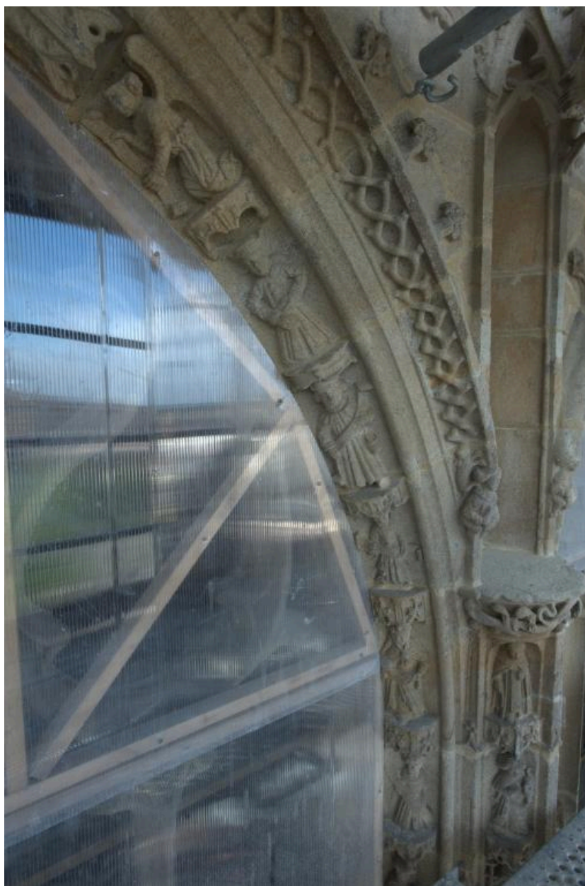
Portail nord. Voissures en cours de restauration
