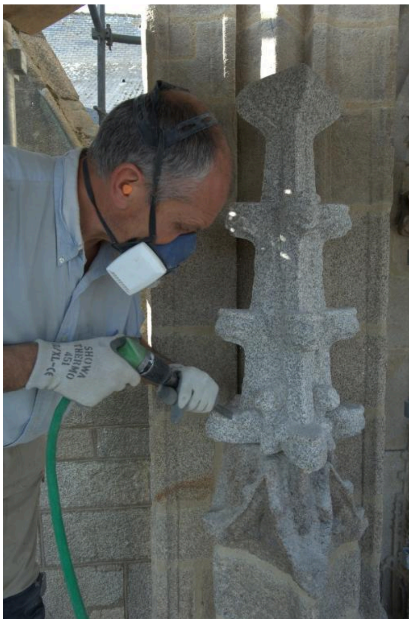
Portail nord, restauration d'un pinacle
