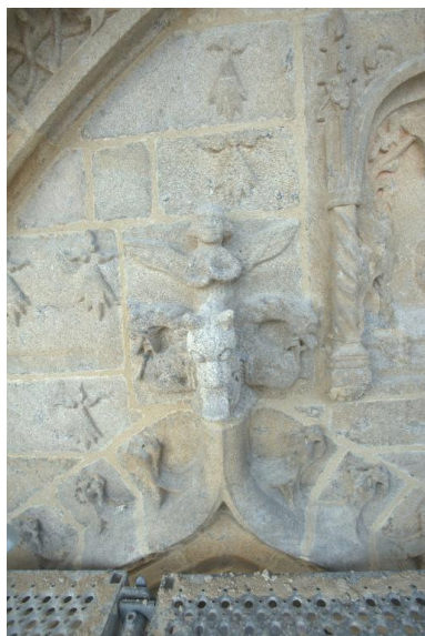
Porche nord détail fleuron et semis d'hermines Phot. Norbert Lambart IVR53_20115600810NUCA
