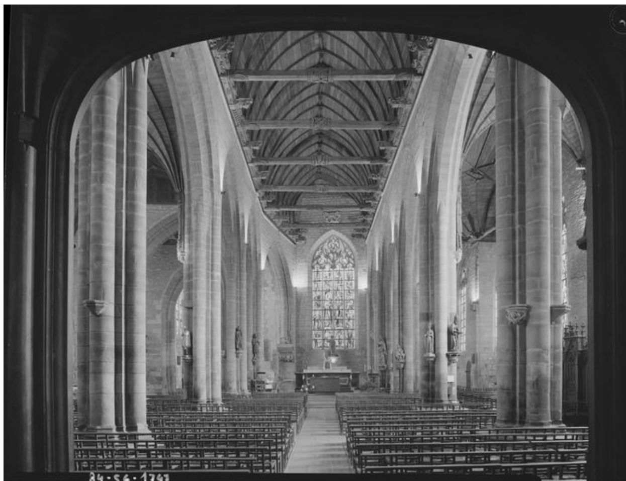
Vue générale vers le choeur
