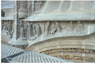
Portail nord. Adoration des mages et adoration des bergers Phot. Norbert Lambart IVR53_20115600842NUCA
