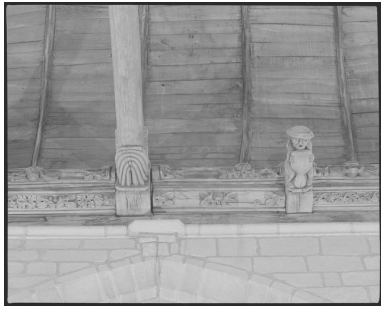
Sablières et blochet : côté nord Phot. Norbert Lambart IVR53_19845601500X
