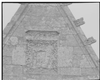
Elévation sud : blason Phot. Norbert Lambart IVR53_19855600229X
