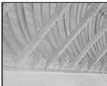
Sablières et entrait Phot. Norbert Lambart IVR53_19845601611X
