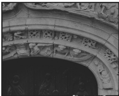
Porche nord, gauche, détail de l'arc Phot. Norbert Lambart IVR53_19855600755X
