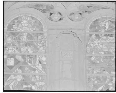
Verrière de la baie 16, date du meneau : 1556 Phot. Norbert Lambart IVR53_19855600227X
