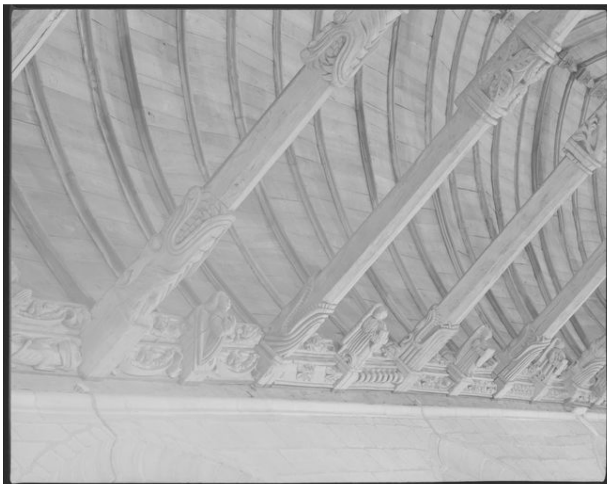
Sablières et entrait
