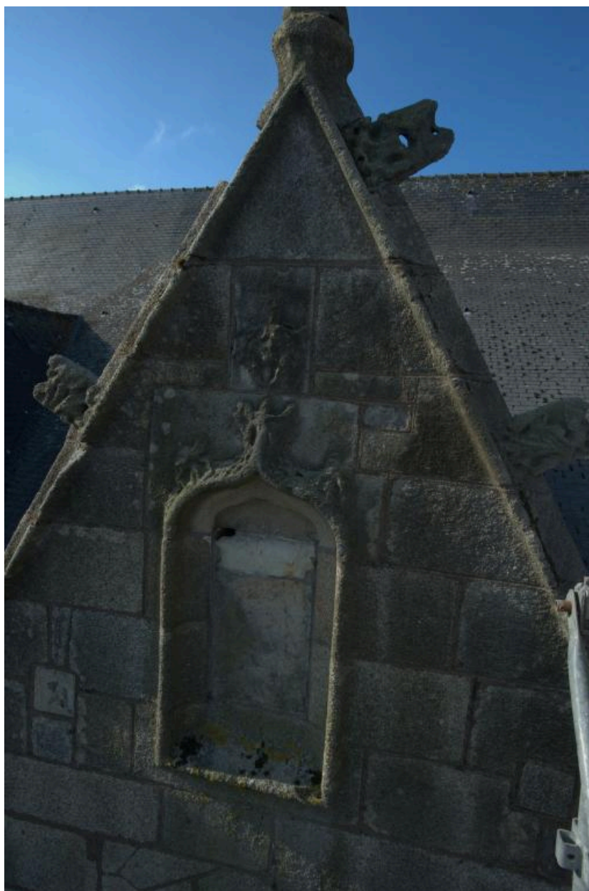
Détail d'un pignon de l'élévation nord
