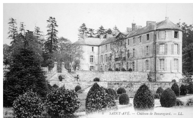
Vue générale Phot. Elise Lauranceau IVR53_20045606199NUCB
