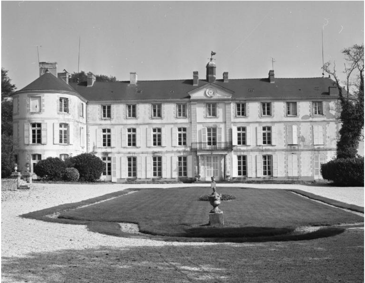
Vue générale de la façade ouest
