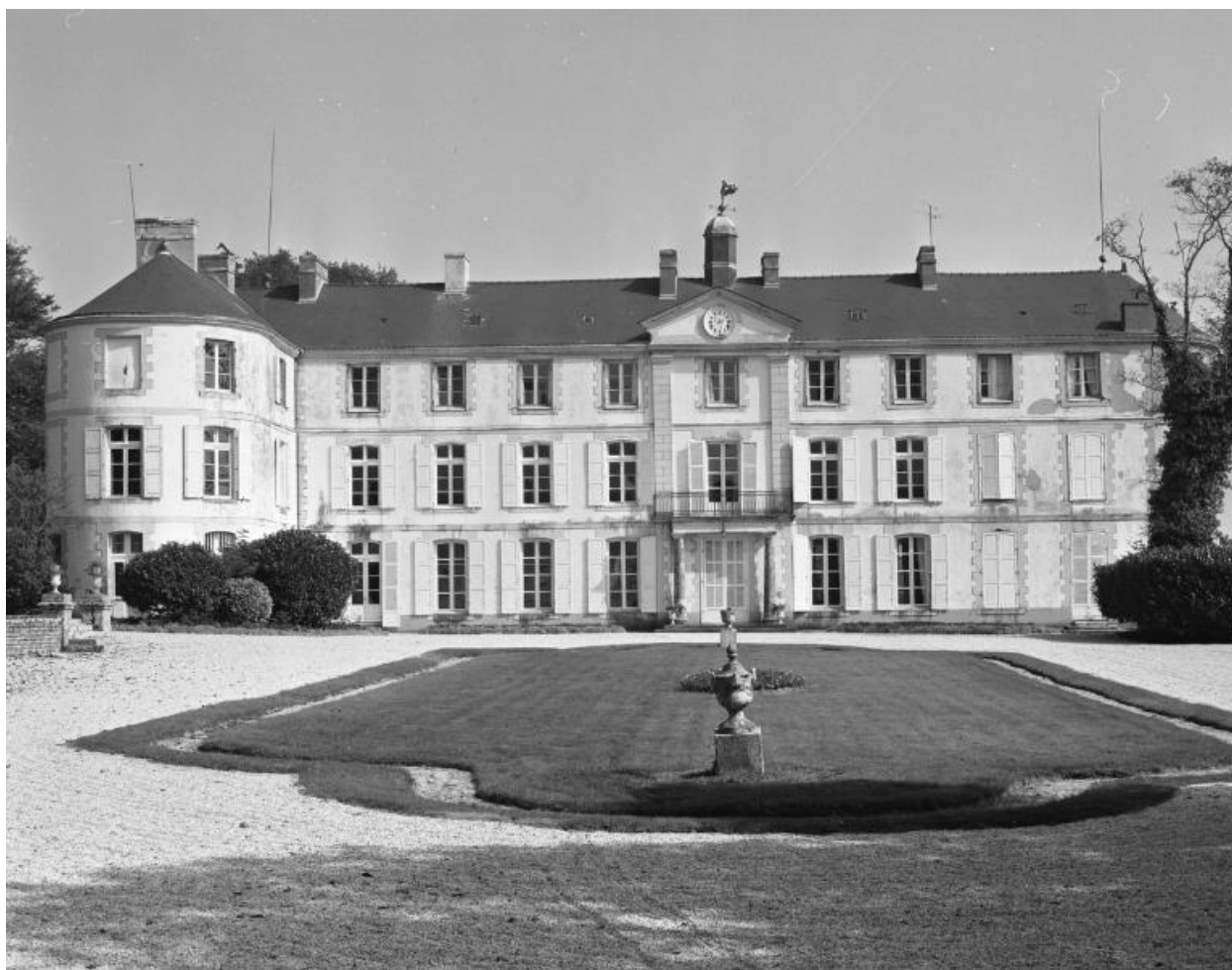
Vue générale de la façade ouest
