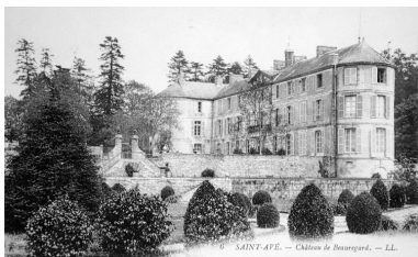
Vue générale Phot. Elise Lauranceau IVR53_20045606199NUCB
