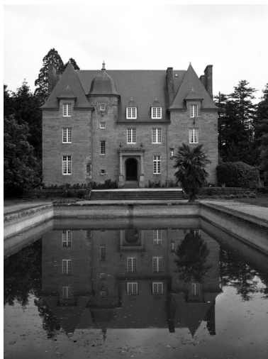
Vue générale : état en 1986 Phot. Norbert Lambart IVR53_19855600736V
