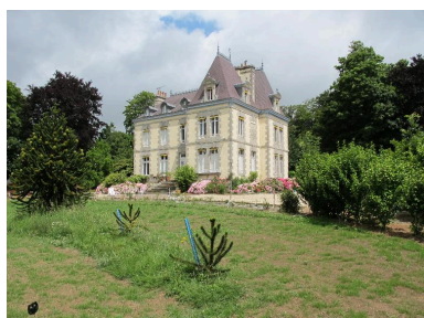
Vue générale prise de trois quart, depuis le jardin Phot. Véronique Orain IVR53_20162206961NUCA
