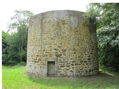
Colombier, vue générale Phot. Véronique Orain IVR53_20162206965NUCA
