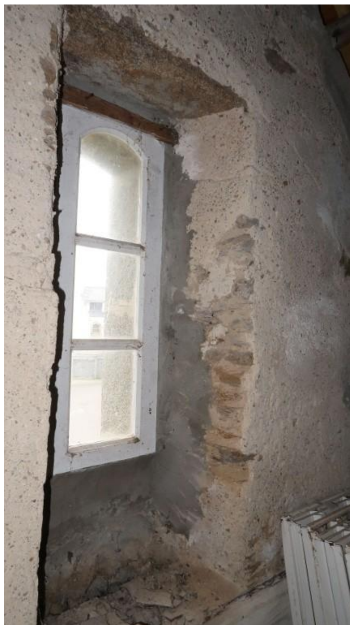
Abri de canot de sauvetage, ouverture en pignon de l'étage de combles
