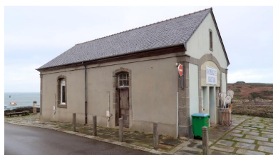
Abri de canot de sauvetage, élévation sud Phot. Erwana L'Haridon IVR53_20242910168NUCA
