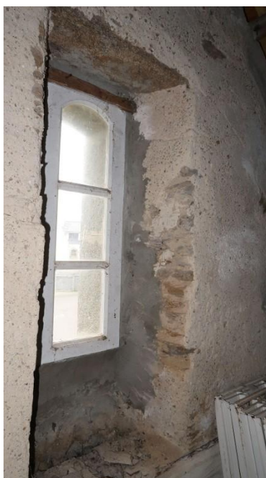
Abri de canot de sauvetage, ouverture en pignon de l'étage de combles Phot. Erwana L'Haridon IVR53_20242910169NUCA
