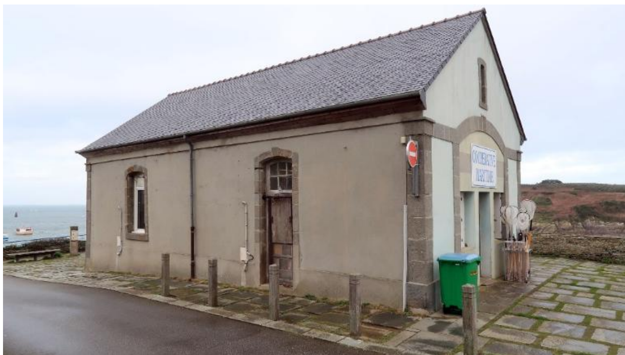
Abri de canot de sauvetage, élévation sud
