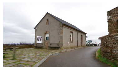
Abri de canot de sauvetage Phot. Erwana L'Haridon IVR53_20242910173NUCA
