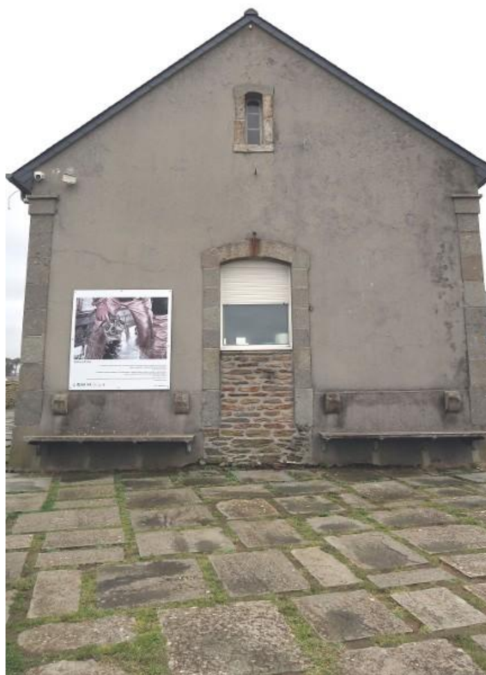
Abri de canot de sauvetage, élévation ouest
