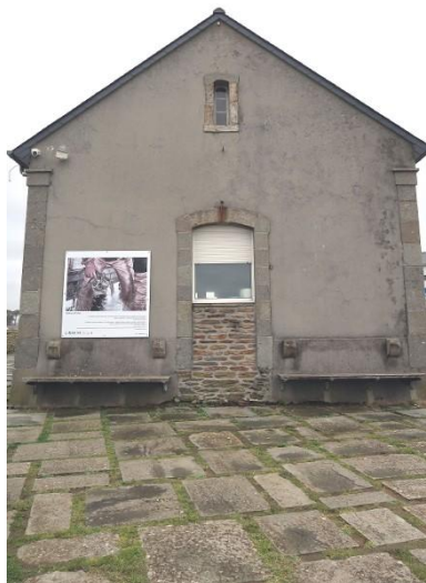
Abri de canot de sauvetage, élévation ouest Phot. Erwana L'Haridon IVR53_20242910172NUCA
