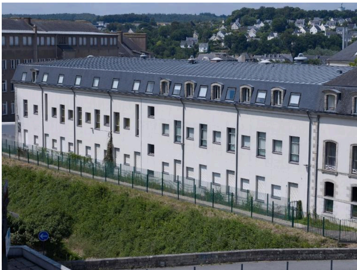
Façade du bâtiment A1 (externat et gymnase), côté voie ferrée, reconstruit en 1989-1990 (H. L'Hyver, architecte).
