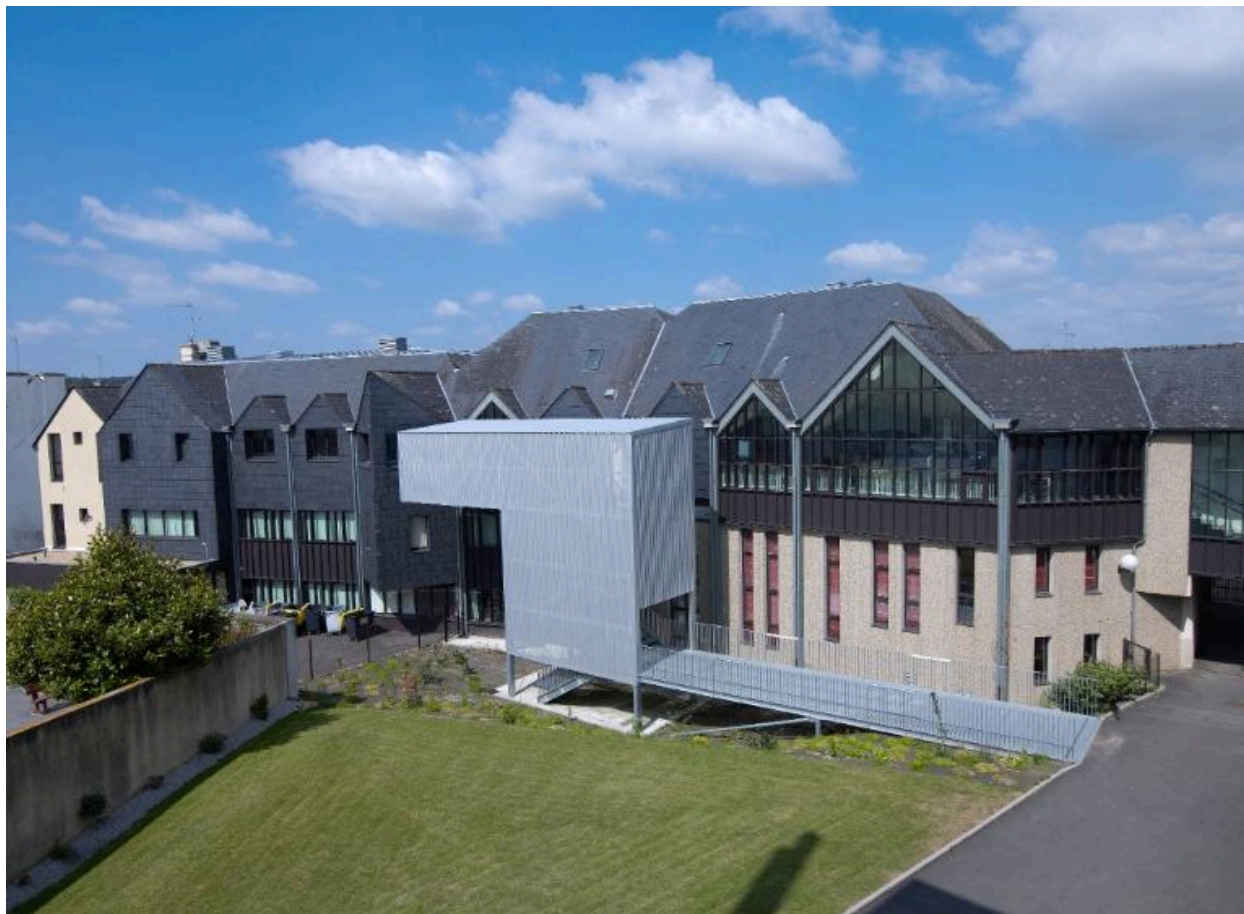
Façade sur cour du bâtiment N (septembre 1986 à septembre 1987, H. l'Hyver, architecte). La mise au norme de sécurité a conduit à l'adjonction plus récente d'un escalier métallique.
