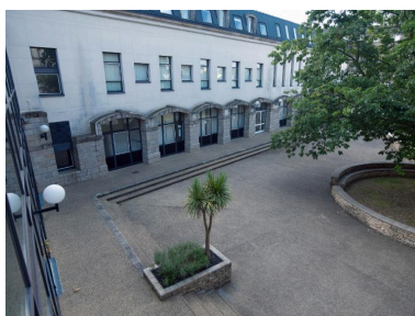
Façade sur cour du bâtiment A1 (externat et gymnase), reconstruit en 1989-1990 (H. L'Hyver, architecte). Il conserve les proportions des autres bâtiments et l'encadrement en pierre de taille des arcades du rez-de-chaussée Phot. Bernard Bègne
