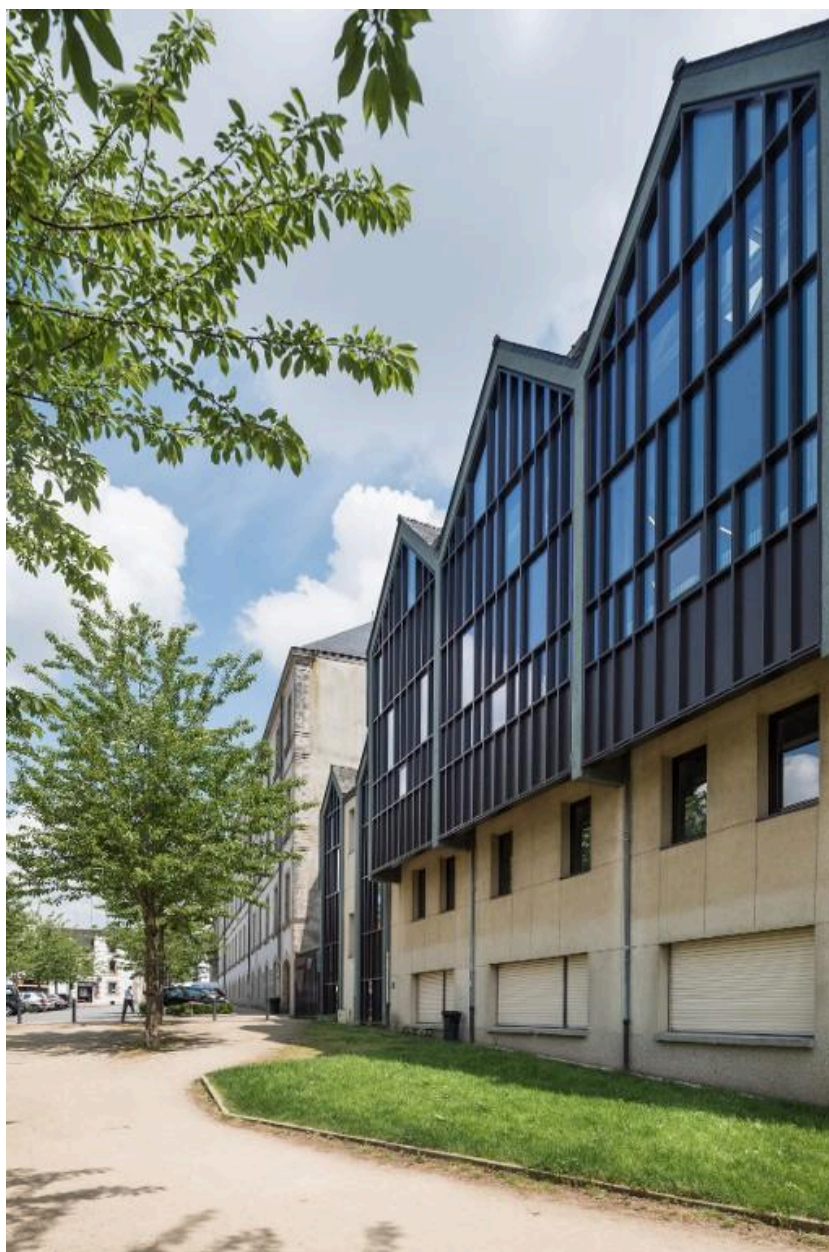
Façade sur rue du bâtiment N (réfectoire et salles de cours de sciences), Hervé L'Hyver, architecte, 1986-87. Vue prise du sud-ouest.
