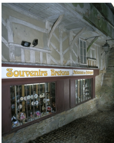
Contreventement du premier étage sud par des chevrons et ouverture de deux baies. Phot. Bernard Bègne IVR53_20012900432XA
