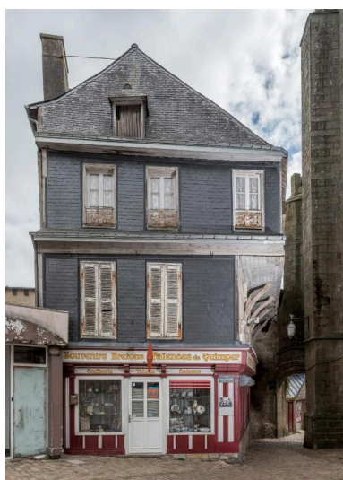
Un essentage d'ardoises masque le pan de bois en façade ouest. Phot. Charlotte Barraud IVR53_20222900522NUCA
