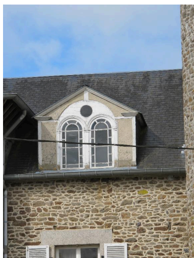
Logis, détail, façade arrière : lucarne Phot. Véronique Orain IVR53_20162206912NUCA
