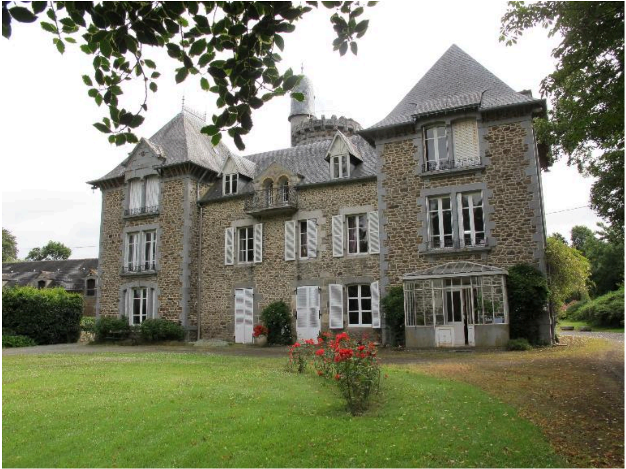
Logis : vue générale de trois quart de la façade antérieure
