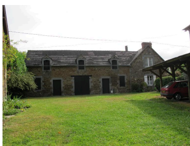
Communs Phot. Véronique Orain IVR53_20162206916NUCA
