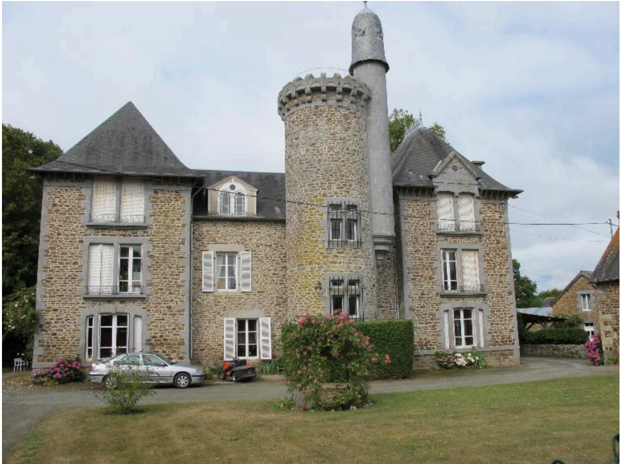
Logis : façade postérieure
