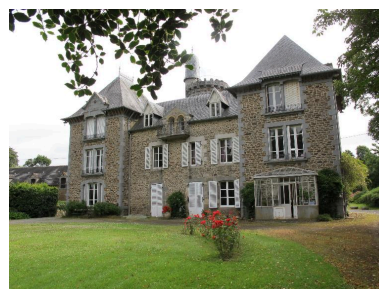
Logis : vue générale de trois quart de la façade antérieure Phot. Véronique Orain IVR53_20162206907NUCA
