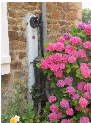
Logement secondaire, détail pompe extérieure, fonderie Briau, Tours Phot. Véronique Orain IVR53_20162206914NUCA
