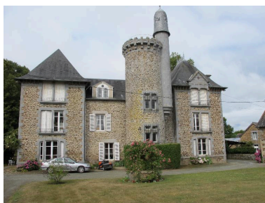
Logis : façade postérieure Phot. Véronique Orain IVR53_20162206910NUCA
