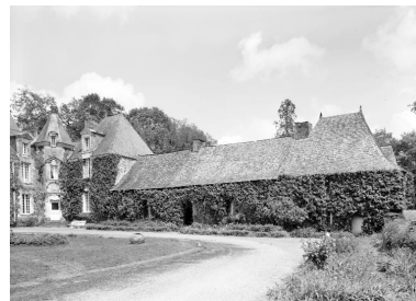
Château, logis et aile sud : élévation ouest (état en 1983) Phot. Norbert Lambart IVR53_19835600824V
