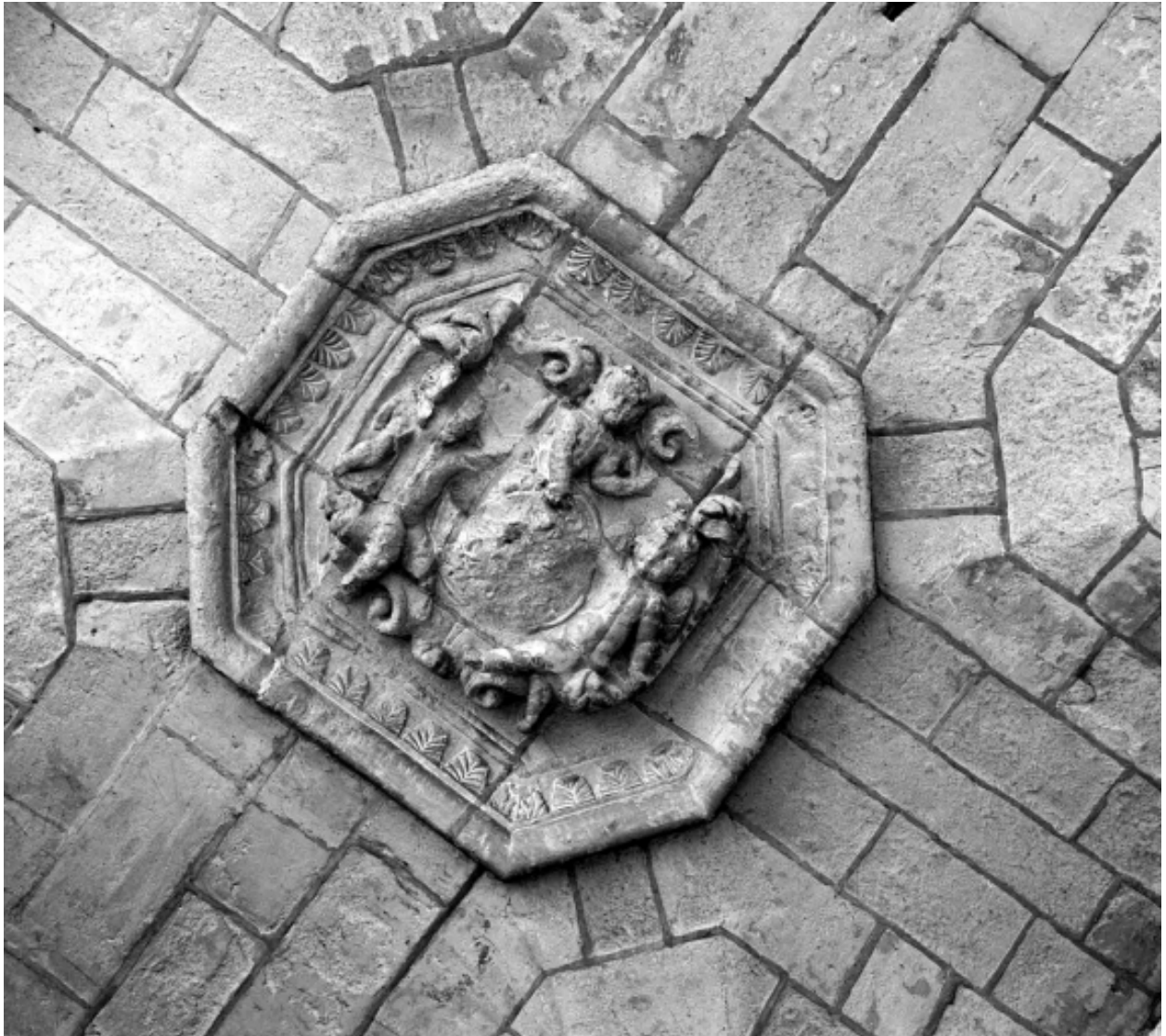
Cloître, détail sur le médaillon de la voûte
