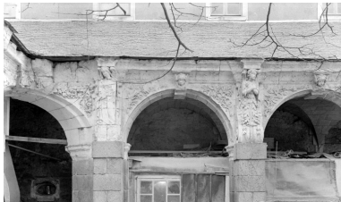
Détail sur la neuvième arcade ouest Phot. Guy Artur, Phot. Norbert Lambart IVR53_19653500054V
