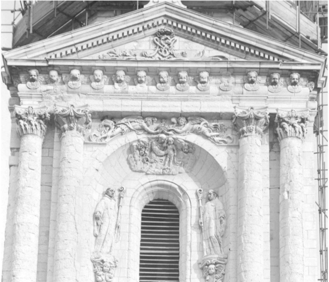
Elévation ouest du clocher, partie basse
