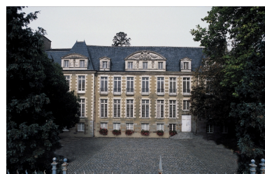
Vue de situation prise du sud Phot. Guy Artur IVR53_20033501839XA
