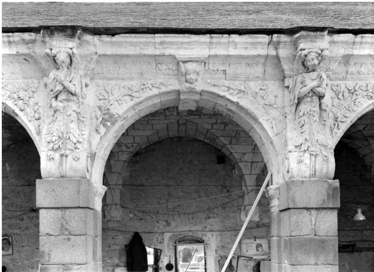
Détail sur la troisième arcade ouest
