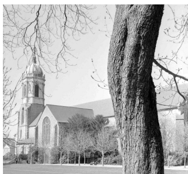
Vue de l'église depuis le sud-est, détail Phot. Guy Artur, Phot. Norbert Lambart IVR53_19953500218X
