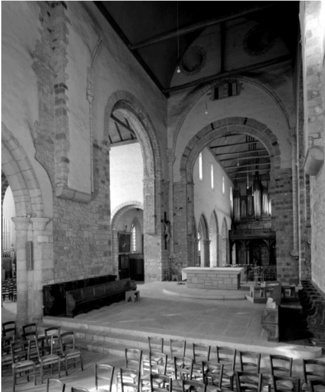
Vue générale de la croisée du transept
