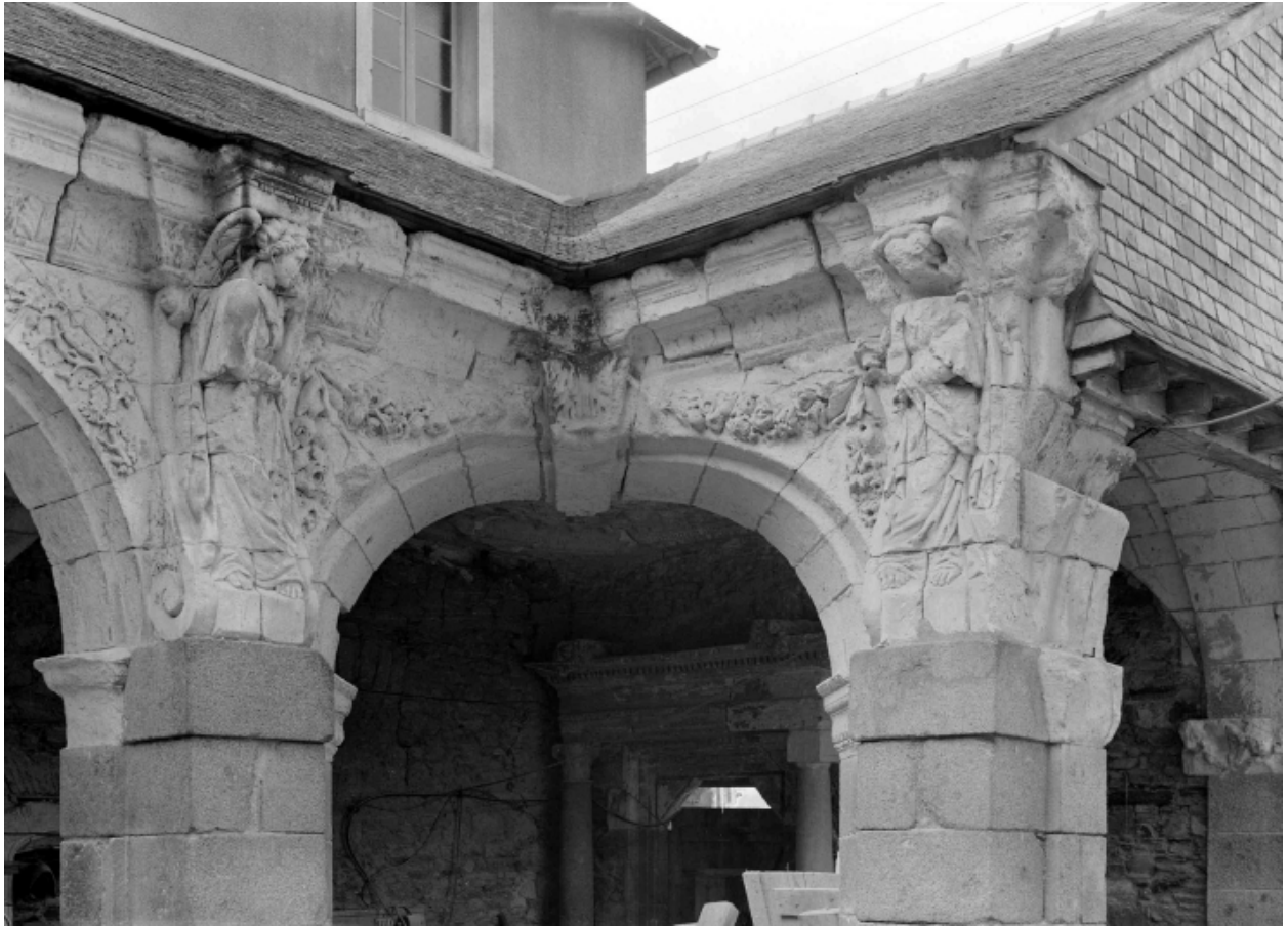
Détail sur l'angle sud-ouest du cloître
