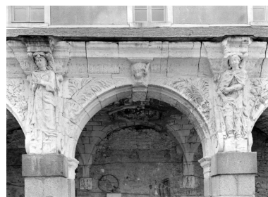
Détail sur la cinquième arcade ouest Phot. Guy Artur, Phot. Norbert Lambart IVR53_19653500050V
