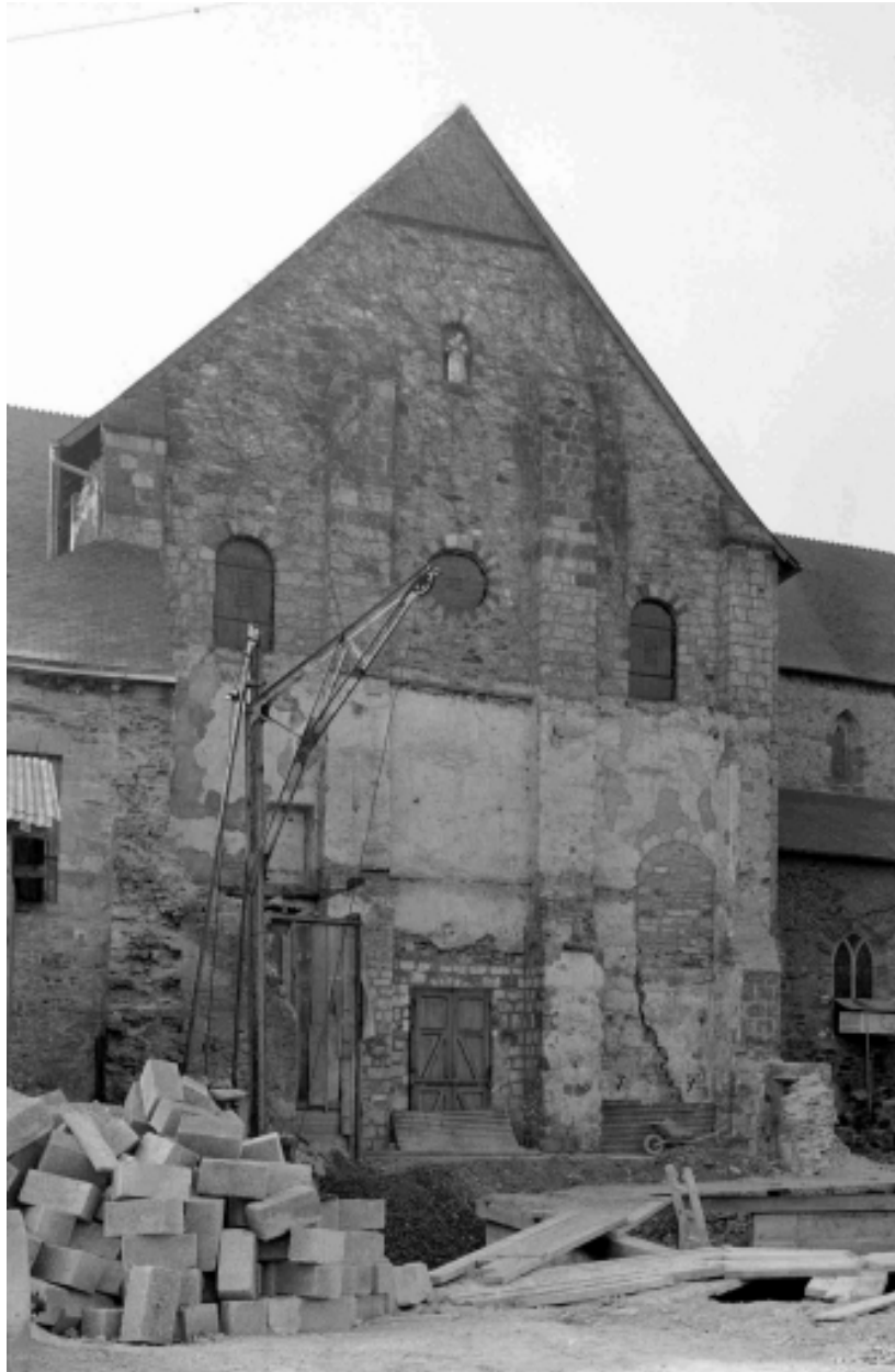
Détail sur la façade sud du transept
