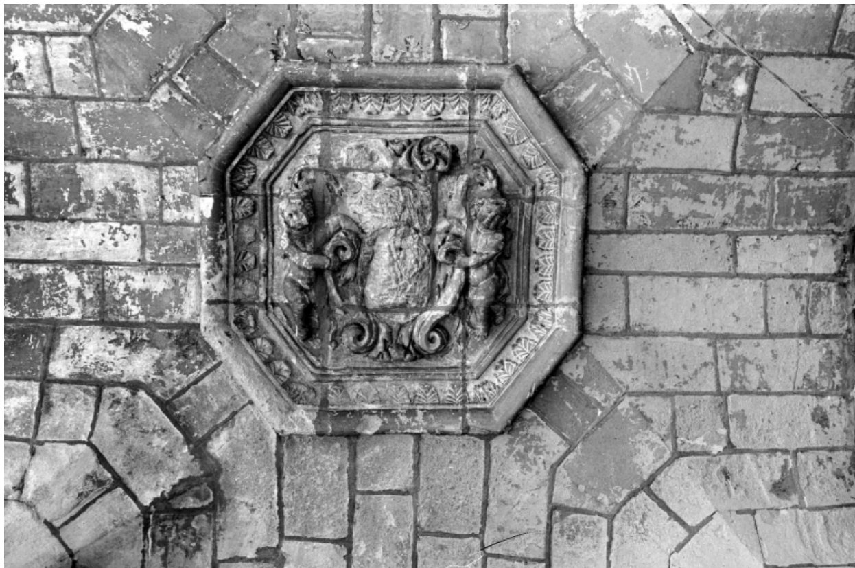
Cloître, détail sur le médaillon de la voûte
