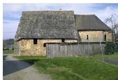
Vue générale sud ; état en 1994 Phot. Claude Quillivic IVR53_19943502452ZA
