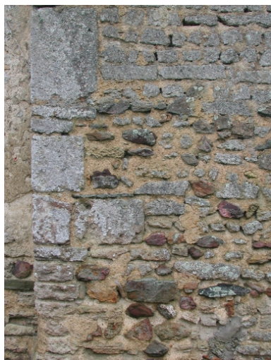
Détail ; chaînage d'angle en calcaire coquillier Phot. Claude Quillivic IVR53_20033508260NUCA
