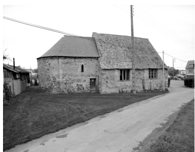
Vue générale nord ; état en 1992 Phot. Bernard Bègne, Phot. M. Loyon IVR53_19923500865X
