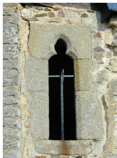
Détail ; fenêtre Phot. Malo Pichot IVR53_20023518587NUCA
