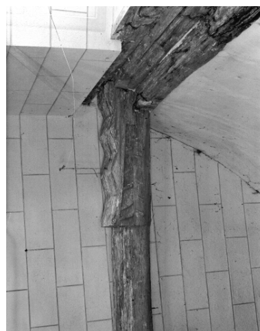
Vue intérieure ; détail, entrait sculpté Phot. Bernard Bègne, Phot. M. Loyon IVR53_19923500872X
