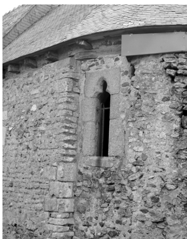
Détail ; fenêtre sud est Phot. Bernard Bègne, Phot. M. Loyon IVR53_19923500867X
