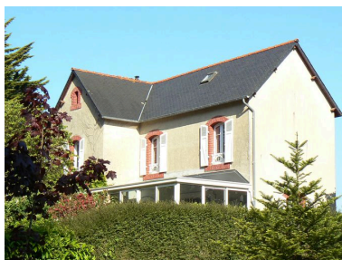
Vue de trois-quarts de la villa Les Goëlands
