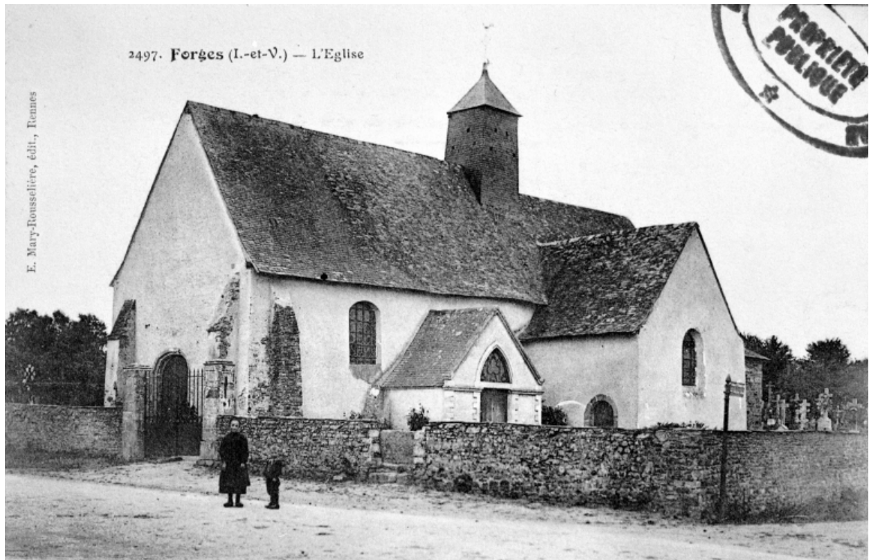
Elévation sud-ouest : vue générale.
