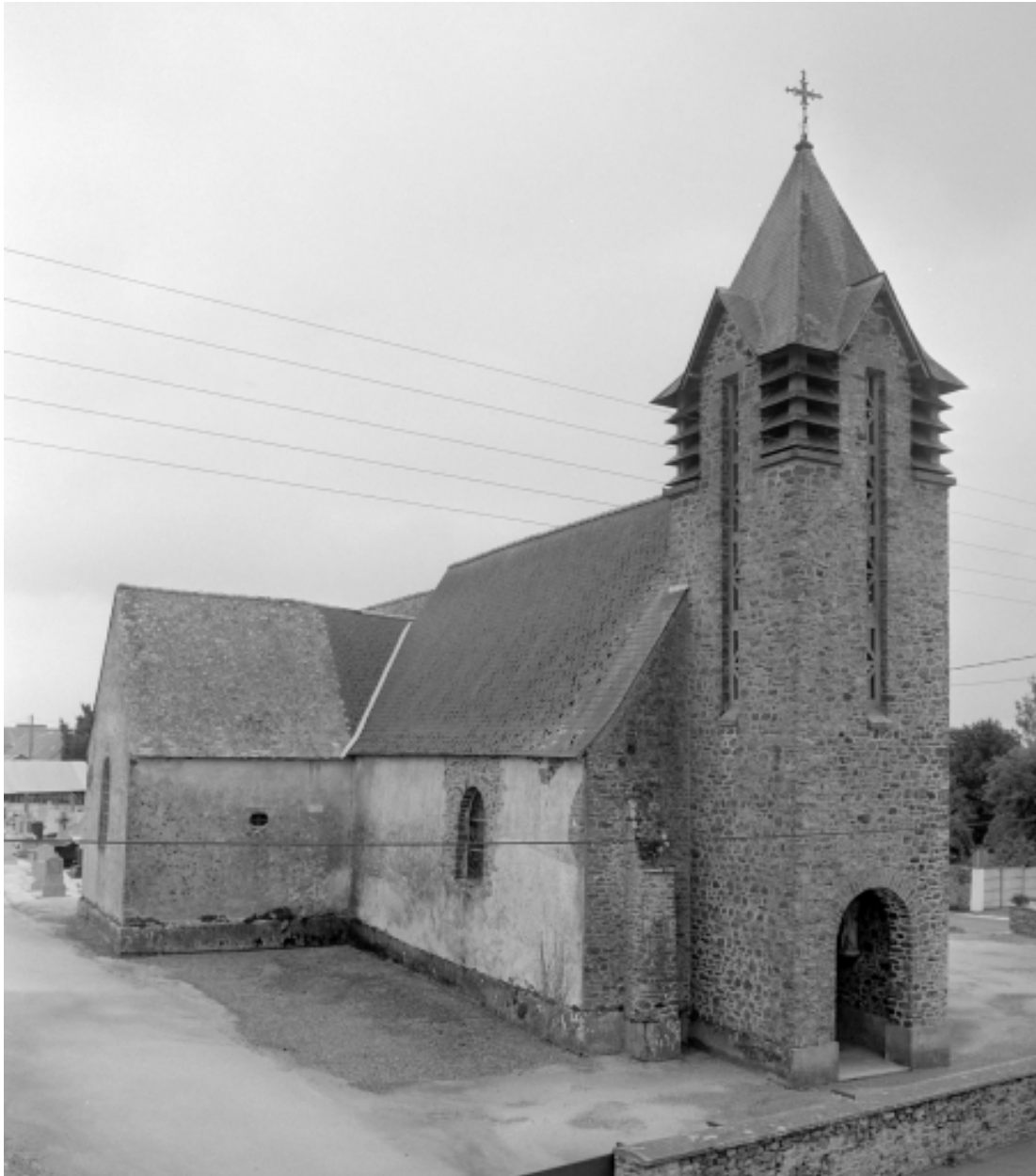
Elévation nord-ouest : vue générale
