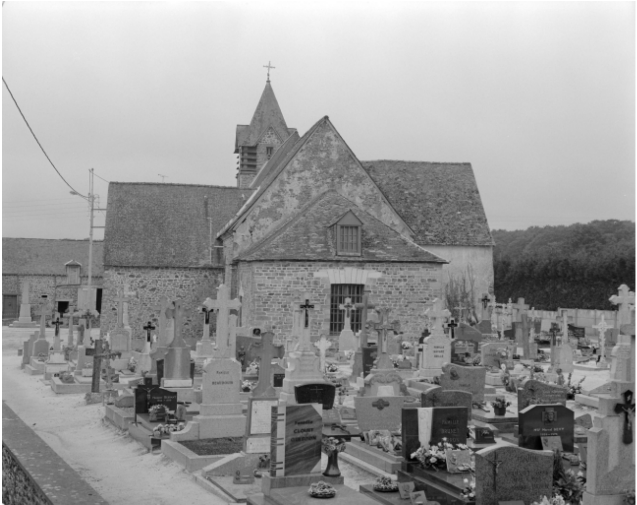
Elévation est : vue générale
