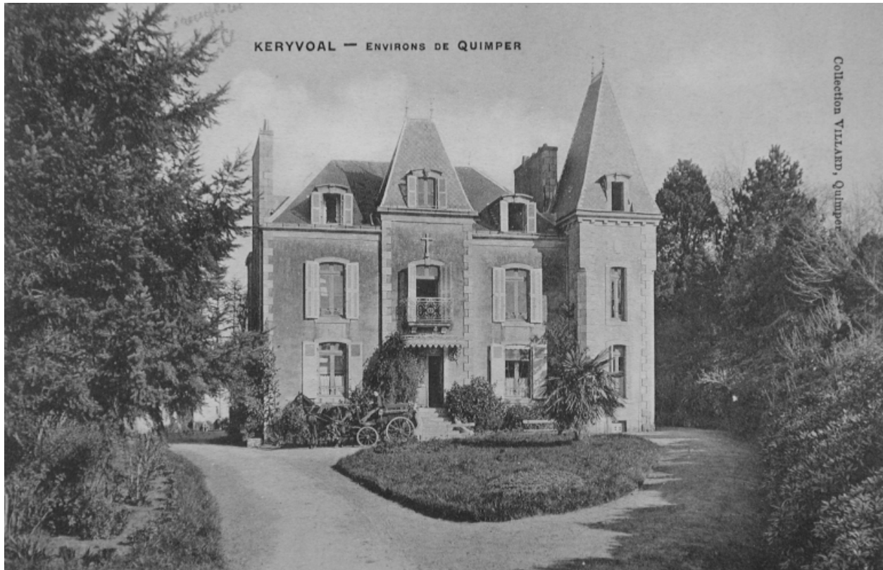
Vue générale de la façade principale
