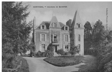
Vue générale de la façade principale Phot. Elise Lauranceau, Autr. Villard IVR53_20032902769NUCB
