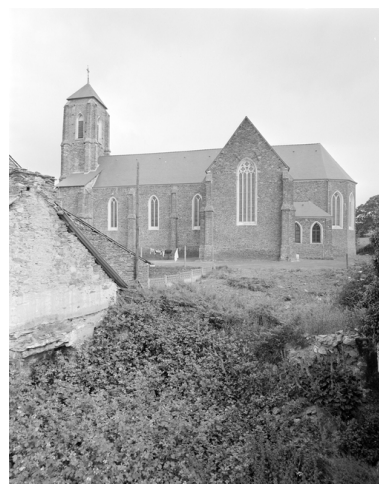
Vue générale sud-est Phot. Guy Artur, Phot. Norbert Lambart IVR53_19943501033X
