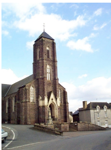
Le clocher : vue générale nord-ouest Phot. Xavier Gilbert IVR53_19993503905NUCA
