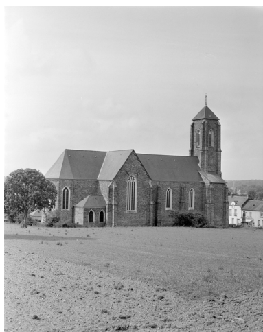
Vue générale nord-est Phot. Guy Artur, Phot. Norbert Lambart IVR53_19943501032X
