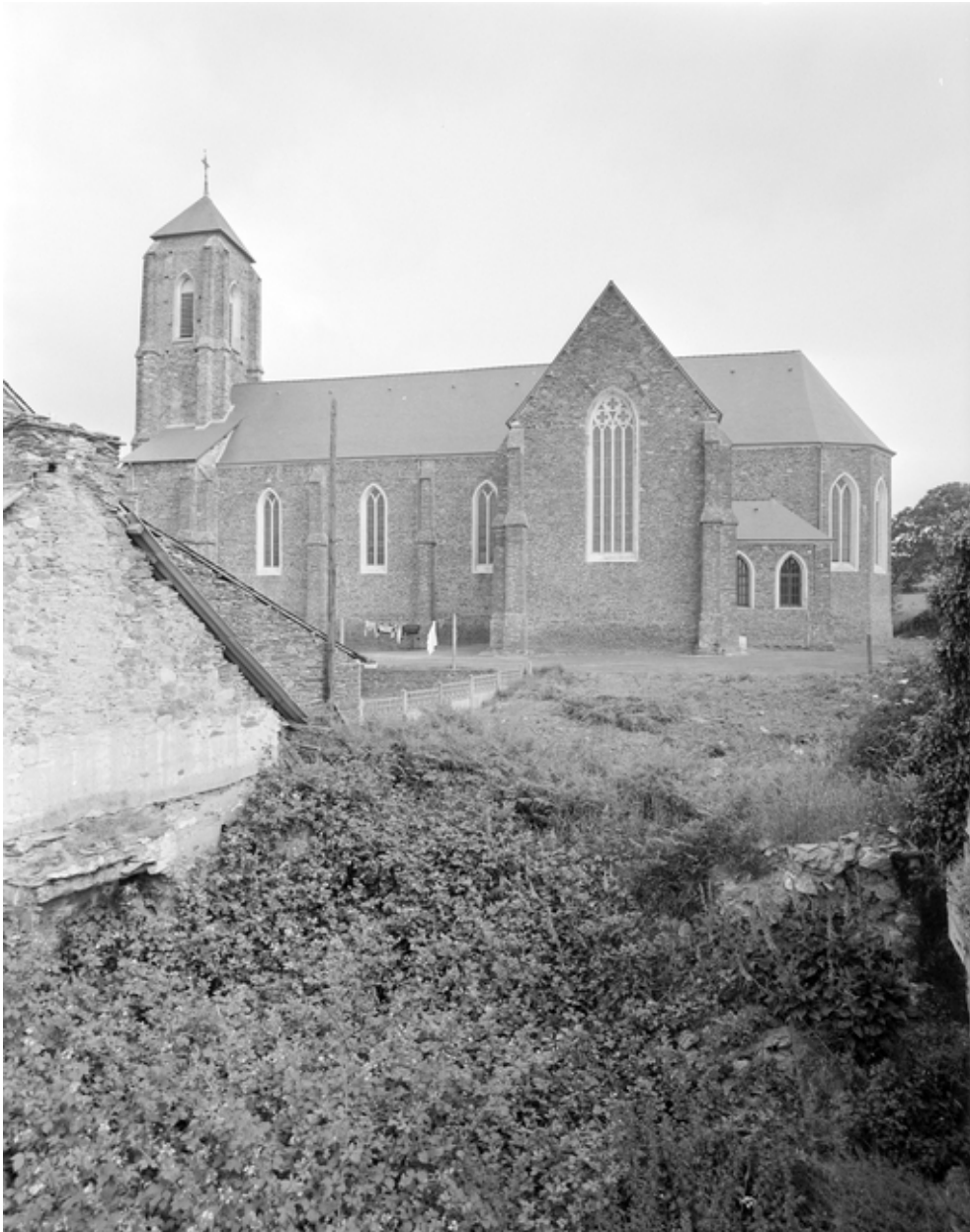
Vue générale sud-est
