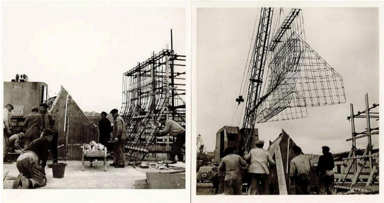
Photographies des travaux, ferrailage des brise-lames en béton cyclopéen
