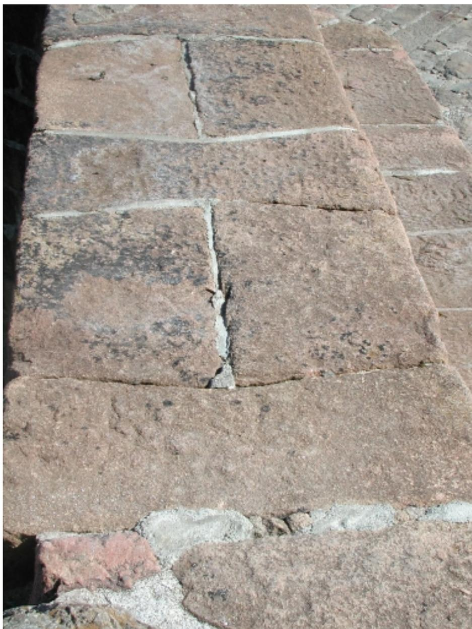
Détail : disposition des pierres de taille de la première jetée ou digue (granite de Bréhat)
