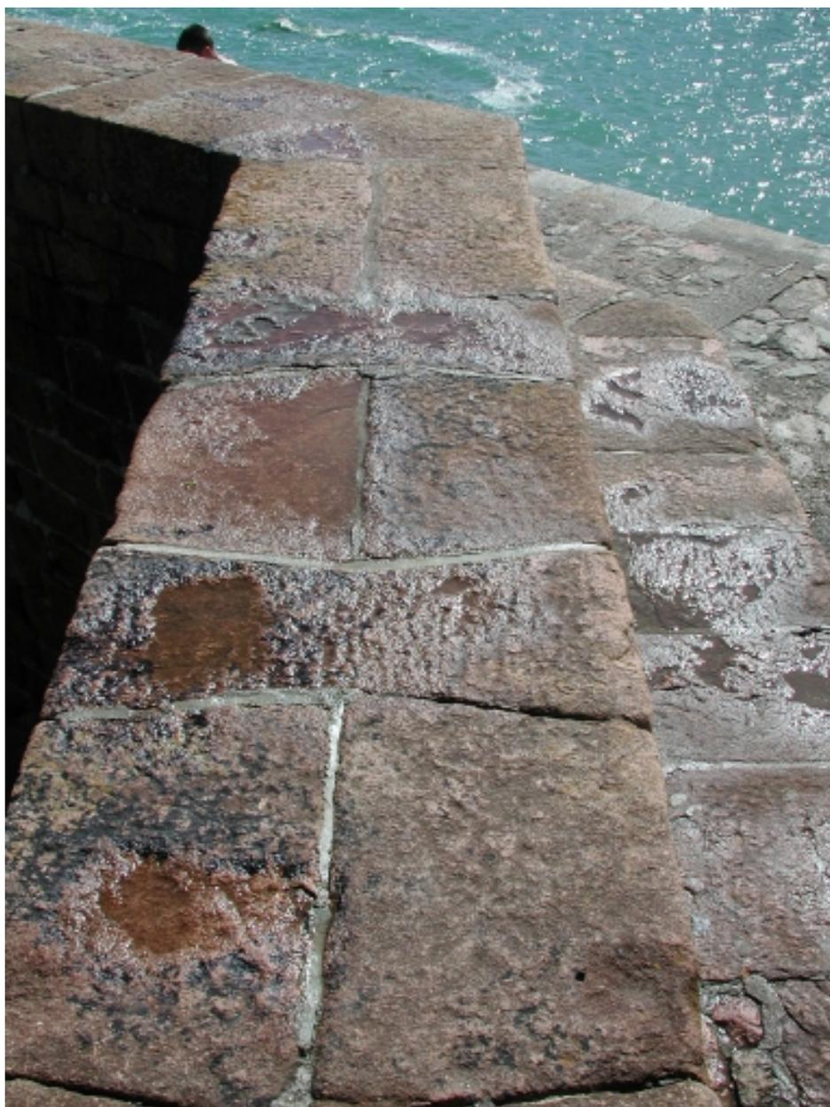
Détail : assemblage des pierres de taille utilisées pour le couvrement de la digue et le pavage
