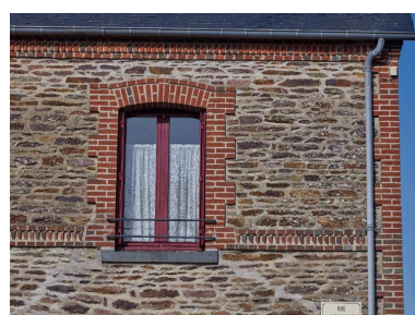
Détail encadrement de fenêtre en brique Phot. Bernard Bègne IVR53_20263500238NUCA
