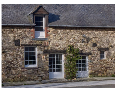
Détail ferme du bourg Phot. Bernard Bègne IVR53_20263500249NUCA
