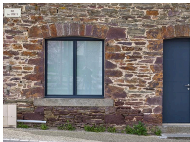
Détail arc segmentaire Phot. Bernard Bègne IVR53_20263500523NUCA
