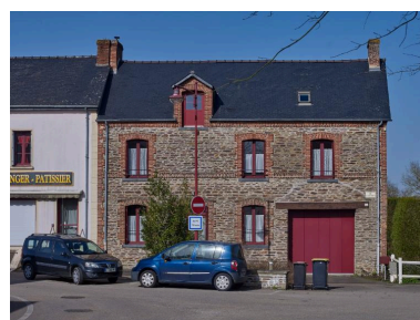
Maison 15 rue du vieux bourg Phot. Bernard Bègne IVR53_20263500236NUCA
