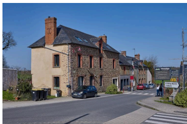
alignement rue des calvaires Phot. Bernard Bègne IVR53_20263500229NUCA
