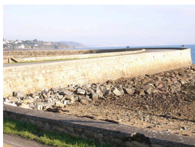
Vue générale de la digue-route de Quéléren Phot. Guillaume Marie IVR53_20072908951NUCA
