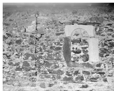
Sacristie nord, porte du 16e siècle en remploi : détail Phot. Bernard Bègne, Phot. Marc Loyon IVR53_19933500014X
