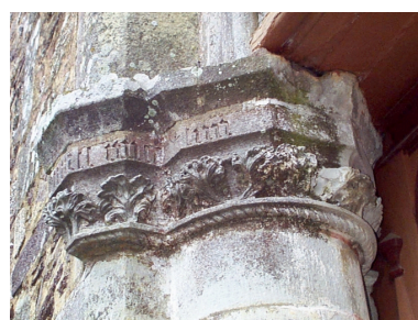
Porche occidental, chapiteau nord portant une inscription en lettres gothiques : détail Phot. Xavier Gilbert IVR53_19993505146NUCA
