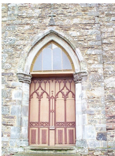
Arcature du 15e siècle employée en guise de porche : vue générale ouest Phot. Xavier Gilbert IVR53_19993505233NUCA
