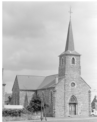
L'église et le presbytère : vue de situation ouest Phot. Guy Artur, Phot. Norbert Lambart IVR53_19943501056X
