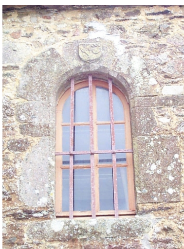
Sacristie nord, fenêtre du 16e siècle sculptée d'un blason : détail Phot. Xavier Gilbert IVR53_19993505148NUCA
