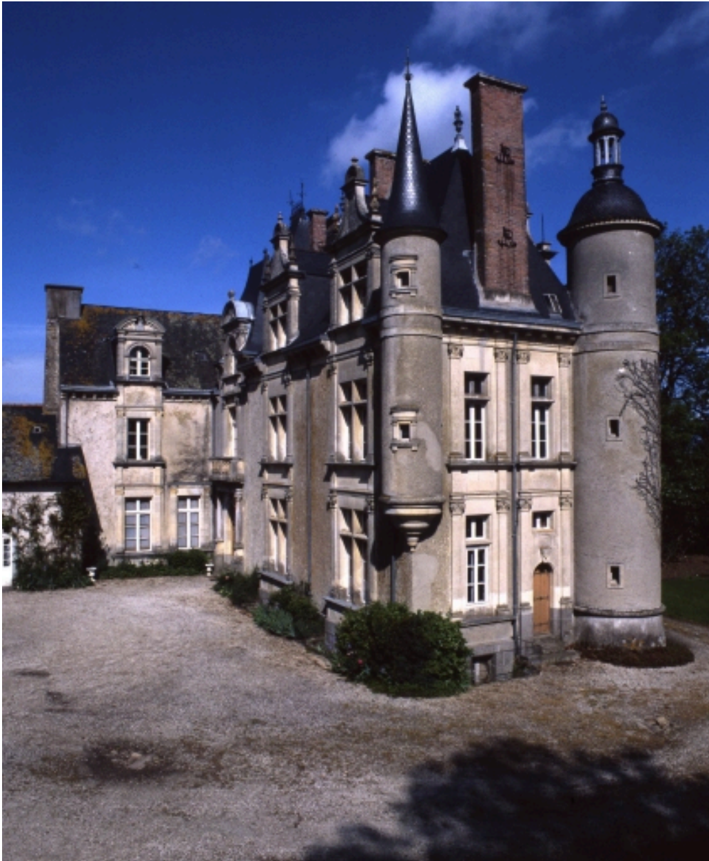
Vue générale du pignon est
