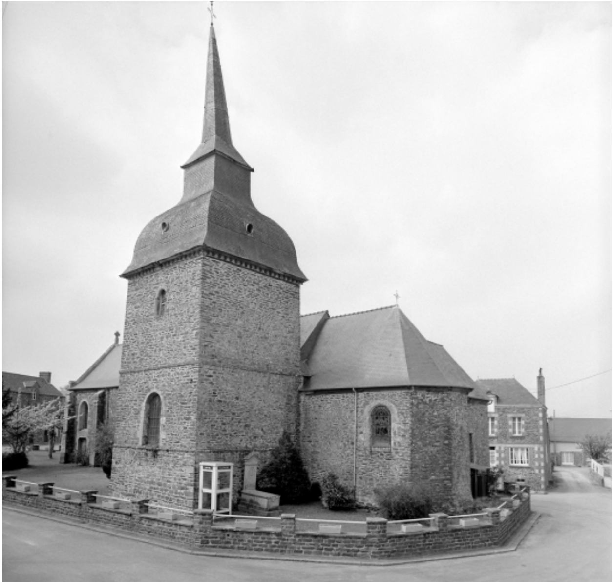
Elévation Est : vue générale
