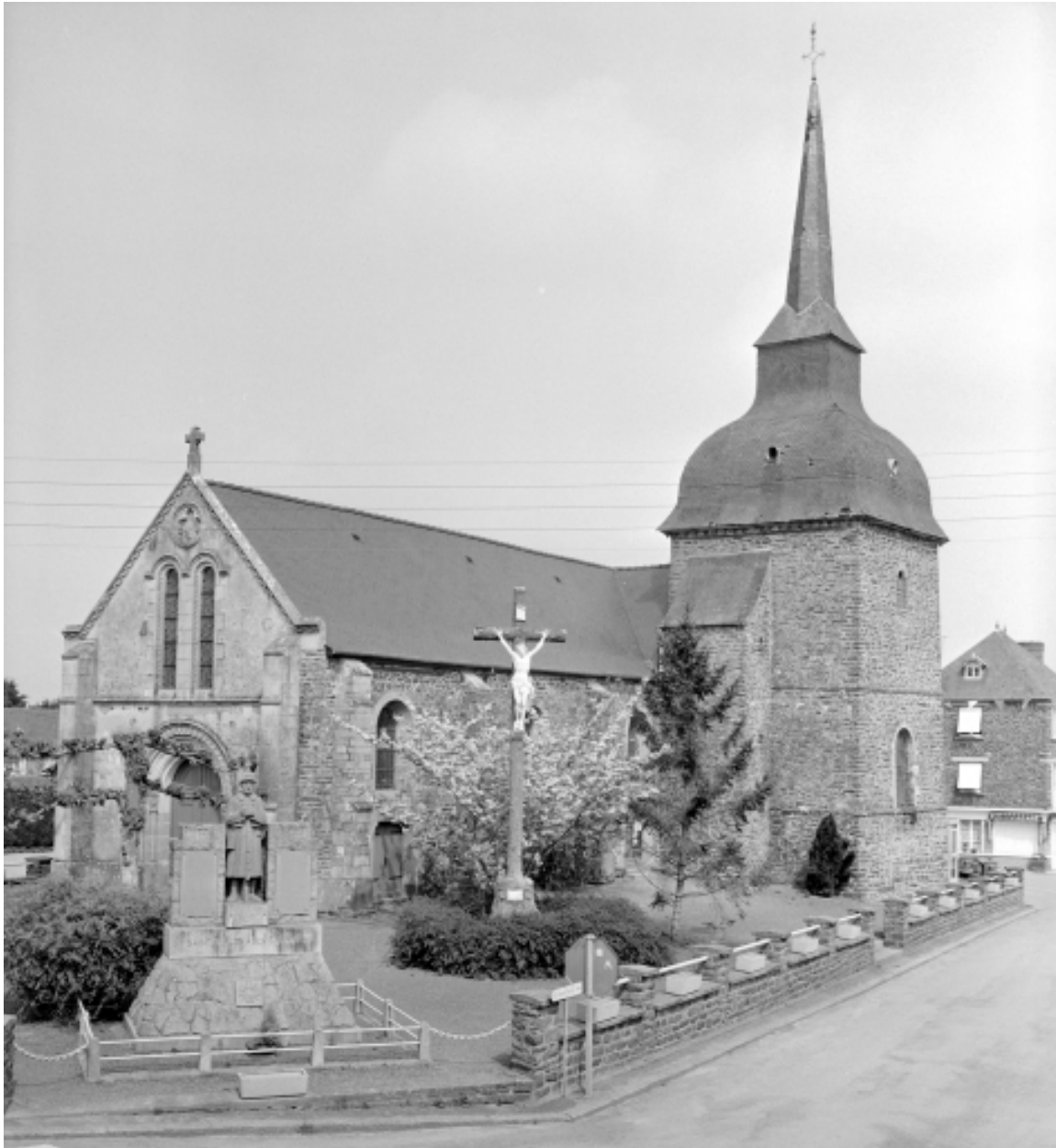
Elévation Sud-Ouest : vue générale
