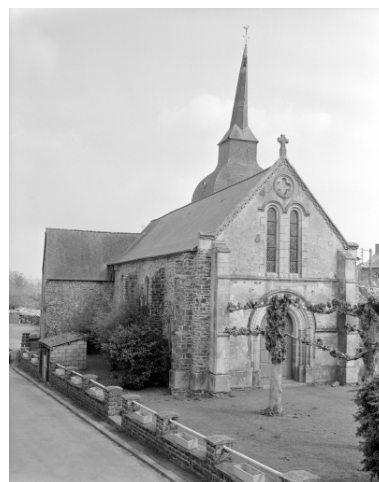
Elévation Ouest : vue générale Phot. Guy Artur, Phot. Norbert Lambart IVR53_19943500808X
