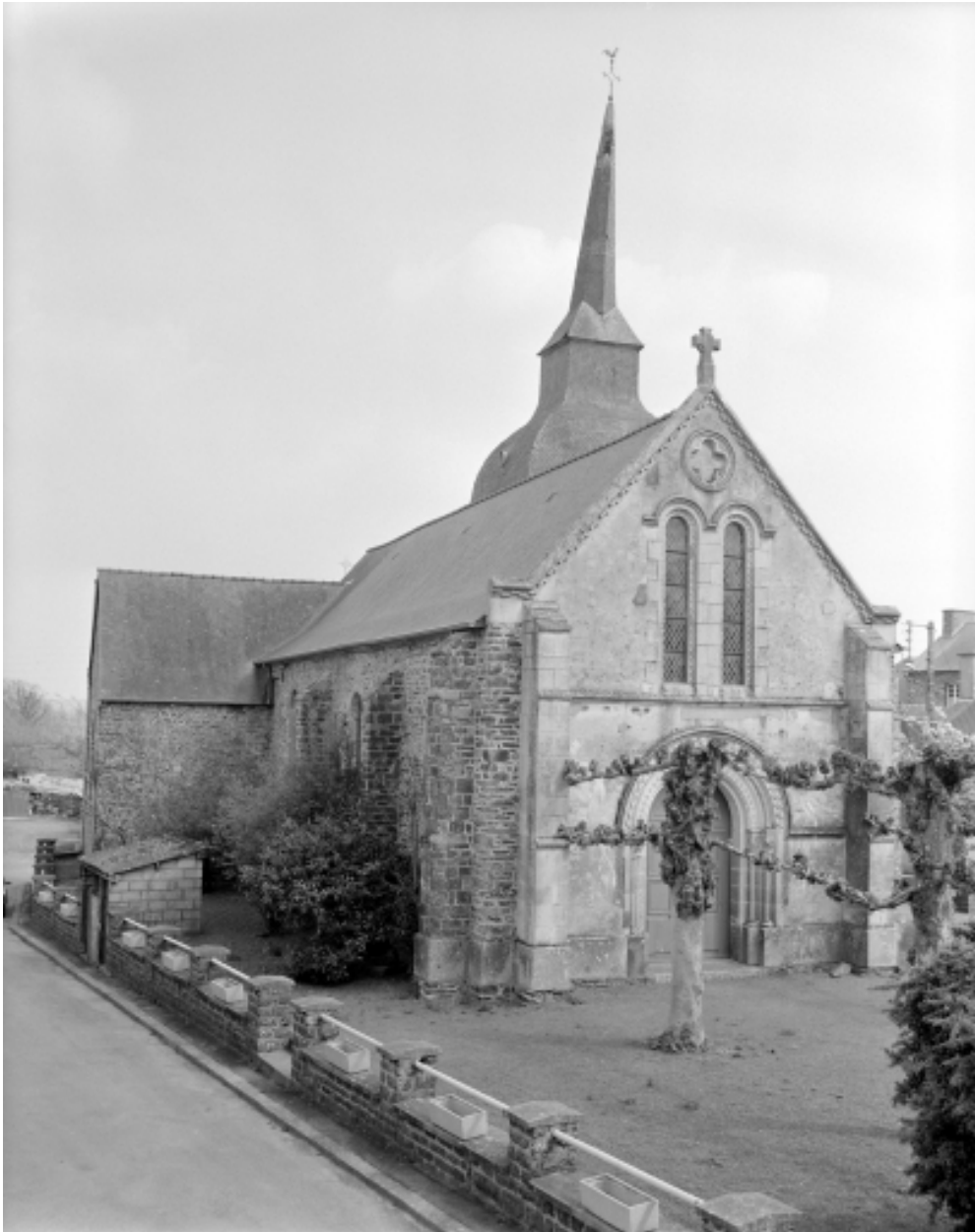
Elévation Ouest : vue générale
