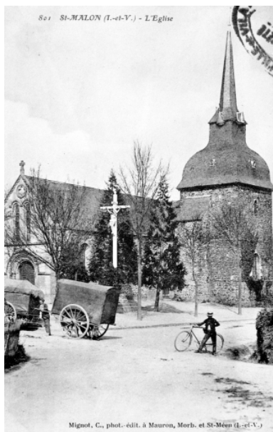
Vue générale Elévation Sud-Ouest : vue générale (Carte postale ancienne, AD35 : 6Fi) Phot. Guy Artur, Phot. Norbert Lambart IVR53_19933500897X
