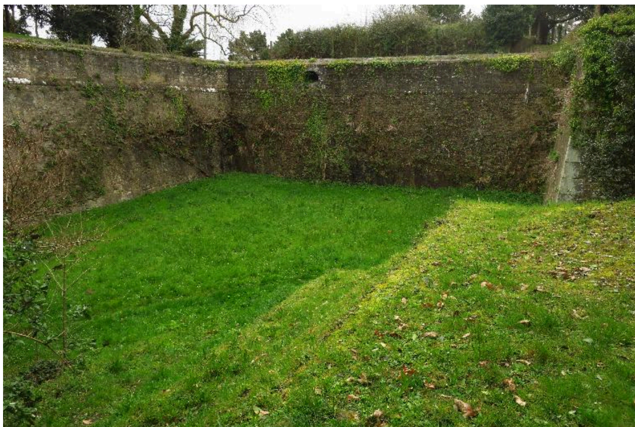
Le Palais, enceinte urbaine, bastion 21, flanc droit, jonction avec la courtine 21-22.
