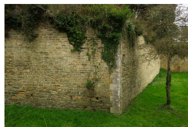
Le Palais, enceinte urbaine, bastion 21, angle du flanc et de la face gauche, dérangement dans la maçonnerie. Phot. Lionel Duigou IVR53_20175608351NUCA
