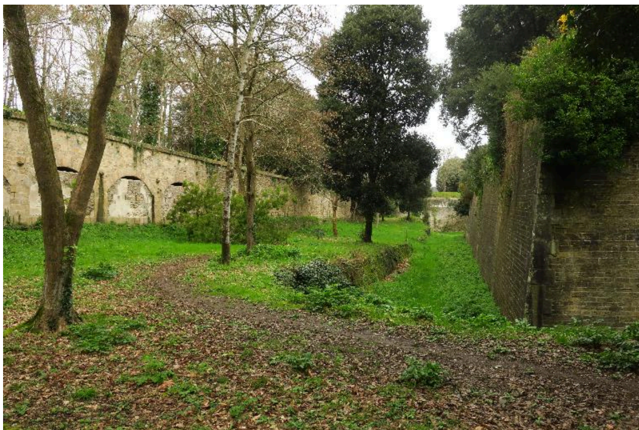
Le Palais, enceinte urbaine, bastion 21, face droite.
