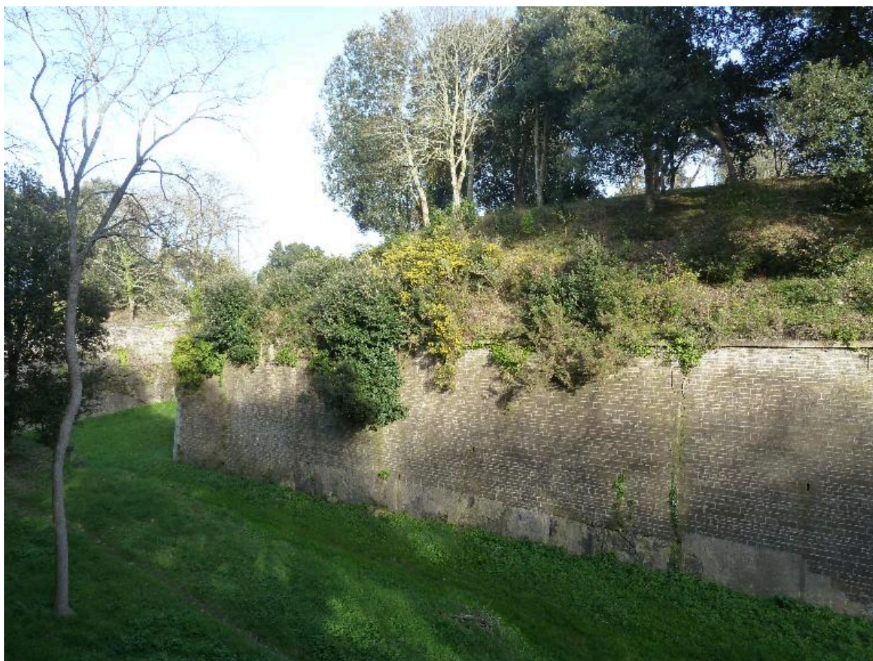
Le Palais, enceinte urbaine, bastion 21, face gauche.
