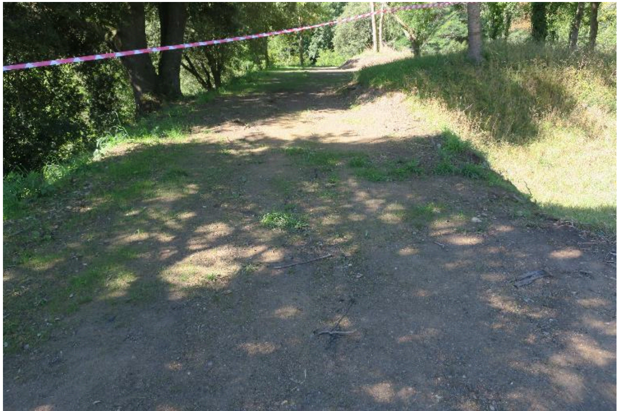
Le Palais, enceinte urbaine, bastion 21, parapet et embrasure arasés (août 2017).
