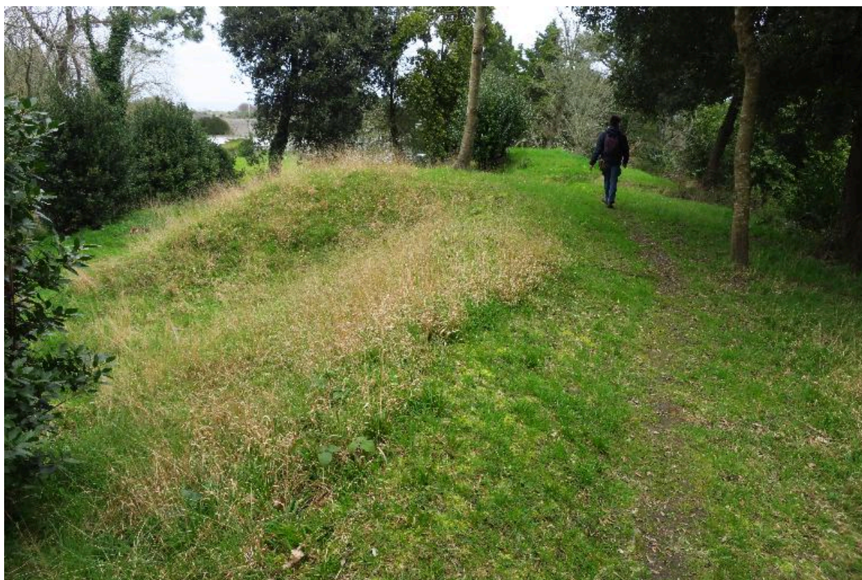
Le Palais, enceinte urbaine, bastion 21, parapet et traverses (mars 2017).
