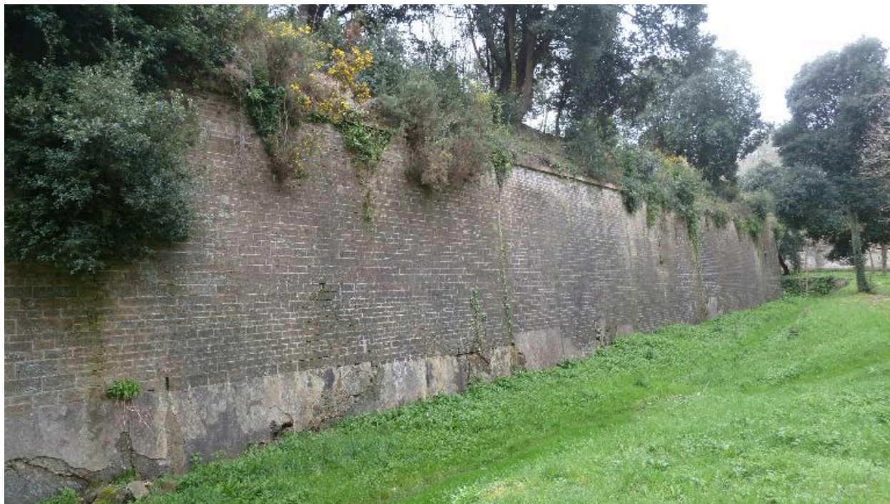
Le Palais, enceinte urbaine, bastion 21, face droite.
