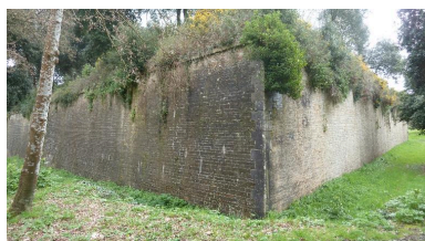
Le Palais, enceinte urbaine, bastion 21, faces et saillant. Phot. Patrick Jadé IVR53_20175608349NUCA
