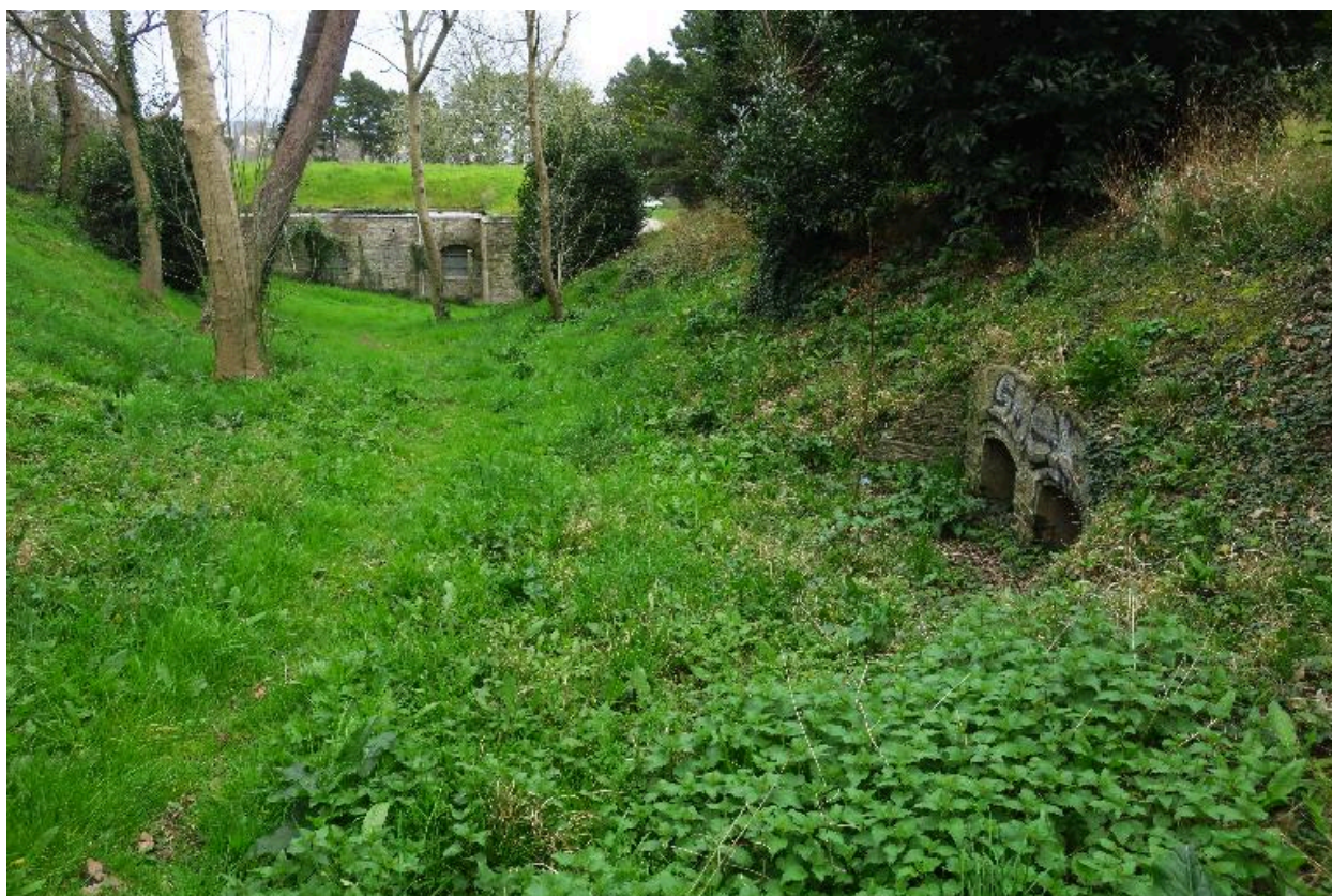
Le Palais, enceinte urbaine, bastion 21, rampe d'accès.
