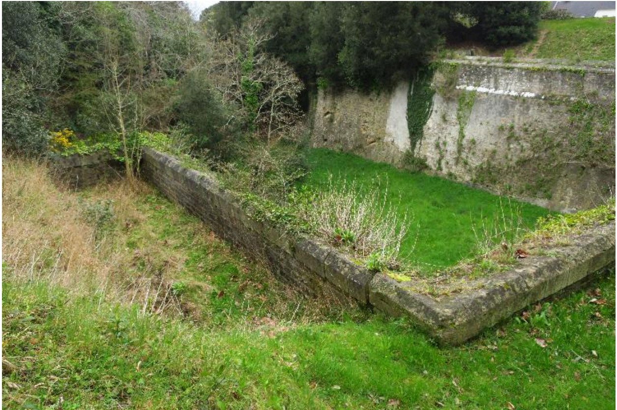
Le Palais, enceinte urbaine, bastion 21, face droite, jonction avec la courtine 21-22, parapet d'infanterie en mur à bahut.
