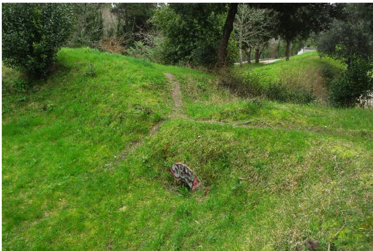
Le Palais, enceinte urbaine, bastion 21, plate-forme d'artillerie, niche à munitions et vestiges d'embrasure (mars 2017).
