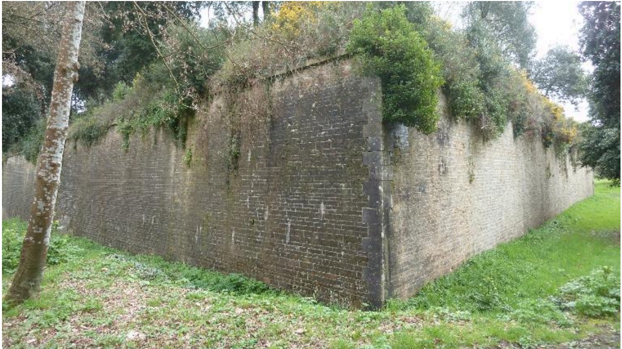
Le Palais, enceinte urbaine, bastion 21, faces et saillant.
