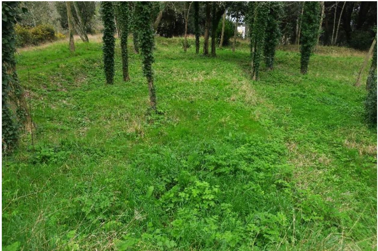
Le Palais, enceinte urbaine, bastion 21, terre-plein.
