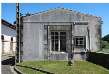
Vue du deuxième étage au niveau du pignon ouest (état en 2022) Phot. Guillaume Lécueillier IVR53_20222905813NUCA
