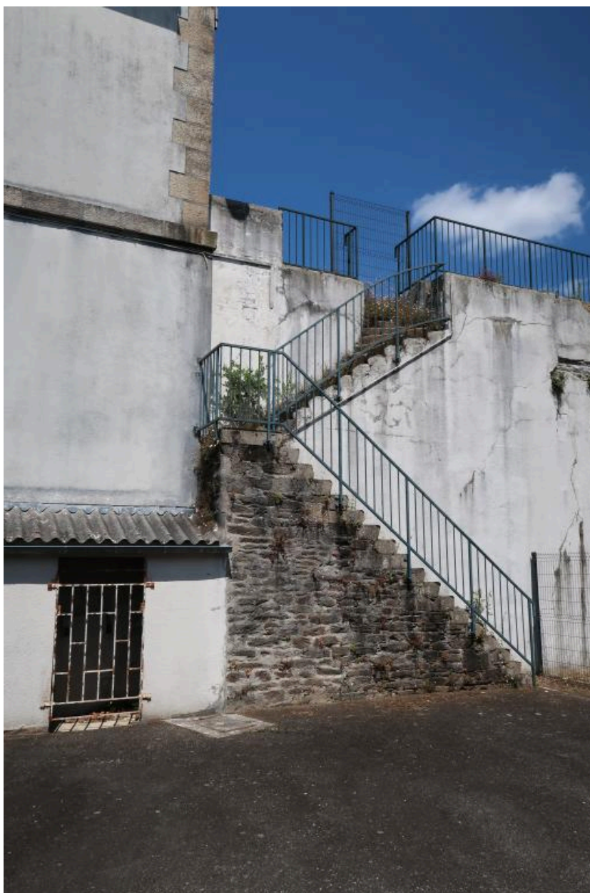
Vue de l'extrémité est : escalier (état en 2022)
