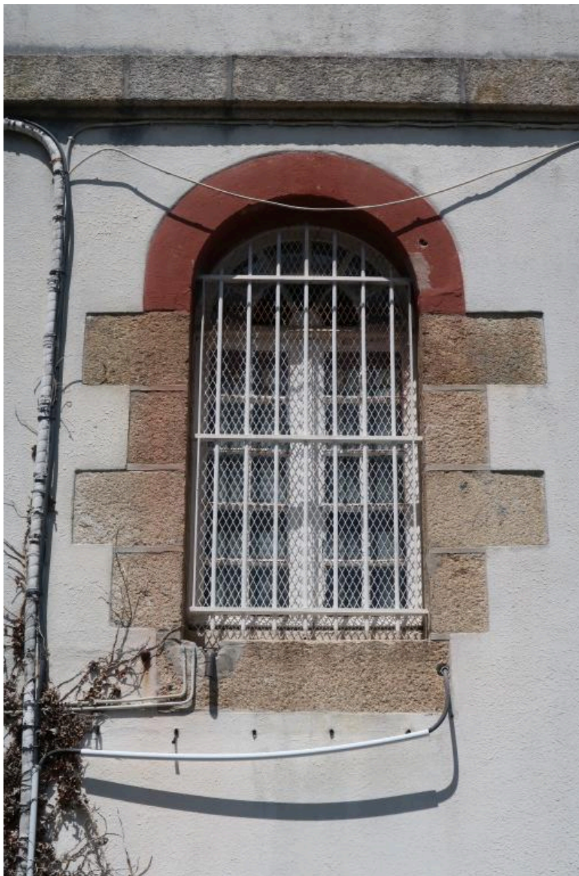
Vue de l'une des fenêtres avec linteau en arc plein cintre, grille et barreaux (état en 2022)
