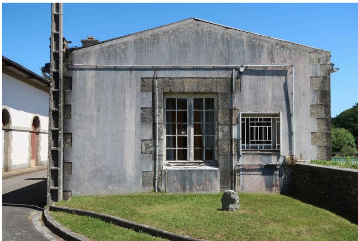
Vue du deuxième étage au niveau du pignon ouest (état en 2022)
