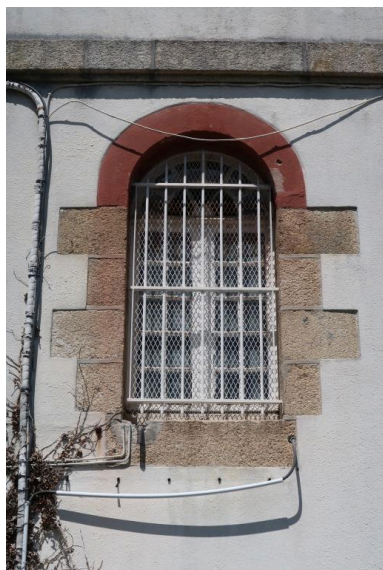
Vue de l'une des fenêtres avec linteau en arc plein cintre, grille et barreaux (état en 2022) Phot. Guillaume Lécueillier IVR53_20222905812NUCA
