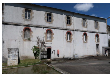
Vue générale : élévation sud (état en 2022). Au premier étage, fenêtres à linteau en arc segmentaire ; au deuxième étage, fenêtres à linteau droit ; entre les premier et deuxième étages, bandeau en granite Phot. Guillaume Lécueillier IVR53_20222905807NUCA
