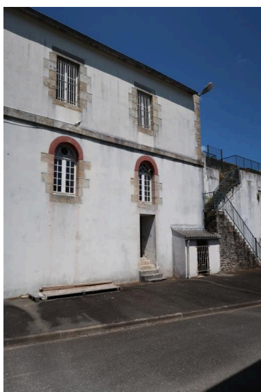
Vue de l'extrémité est : élévation sud (état en 2022). Au premier étage,
