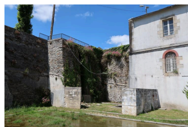
Vue de l'extrémité ouest faisant face à la digue de l'étang (état en 2022). Au premier étage, fenêtres à linteau en arc segmentaire ; au deuxième étage, fenêtres à linteau droit et chaînage d'angle en granite ; entre les premier et deuxième étages, bandeau en granite Phot. Guillaume Lécueillier IVR53_20222905811NUCA
