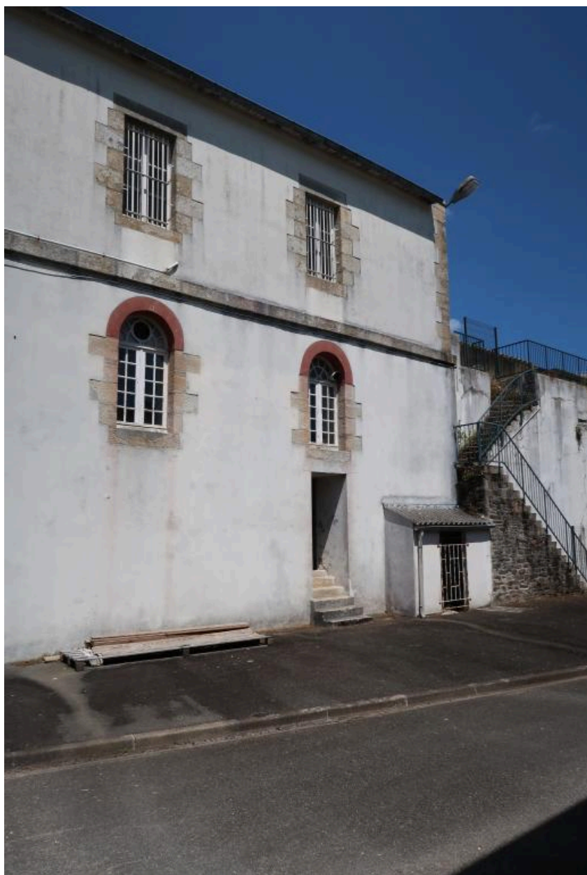
Vue de l'extrémité est : élévation sud (état en 2022). Au premier étage, fenêtres à linteau en arc segmentaire ; au deuxième étage, fenêtres à linteau droit ; entre les premier et deuxième étages, bandeau en granite
