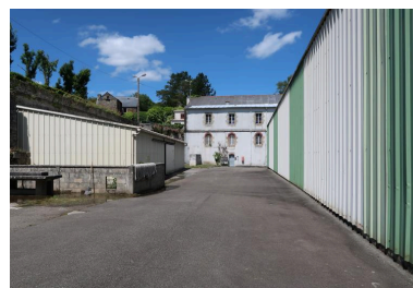
Vue de situation depuis le sud : le bâtiment est implanté perpendiculairement à la digue de l'étang (état en 2022) Phot. Guillaume Lécueillier IVR53_20222905806NUCA
