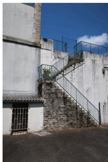
Vue de l'extrémité est : escalier (état en 2022)
