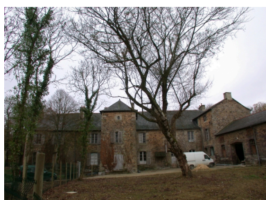
Vue générale de la façade arrière Phot. Guillaume Lécueillier IVR53_20033515678NUCA
