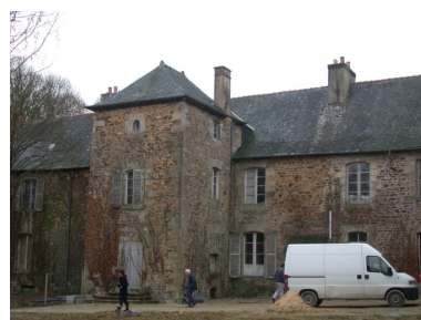
Vue rapprochée de la façade arrière Phot. Guillaume Lécueillier IVR53_20033515673NUCA
