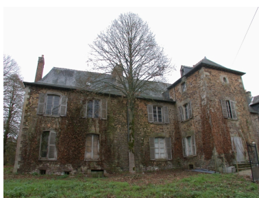
Vue générale de la façade arrière Phot. Guillaume Lécueillier IVR53_20033515674NUCA
