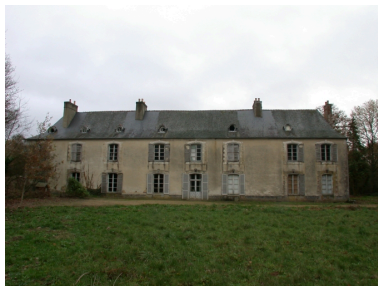
Vue générale de la façade avant Phot. Guillaume Lécueillier IVR53_20033515677NUCA
