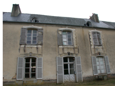
Façade avant, travées centrales du logis Phot. Guillaume Lécueillier IVR53_20033515681NUCA
