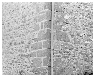
Logis : détail d'harpes de pierre à un angle de la façade. Phot. Guy Artur, Phot. Norbert Lambart IVR53_19922200093X
