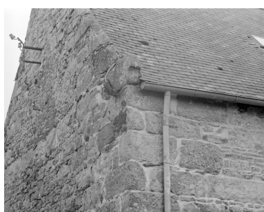
Logis : détail d'harpes de pierre à un angle de la façade. Phot. Guy Artur, Phot. Norbert Lambart IVR53_19922200094X
