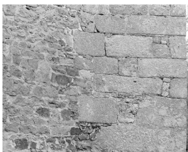
Logis : détail d'harpes de pierre à un angle de la façade. Phot. Guy Artur, Phot. Norbert Lambart IVR53_19922200096X
