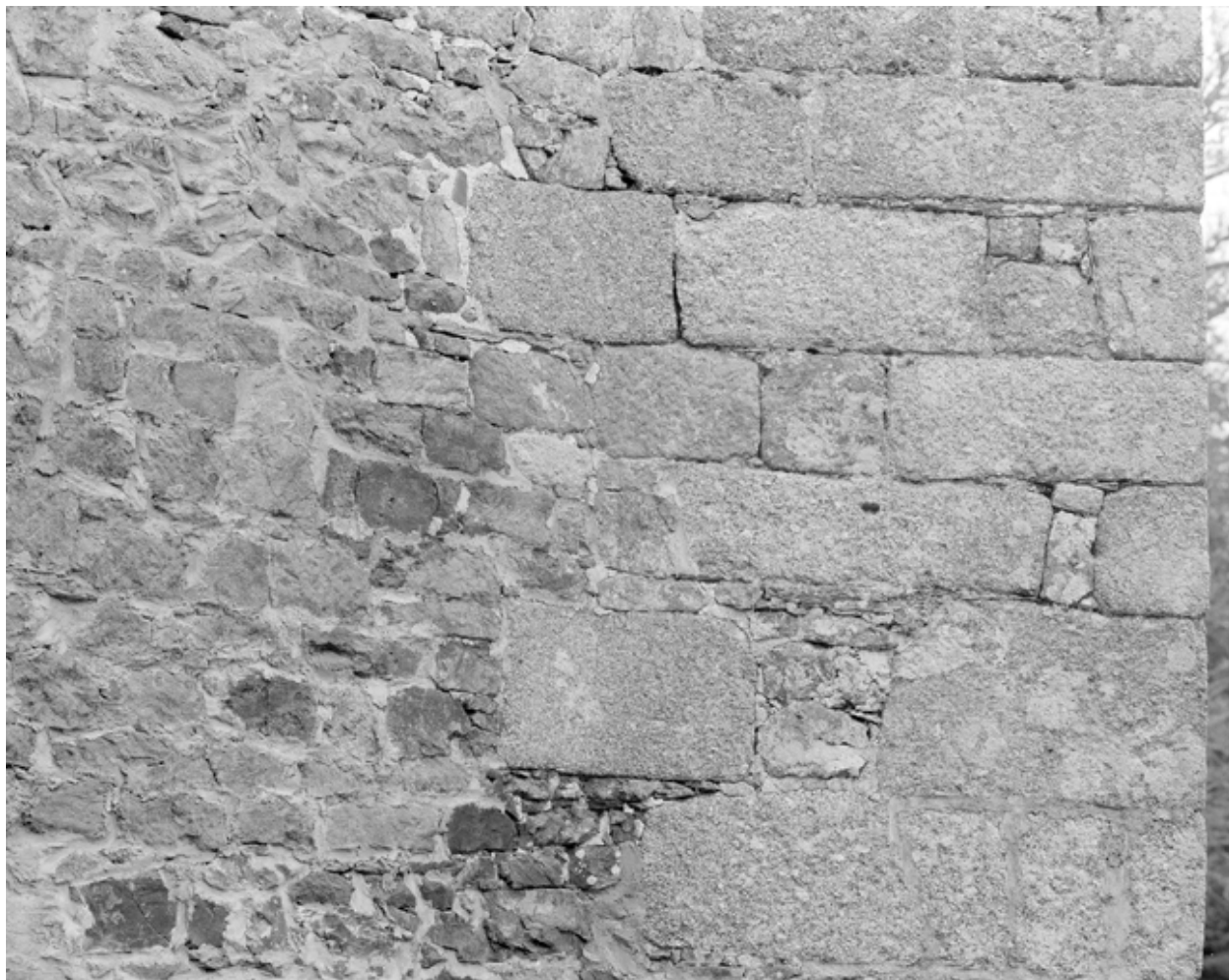
Logis : détail d'harpes de pierre à un angle de la façade.
