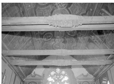
Entraits engoulés à l'est. Phot. Brachet IVR53_19665600973V
