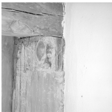
Sablière, détail d'un motif sur le mur sud. Phot. Brachet IVR53_19665600983X
