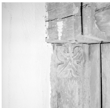
Sablières, détail d'un motif sur le mur sud. Phot. Brachet IVR53_19665600982X
