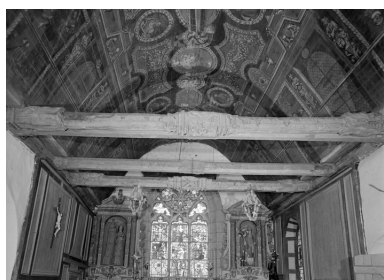
Entraits engoulés à l'est. Phot. Brachet IVR53_19665600972V
