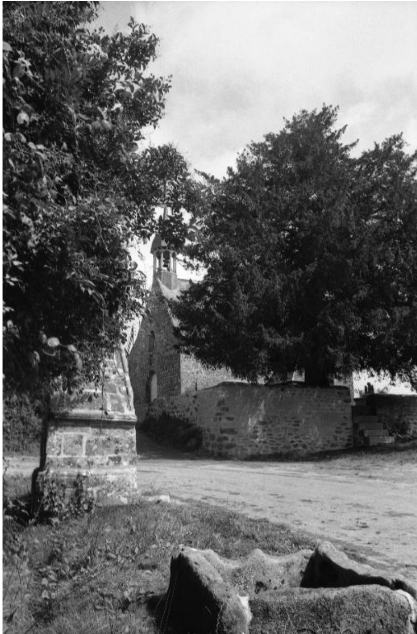
Vue de situation prise du sud-ouest.
