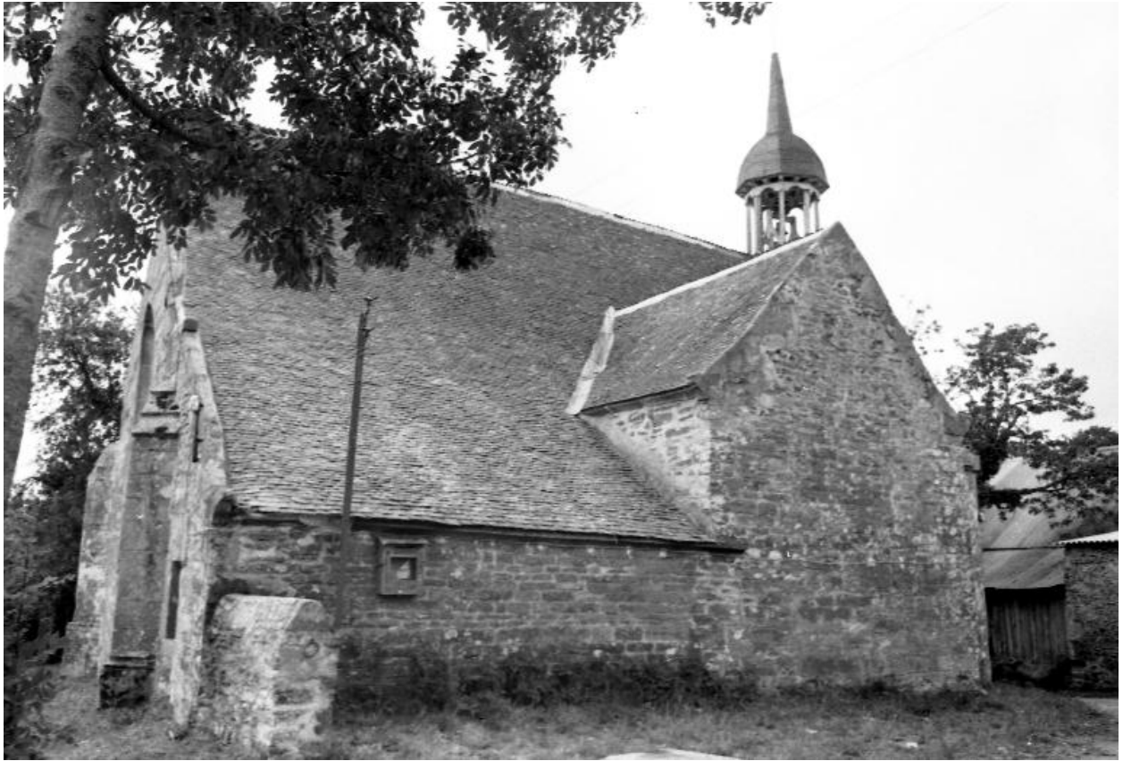
Vue d'ensemble de la façade nord.
