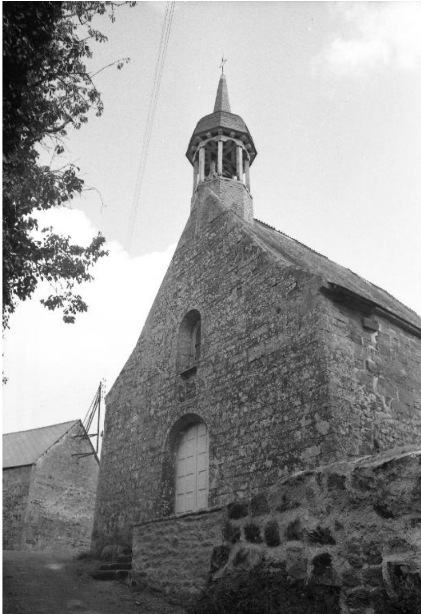
Vue d'ensemble de la façade ouest.
