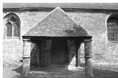
Elévation du porche sur la façade sud. Phot. Gérard Lefort IVR53_19665600732Z
