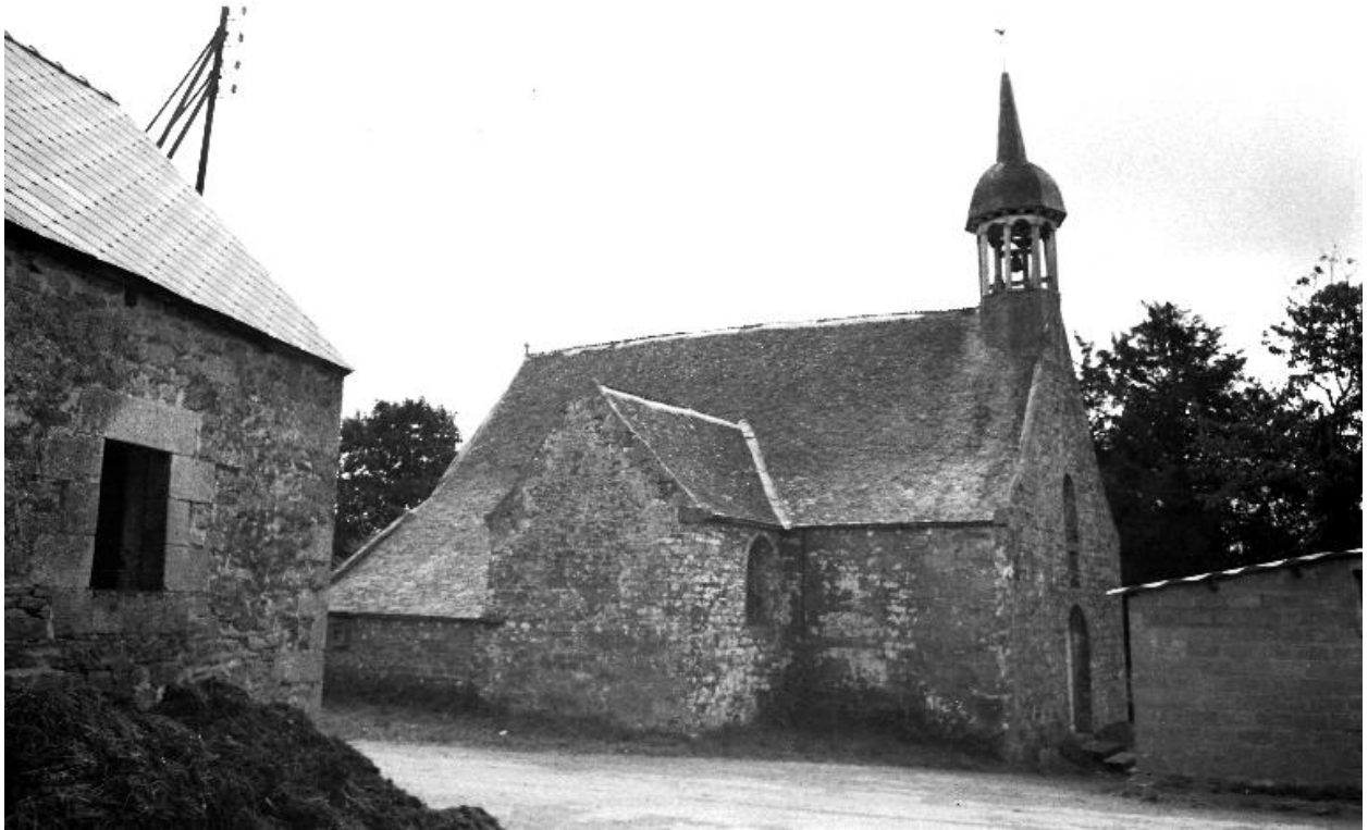
Vue de situation prise du nord.
