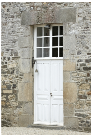
Détail, porte d'entrée Phot. Rozenn Turni IVR53_20102203302NUCA
