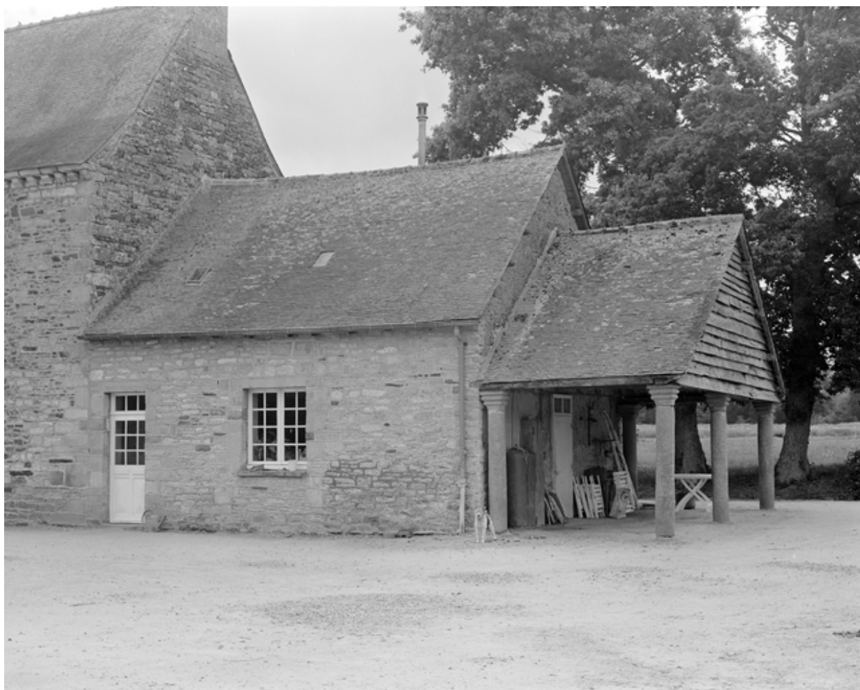
Hangar à colonnes
