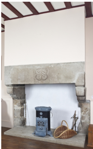
Cheminée du rez-de-chaussée Phot. Rozenn Turni IVR53_20102203312NUCA
