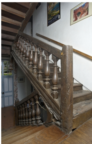
Escalier dans oeuvre en charpente Phot. Rozenn Turni IVR53_20102203315NUCA
