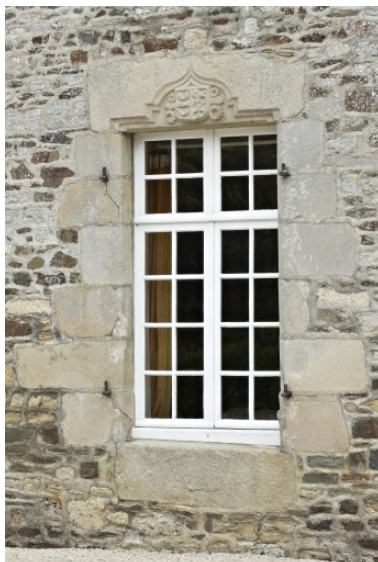
Fenêtre du rez-de-chaussée avec linteau remployé Phot. Rozenn Turni IVR53_20102203304NUCA
