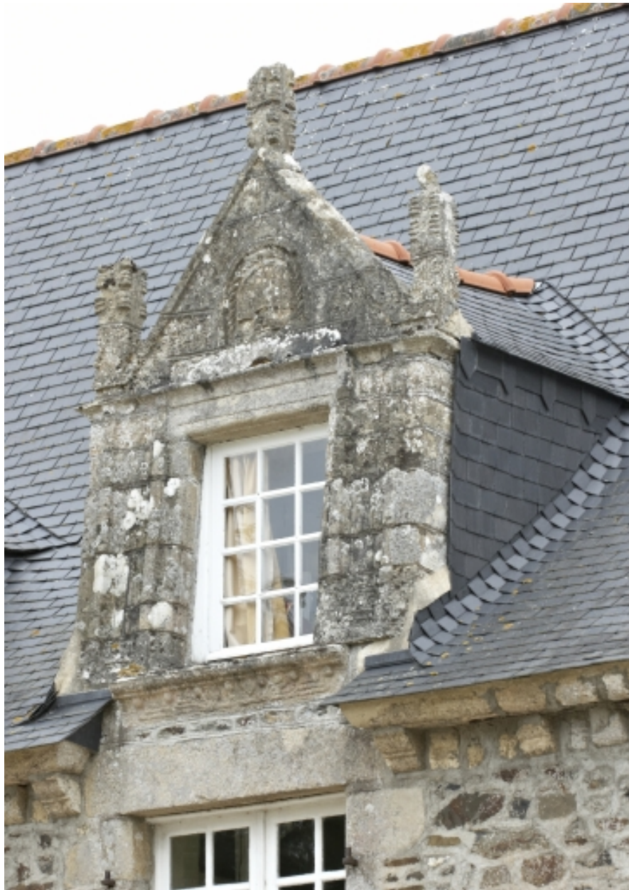
Détail, lucarne à droite de la travée centrale
