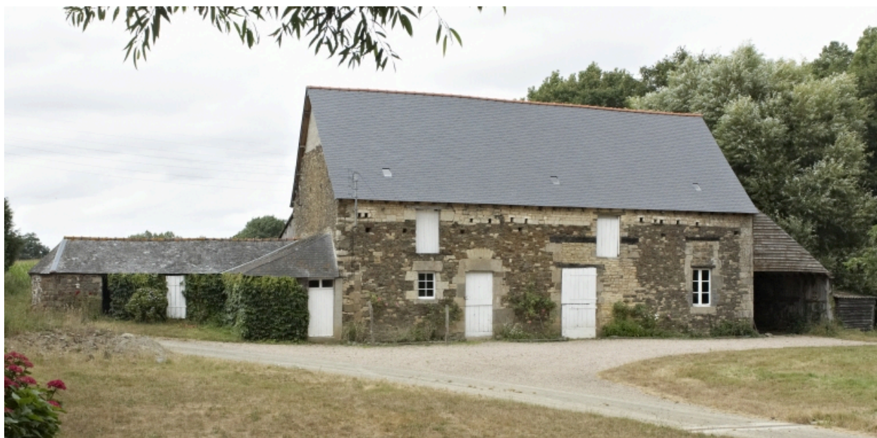
Vue générale de la grange
