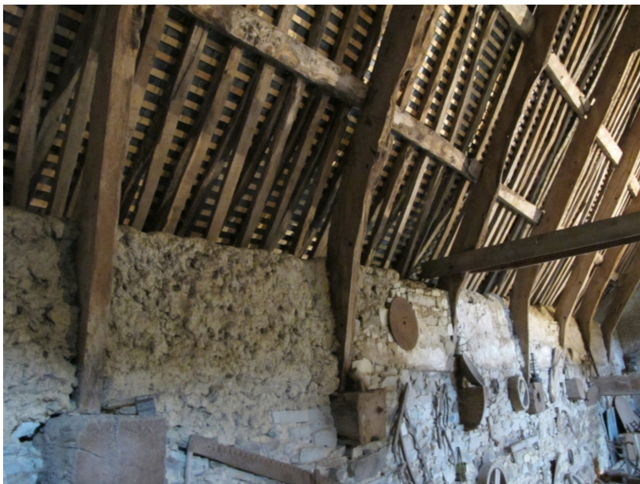
La grange, détail de la charpente
