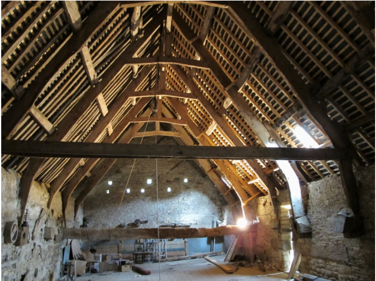
La grange, vue intérieure de la charpente
