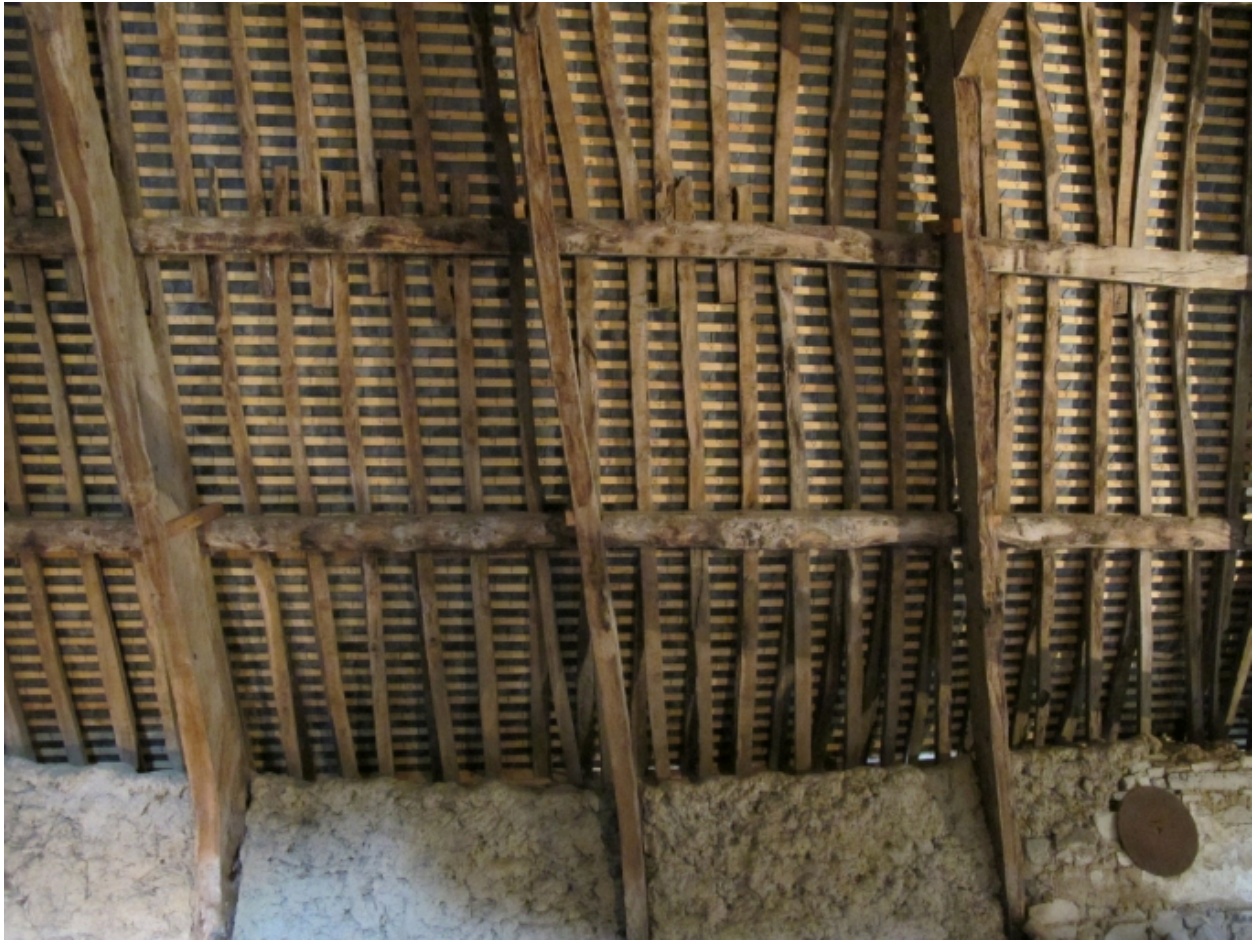
La grange, détail de la charpente
