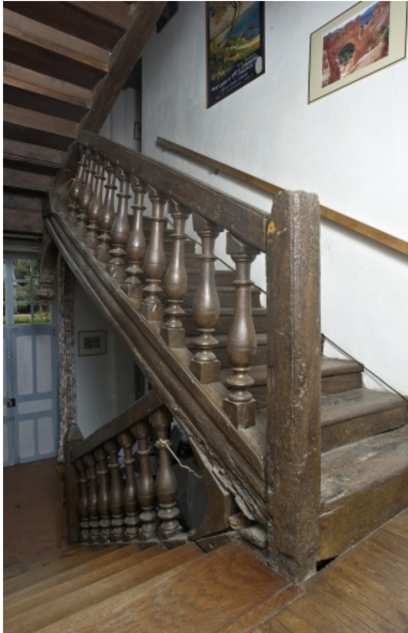
Escalier dans oeuvre en charpente
