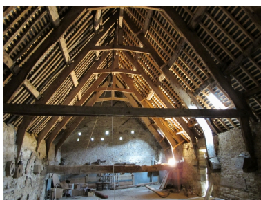
La grange, vue intérieure de la charpente Phot. Véronique Orain IVR53_20102211880NUCA
