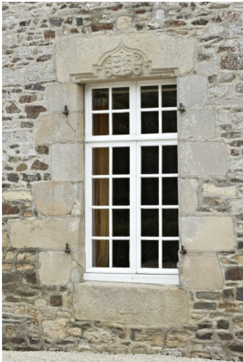
Fenêtre du rez-de-chaussée avec linteau remployé
