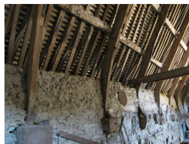
La grange, détail de la charpente Phot. Véronique Orain IVR53_20102211891NUCA
