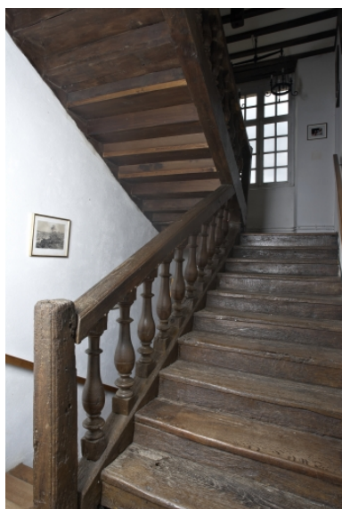
Escalier dans oeuvre en charpente Phot. Rozenn Turni IVR53_20102203314NUCA
