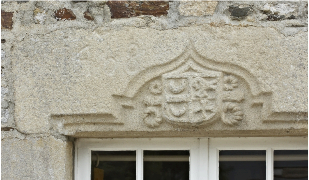
Fenêtre du rez-de-chaussée, détail du linteau, armoiries et date portée de 1468
