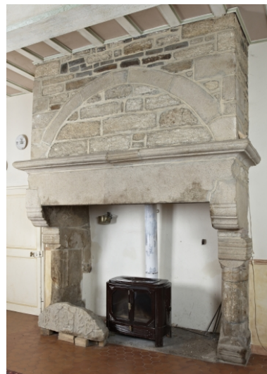
Cheminée du rez-de-chaussée Phot. Rozenn Turni IVR53_20102203310NUCA
