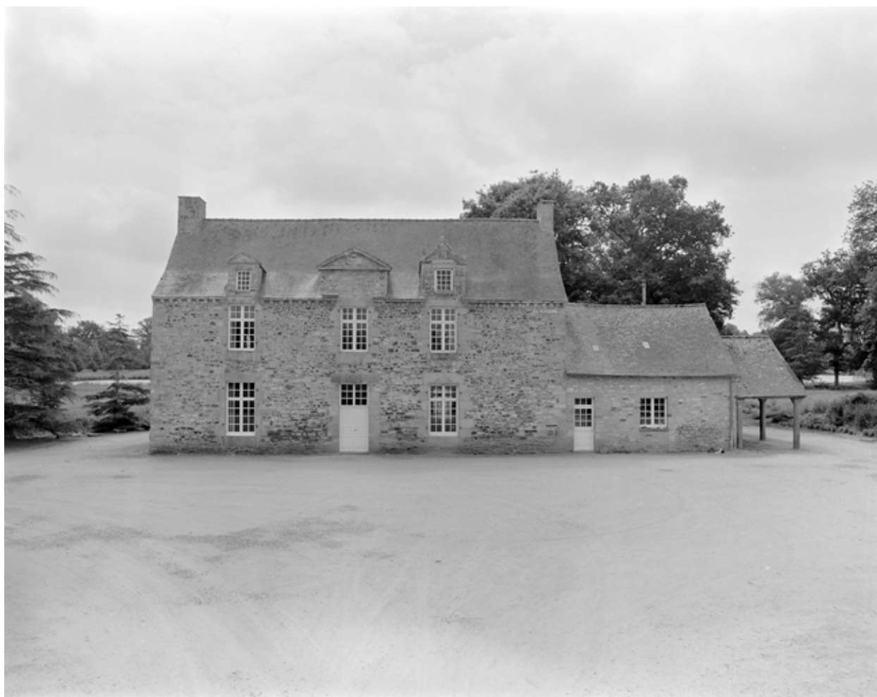
Vue générale façade nord
