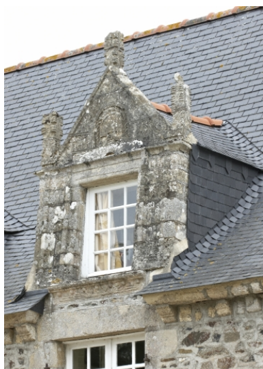
Détail, lucarne à droite de la travée centrale Phot. Rozenn Turni IVR53_20102203306NUCA
