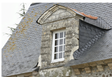
Détail, lucarne à gauche de la travée centrale Phot. Rozenn Turni IVR53_20102203301NUCA
