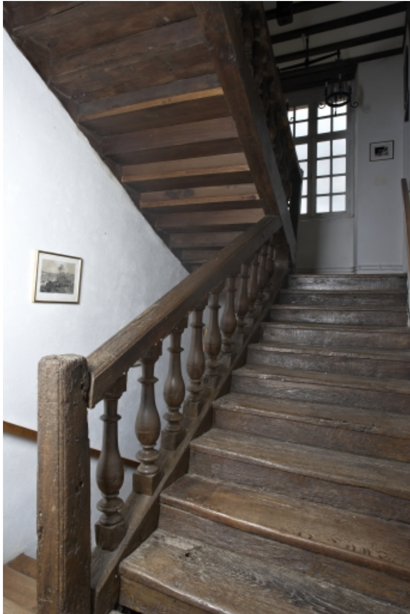
Escalier dans oeuvre en charpente
