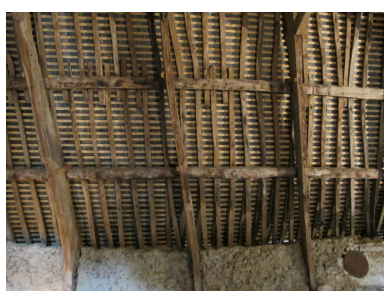
La grange, détail de la charpente Phot. Véronique Orain IVR53_20102211892NUCA
