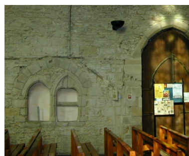
Nef, mur nord, détail Phot. Christel Douard IVR53_20042903278NUCA
