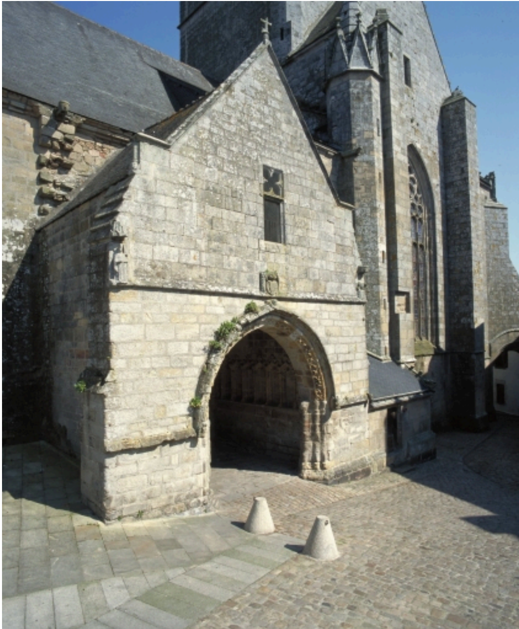
Porche sud, vue générale
