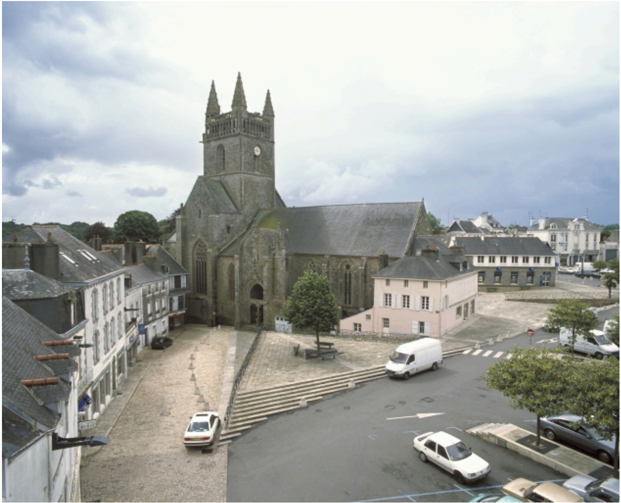
Vue de situation nord
