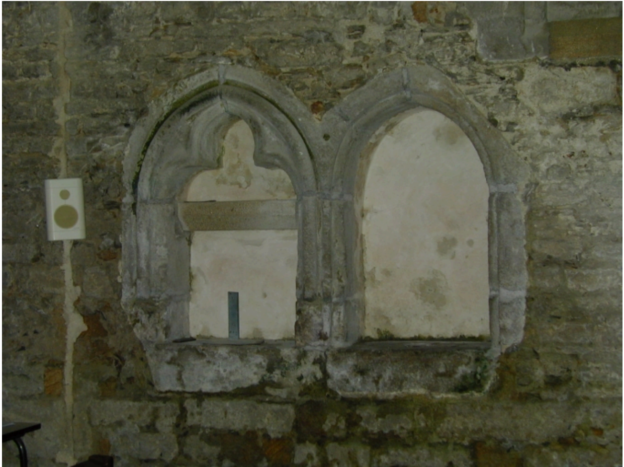
Nef, mur sud, niches et porte d'accès au porche nord
