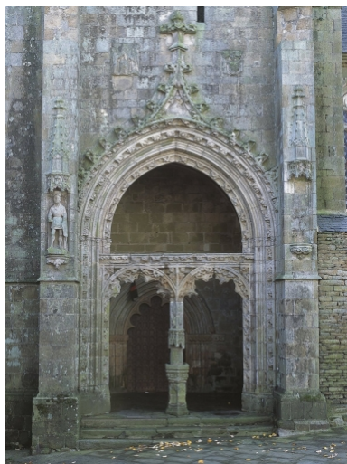
Porche nord, vue générale Phot. Bernard Bègne IVR53_20012900369XA
