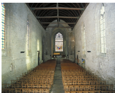
Intérieur, vue axiale est Phot. Bernard Bègne IVR53_20012900424XA
