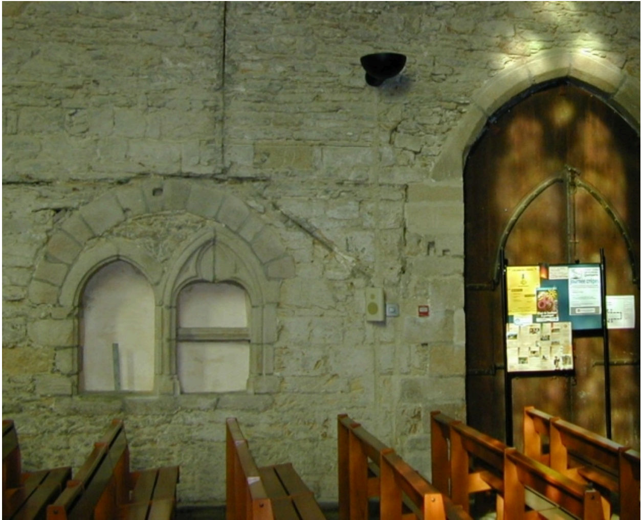
Nef, mur nord, détail
