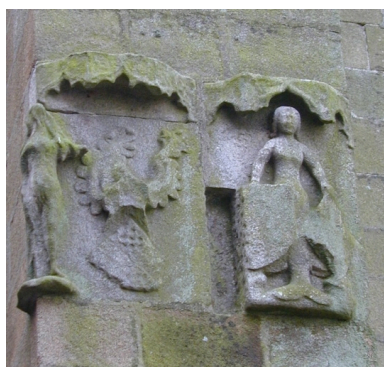
Élévation nord, contrefort est, détail sculpté Phot. Christel Douard IVR53_20042903273NUCA
