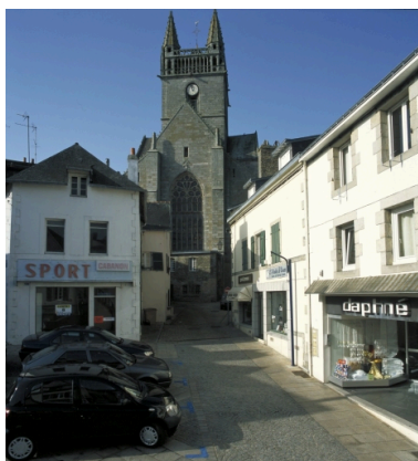
Elévation est, vue générale Phot. Bernard Bègne IVR53_20012900361XA
