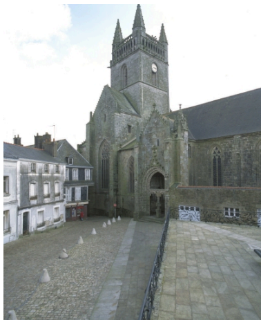
Elévation nord, partie est Phot. Bernard Bègne IVR53_20022900191XA
