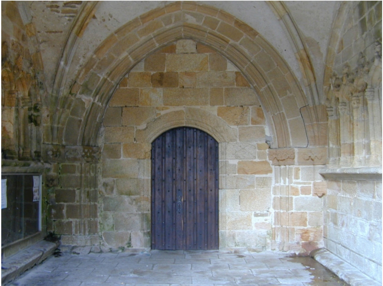
Porche sud, porte d'accès à la nef
