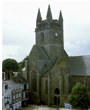
Elévation nord, partie est Phot. Bernard Bègne IVR53_20022900426XA
