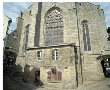
Elévation est, détail du chevet et de la sacristie Phot. Bernard Bègne IVR53_20012900109XA
