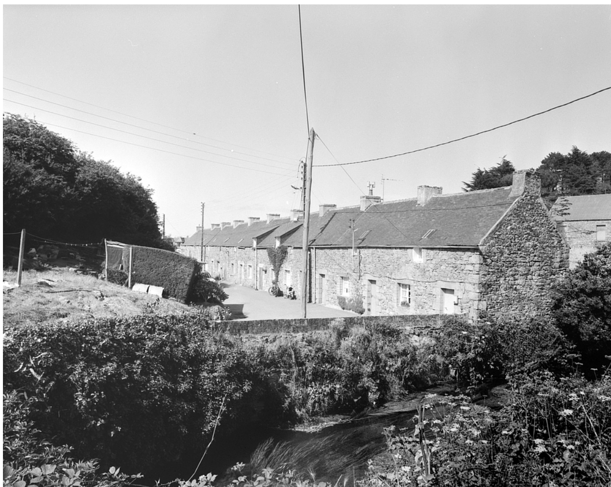
Maison d'ouvriers, vue générale sud-ouest
