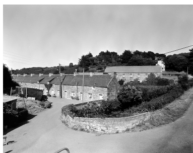
Maison d'ouvriers, vue de situation prise du sud-ouest Phot. Bernard Bègne IVR53_19852901340X
