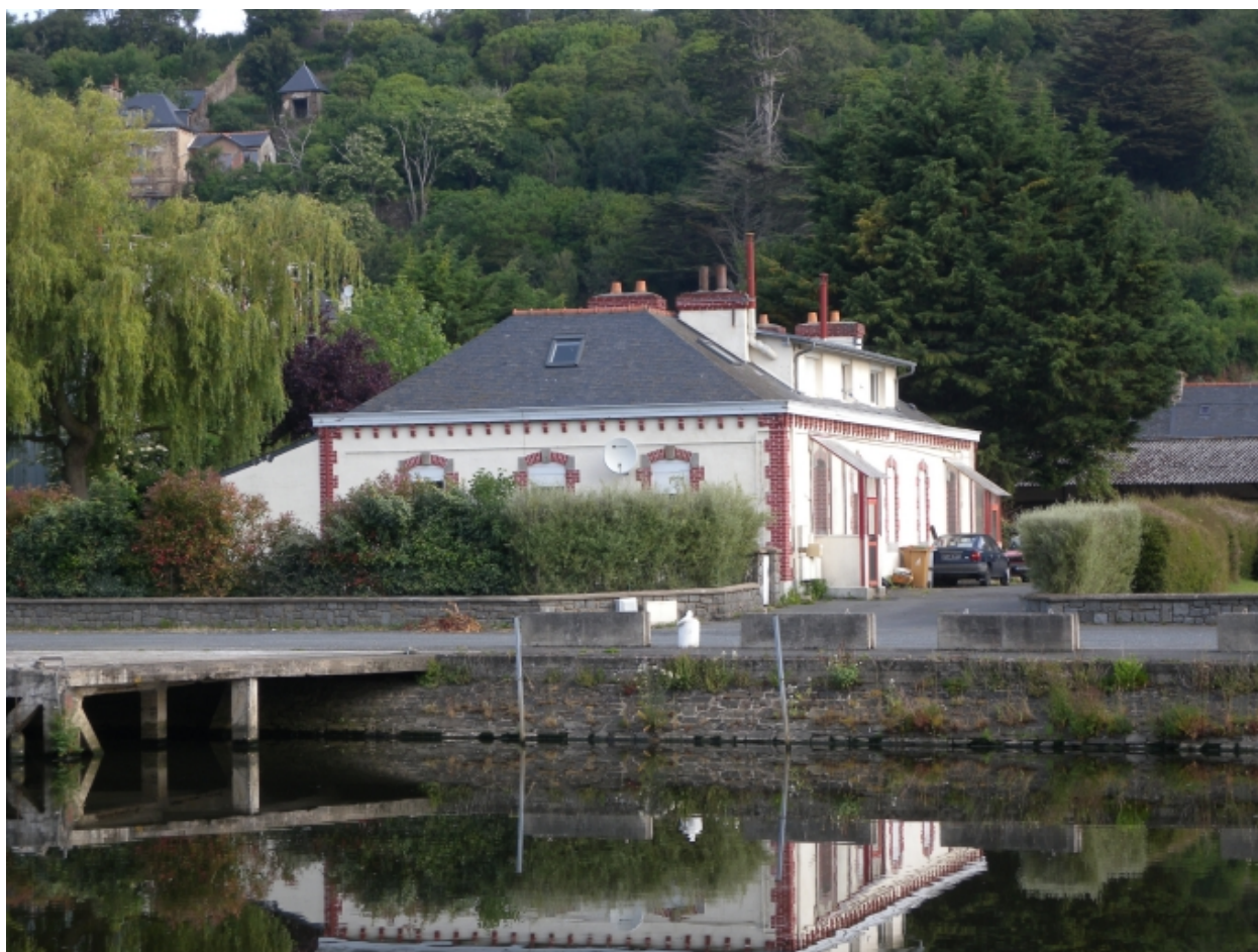
Vue générale de la façade Nord
