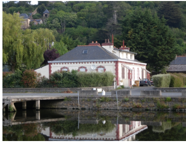
Vue générale de la façade Nord Phot. Guy Prigent IVR53_20082213156NUCA
