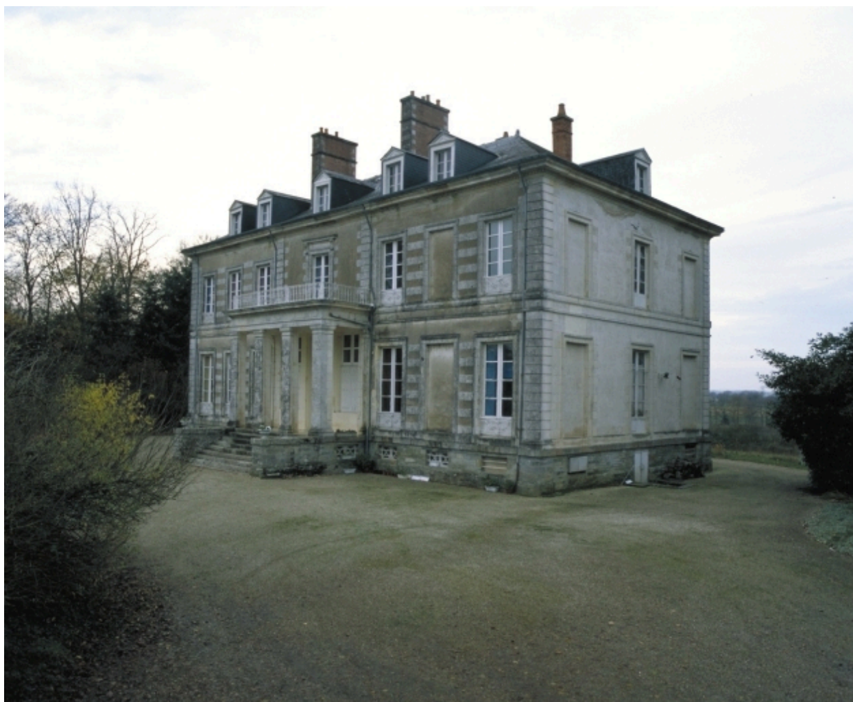
Vue générale sud-est : façade antérieure
